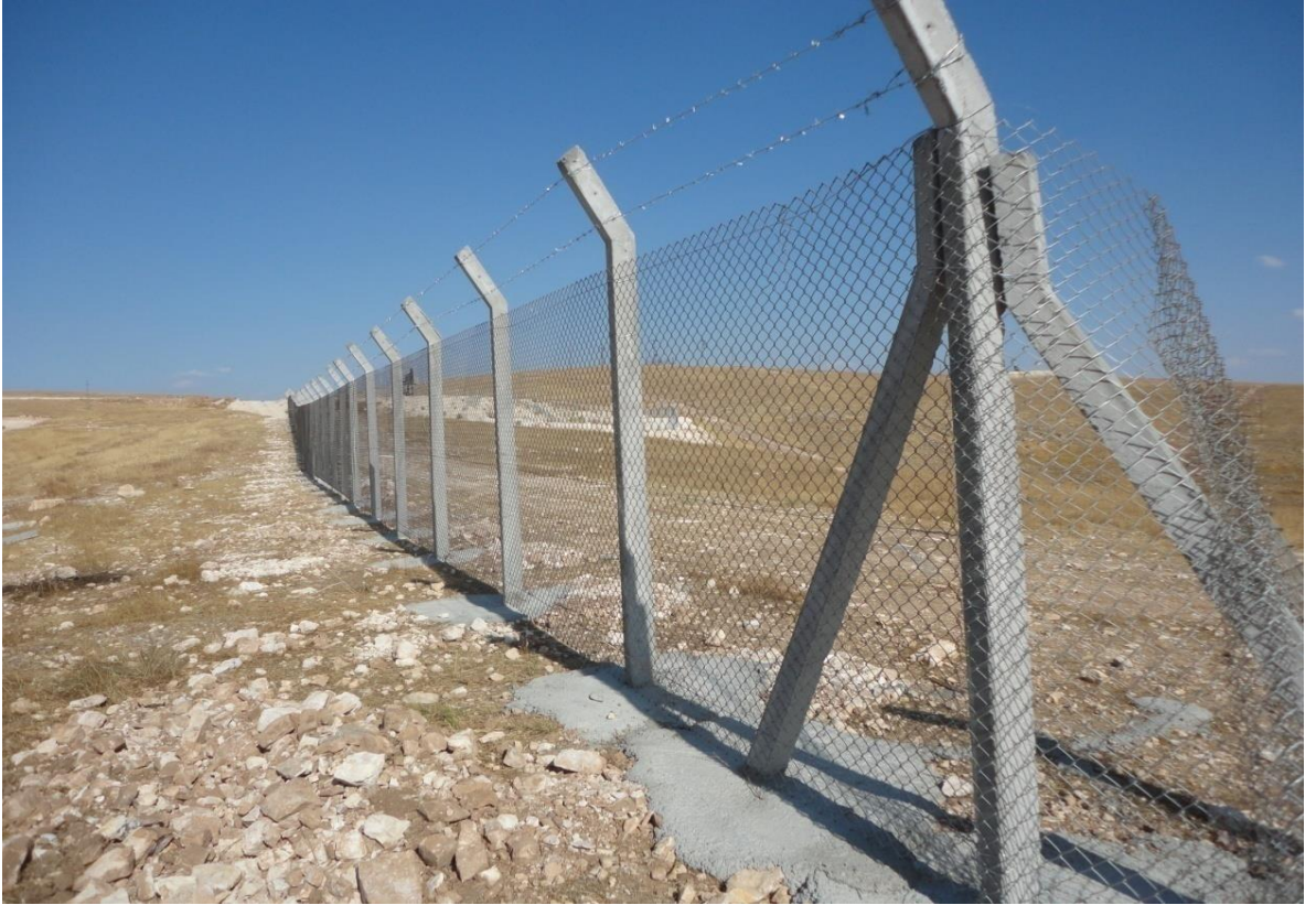
Beton Direkli Kafes Tel ve Helezonlu Jiletli Tel ile Çit Yapım İşi
