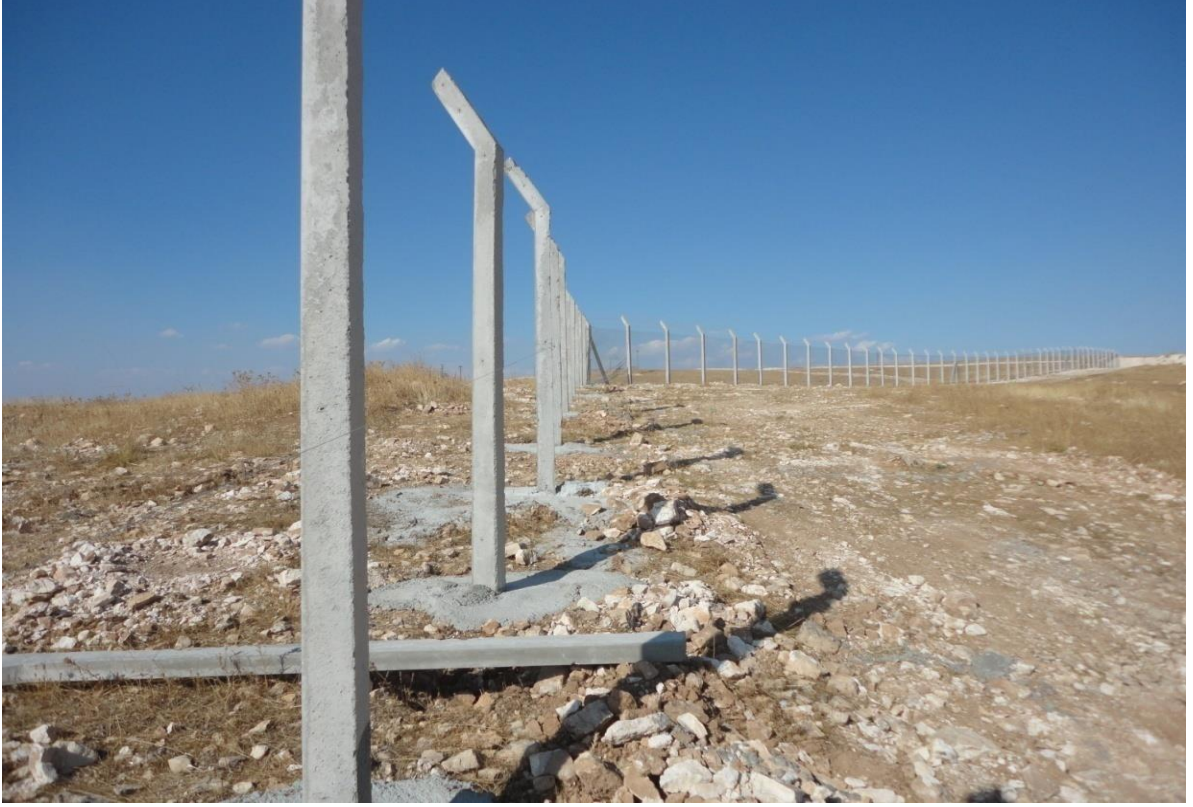
Beton Direkli Kafes Tel ve Helezonlu Jiletli Tel ile Çit Yapım İşi
