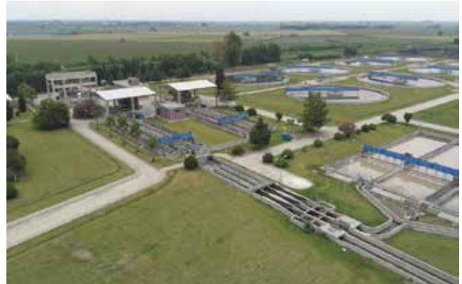
Seyhan Atıksu Arıtma Tesisi
