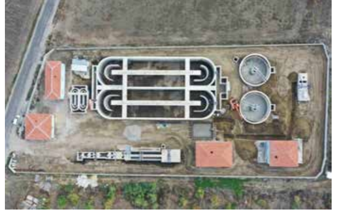
İmamoğlu Atıksu Arıtma Tesisi
