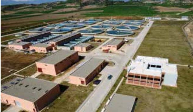
Çatalan İçmesuyu Arıtma Tesisi
