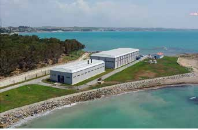
Karataş Atıksu Arıtma Tesisi
