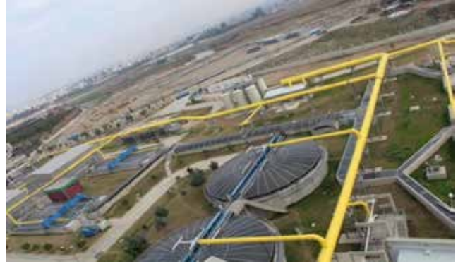
Yüreğir Atıksu Arıtma Tesisi
