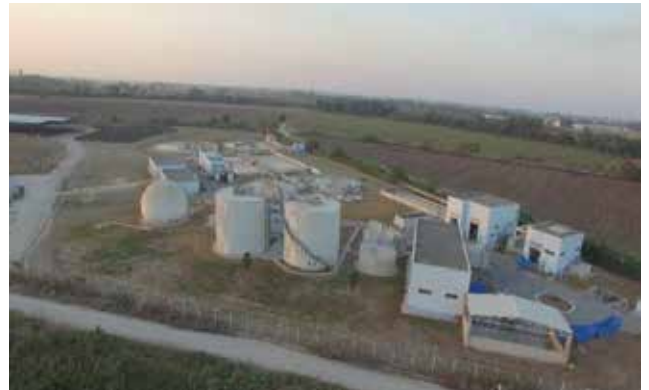
Ceyhan Atıksu Arıtma Tesisi
