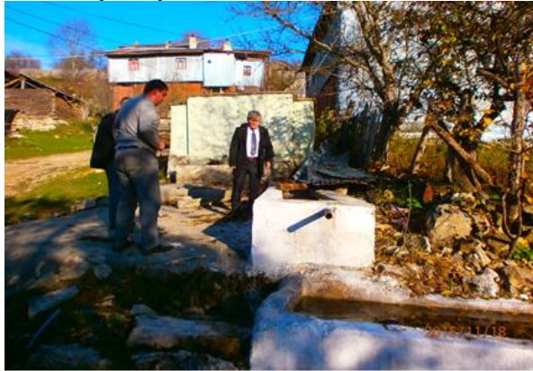
Aday Köyü / Çeşme Bakım Onarımı
