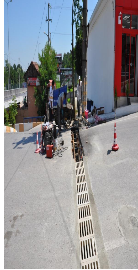
Yağmursuyu ızgara yapımı
