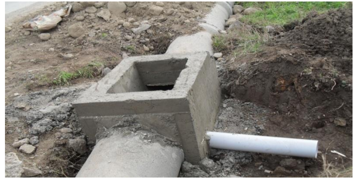
Yağmursuyu menfez yapımı
