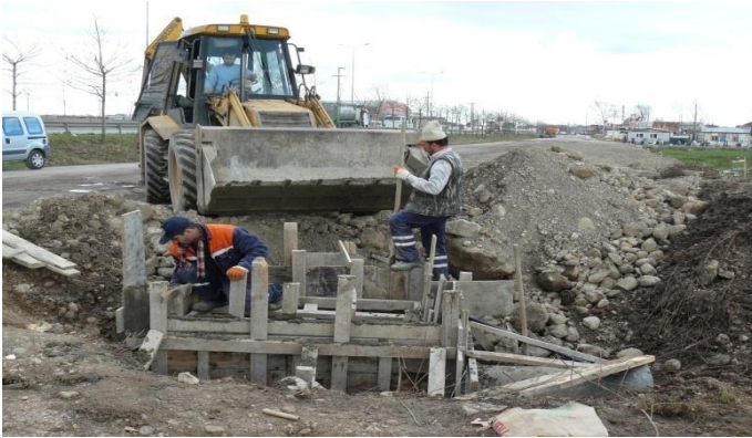
Yağmursuyu rögar yapımı
