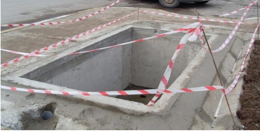
Yer altı çöp konteynır yeri yapımı
