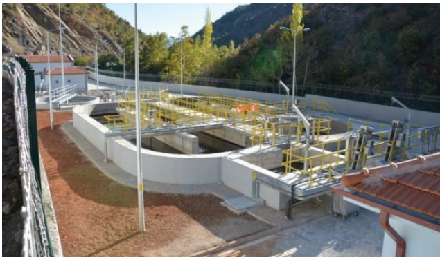
Saimbeyli Atıksu Arıtma Tesisi
