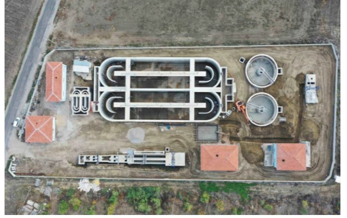
İmamoğlu Atıksu Arıtma Tesisi
