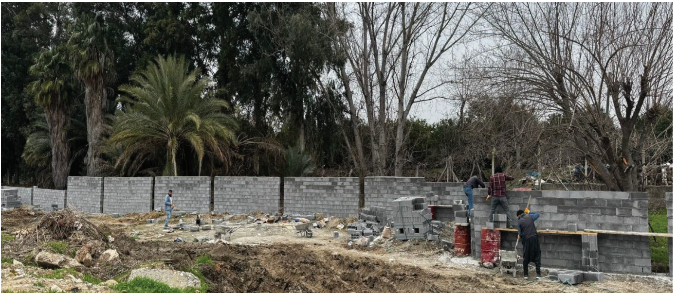
Yüreğir Atıksu Arıtma Tesis Duvar Yapım Çalışmaları
