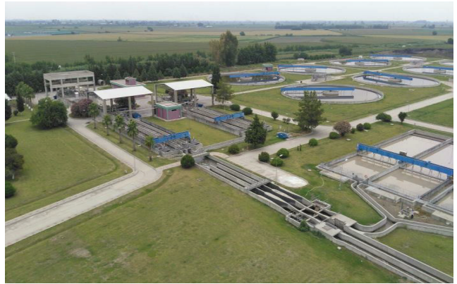
Seyhan Atıksu Arıtma Tesisi
