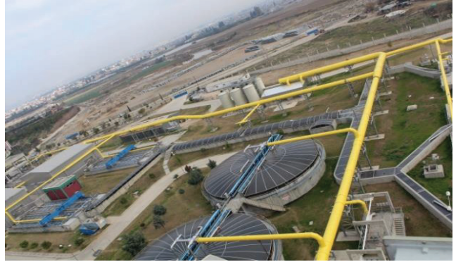
Yüreğir Atıksu Arıtma Tesisi
