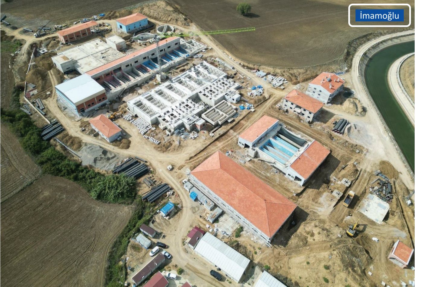
Yedigöze Arıtma Tesisi Yapım Çalışmaları
