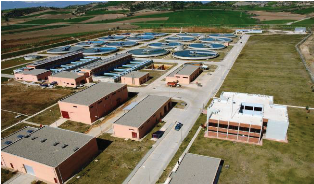
Çatalan İçmesuyu Arıtma Tesisi
