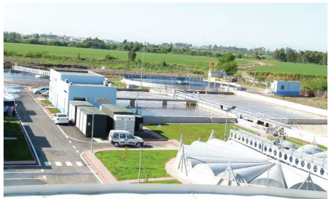
Ceyhan Atıksu Arıtma Tesisi
