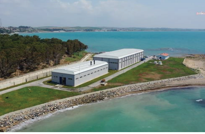
Karataş Atıksu Arıtma Tesisi
