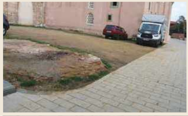
Demir Duba Uygulaması Öncesi
