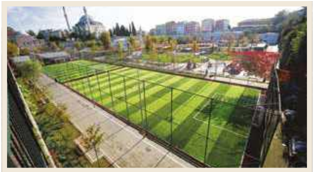
Çarşamba Çukurbostan Futbol Sahası Yeni Hali
