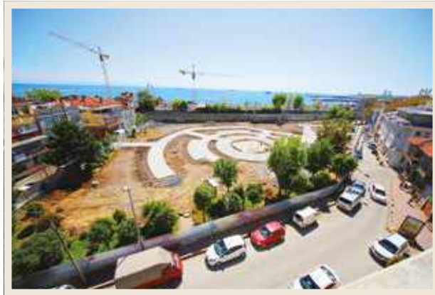
Cundi Parkı Uygulama Aşaması
