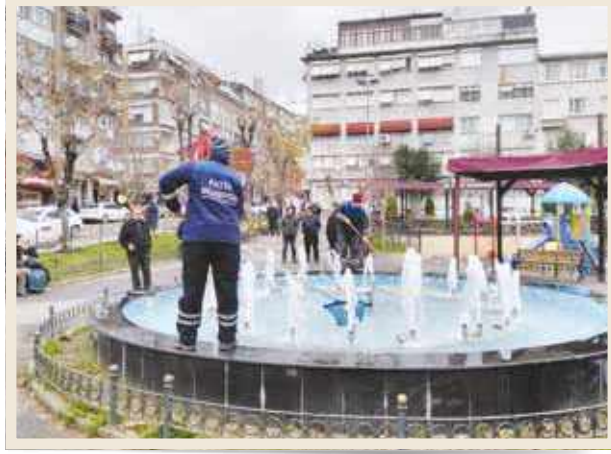
Havuz Bakım Çalışmalarımızdan Görünüm
