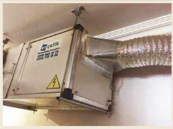
Karbon Filtre Baca Havalandırma Sistemi Uygulaması
