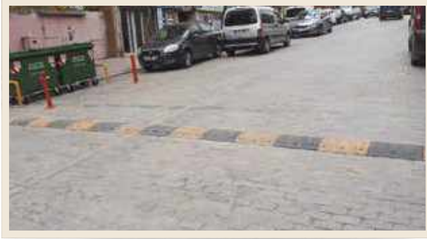
Haliç Caddesi Hız kesici Uygulaması
