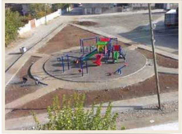
Sur İlçesi 2 Nolu Park Çalışması Yeni Hali
