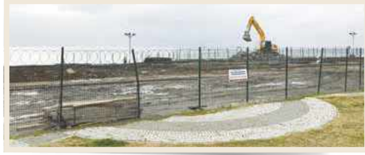
Çatladıkapı Sosyal Tesisleri Bahçesi Uygulama Öncesi
