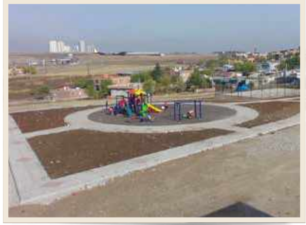
Sur İlçesi 1 Nolu Park Çalışması Yeni Hali
