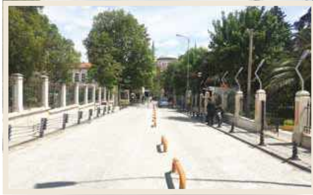
Hükümet Konağı Sokak'ta Derz Uygulaması Sonrası
