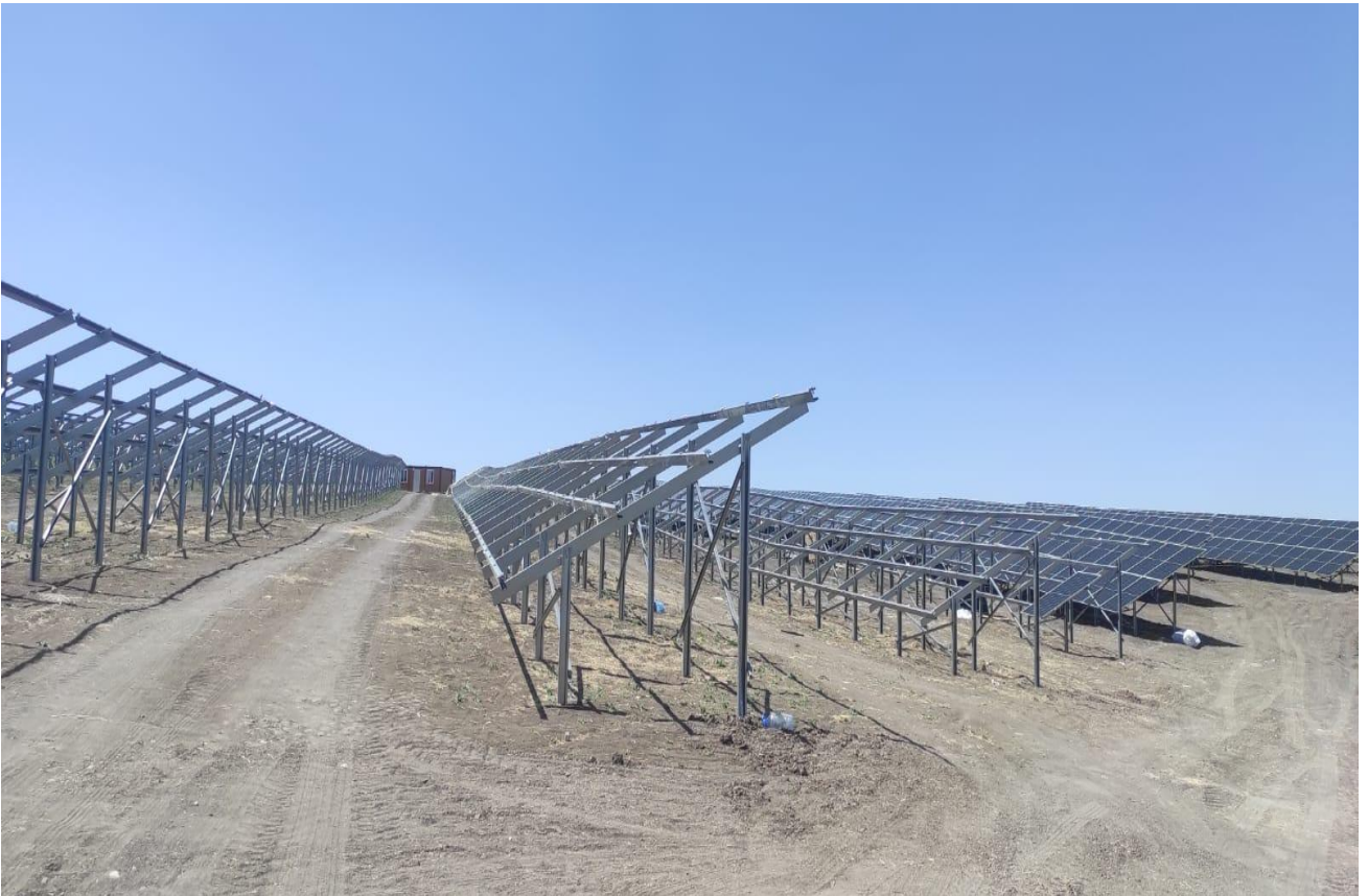
Ruhsatlı Hale Getirilen Kaçak Yapı
