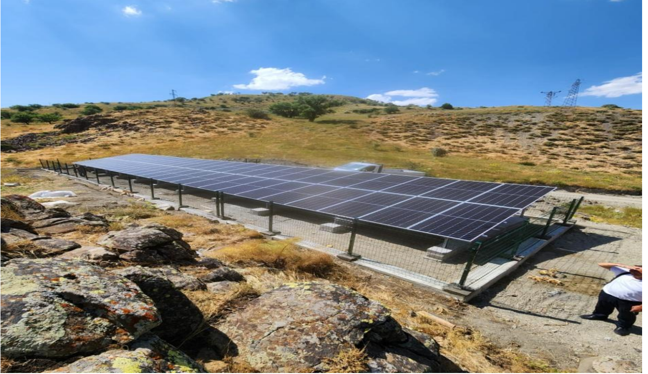
Varto Çayönü köyü güneş enerjili içme suyu tesis yapım işi
