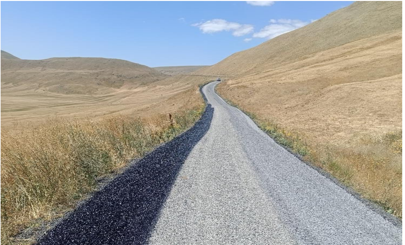
2025 yılı 1. ve 2. Kat asfalt çalışmalarımız.
