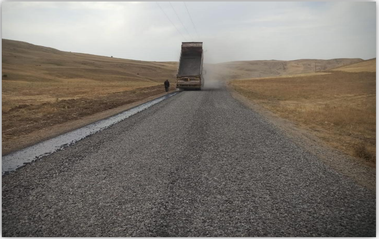
2025 yılı 1. ve 2. Kat asfalt çalışmalarımız.
