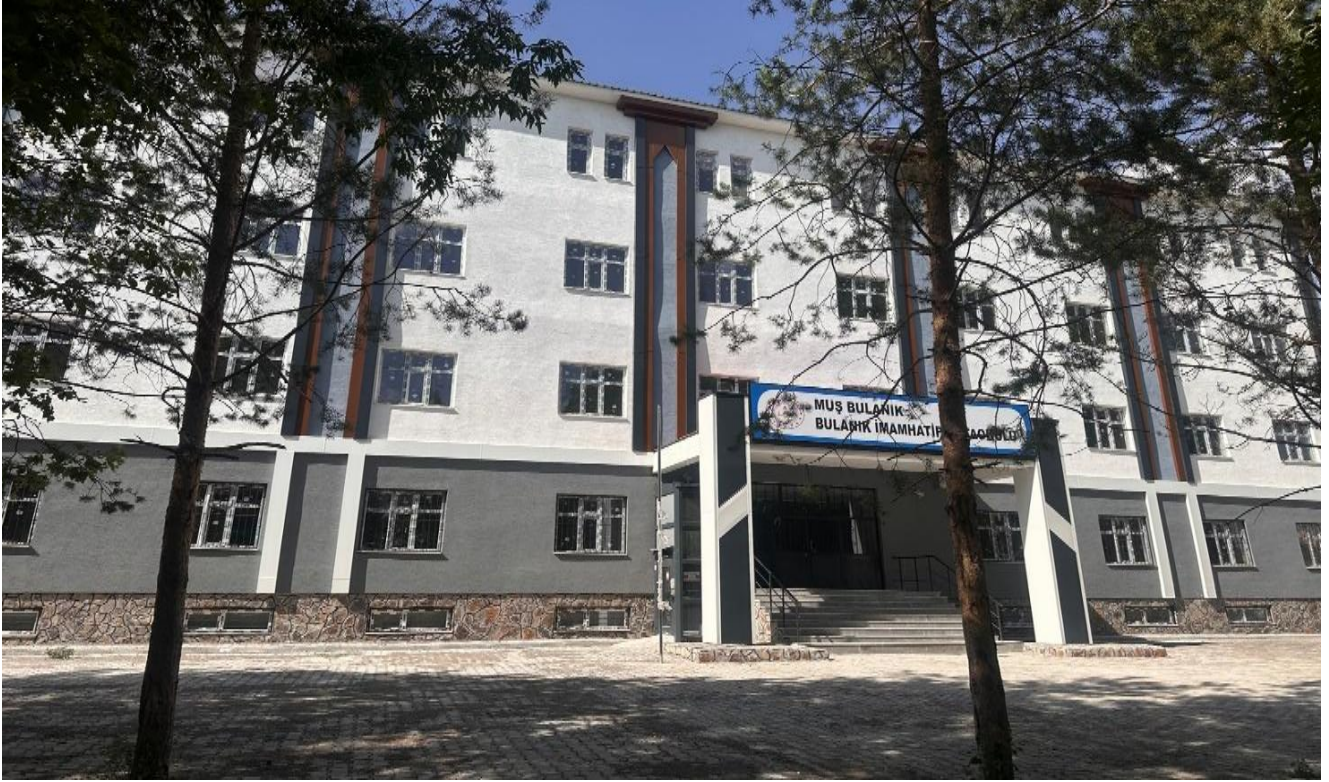
Bulanık 24 Derslikli İHO Okul Binası Yapımı ve Çevre Düzenlemesi İş Proje Tutarı 43.274.380,66TL Başlama Bitiş Tarihi 21.11.2022-28.01.2025
