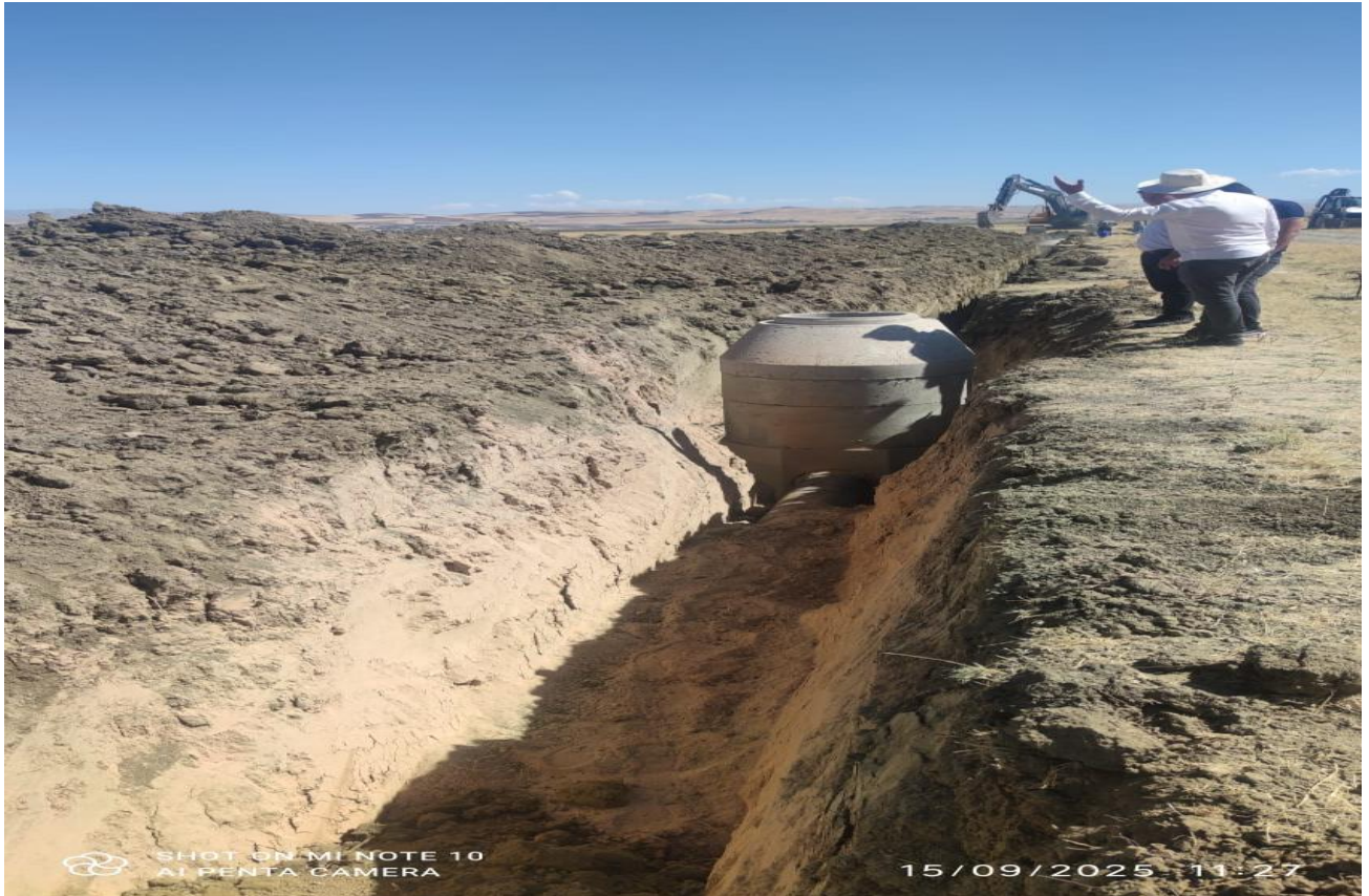
Merkez Tabanlı Köyü Kanalizasyon Yapım İşi
