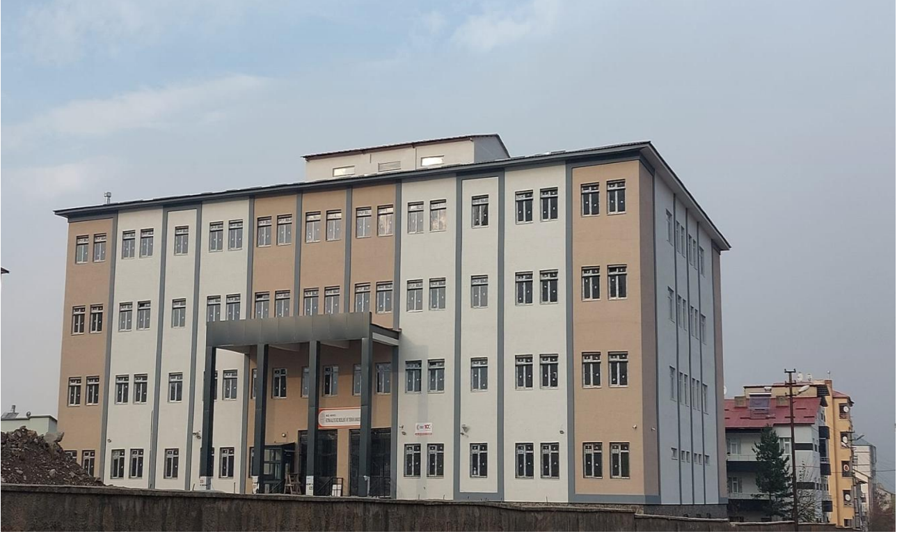
Muş Merkez 24 Derslikli Mesleki Teknik Anadolu Lisesi Yapımı ve Çevre Düzenlemesi Yapım İşİProje Tutarı 93.476.091,85TL Başlama Bitiş Tarihi ( 27.12.2023 -06.12.2025)
