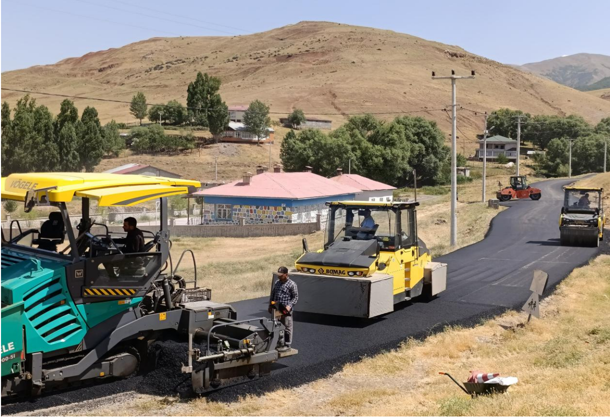
Muş Merkez Sudurağı ve Toprakkale Köyleri BSK yol yapım işi
