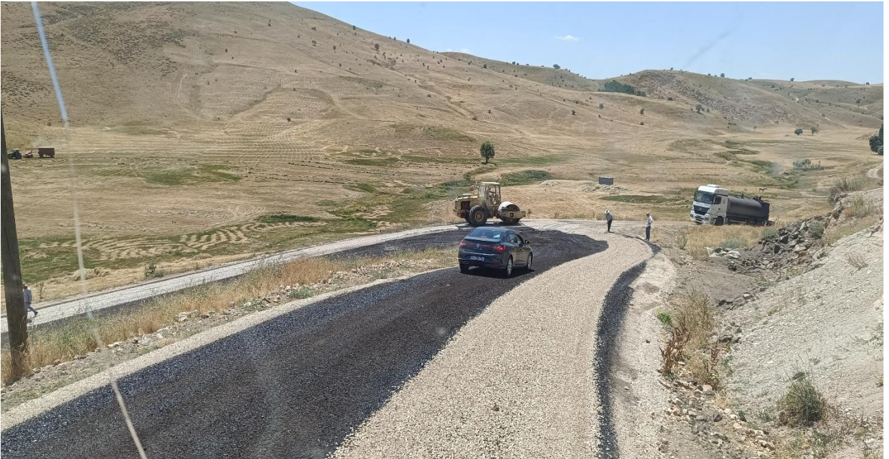
2025 yılı 1. ve 2. Kat asfalt çalışmalarımız.
