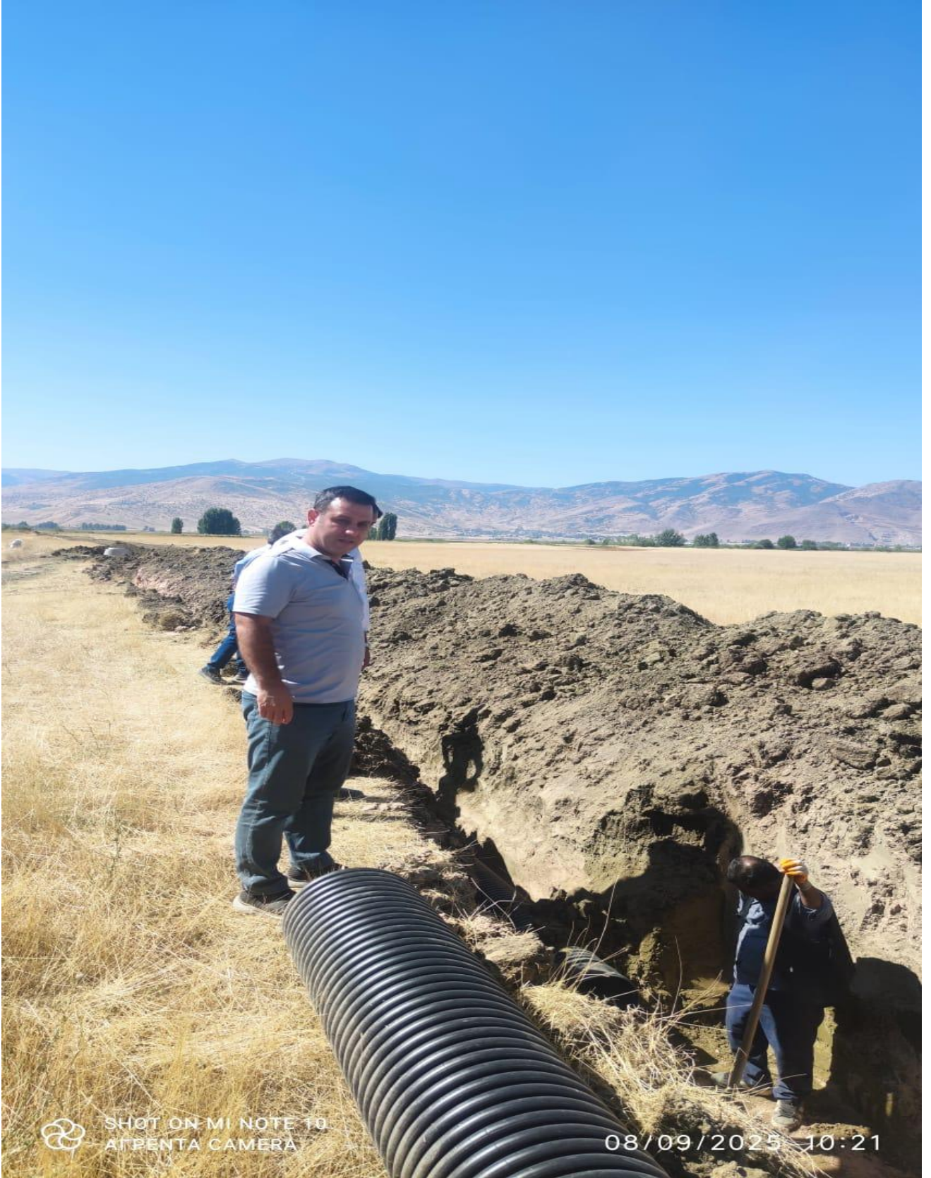
Muş Merkez Gümüşali Köyü Güneş Enerjili İçme Suyu Tesisi Yapım İşi
