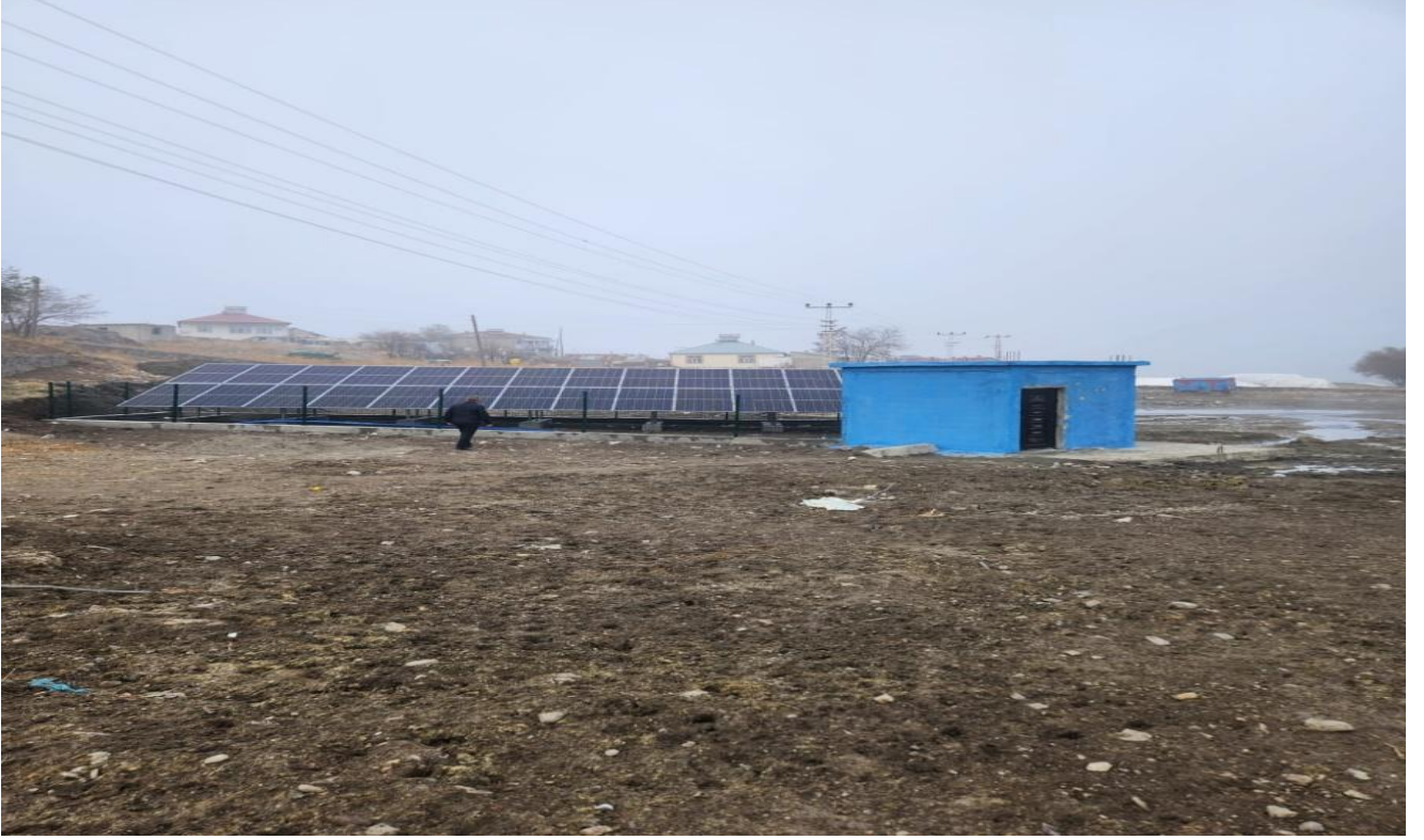
Bulanık Balotu Köyü Güneş Enerjili İçme Suyu Tesisi Yapım İşi
