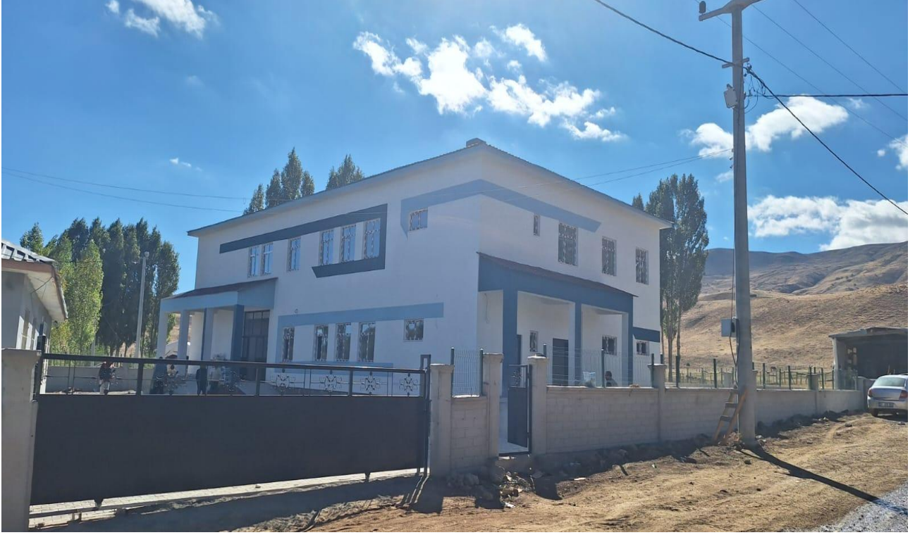
Varto İlçesi Haksever Köyü 4 Derslikli Okul Binası+3 Adet Binanın Yıkımı ve Çevre Düzenlemesi İşi Proje Tutarı: 20.879.195,71 TL Başlama Bitiş Tarihi ( 23.06.2025 30.11.2025 )
