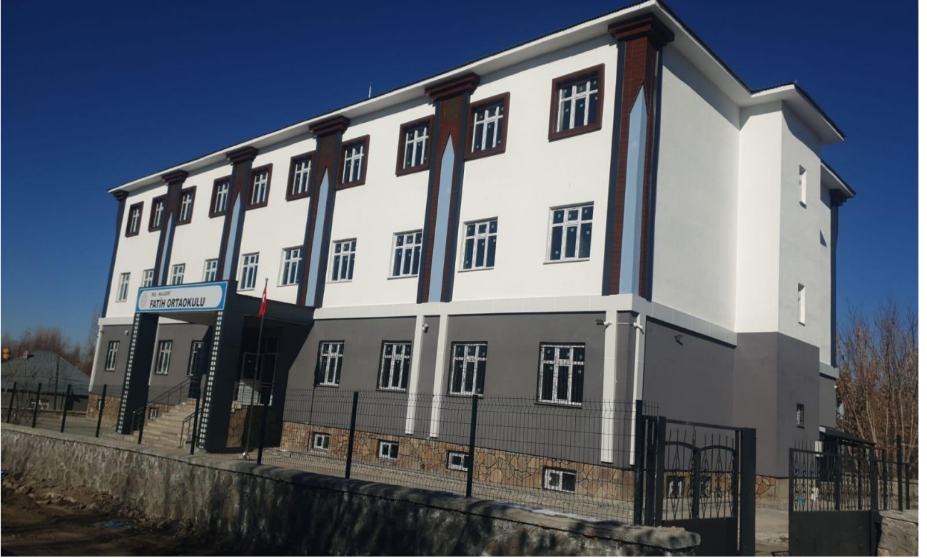
Muş Malazgirt Fatih 16 Derslikli Ortaokulu Binası Yapımı ve Çevre Düzenleme İşi Proje Tutarı 31.856.444,78 Başlama Bitiş Tarihi 21.11.2022-04.02.2025
