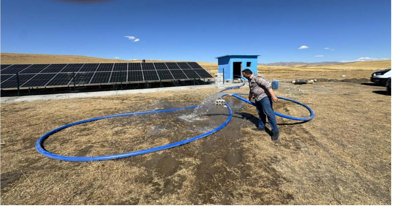
Malazgirt Aynalıhoca Köyü Güneş Enerjili İçme Suyu Tesisi Yapım İşi
