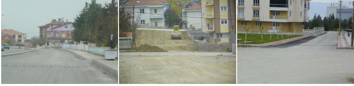
OKUL ÖNLERİNDEKİ KASIS UYGULAMALARI ATATÜRK MAH. YOL AÇMA VE STABİLİZE ÇAL. ASFALT YAMA YAPIM İŞLERİ
