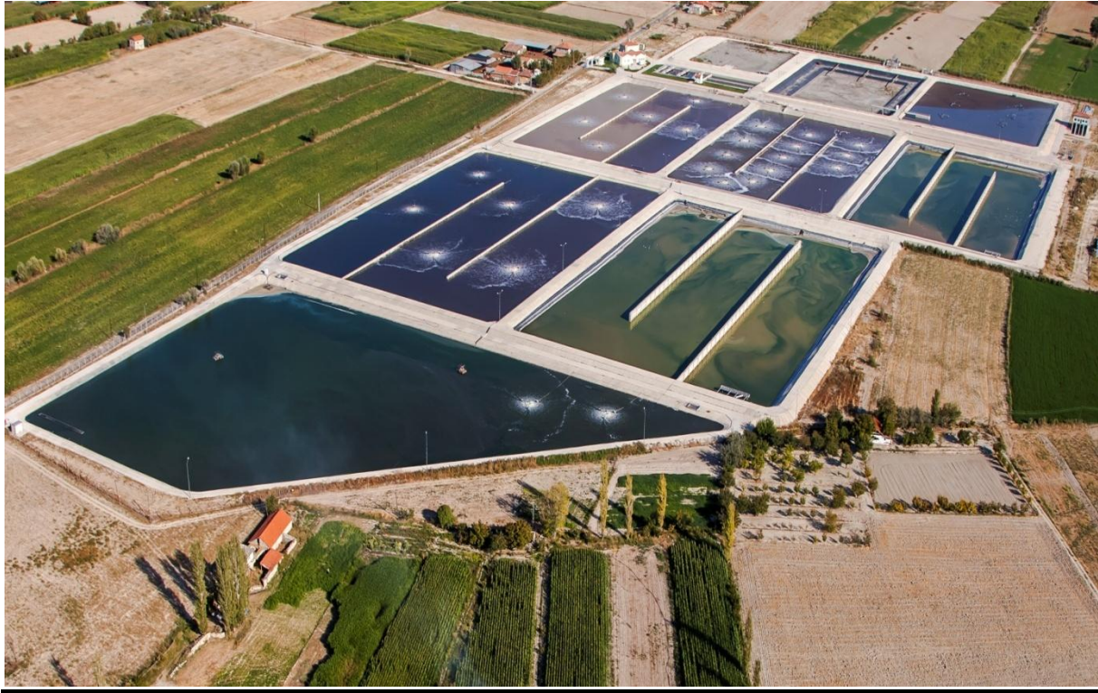
Arıtma Tesisi Kuşbakış Genel Görünümü
