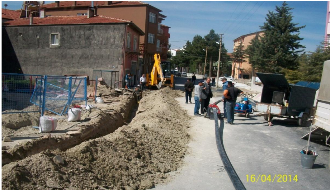
Yeni Mahallede eksik olan yerlere şebeke döşemeye devam edildi
