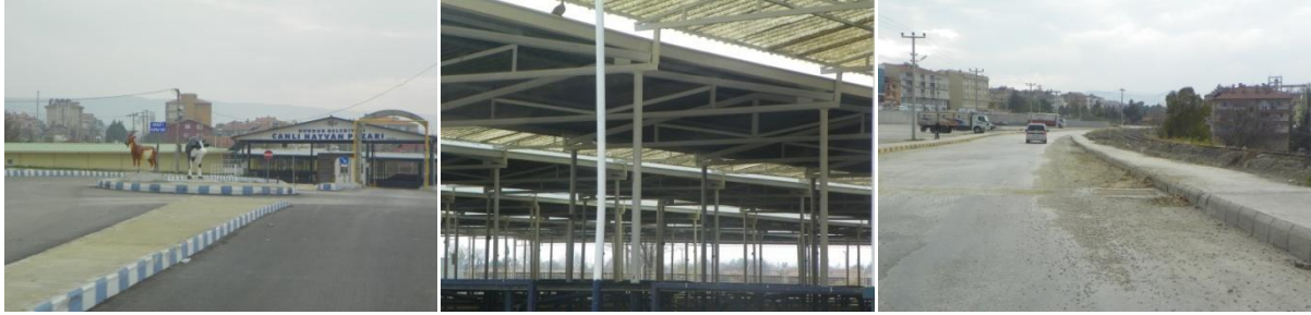
HAYFAN PAZARIKAVŞAĞI ASFALTLAMA VE İÇİNİN BOYAMA İŞİ
