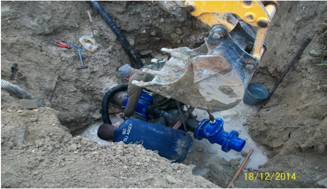
Akdeniz Bulvarınının eski bağlantıları yenilenip tahliye hattı döşendi
