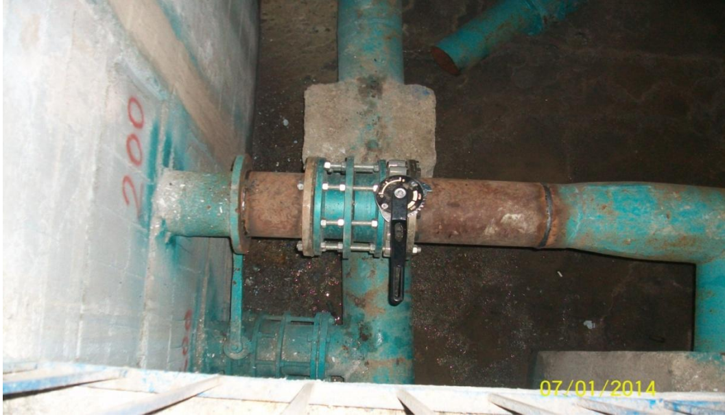
Atatürk Mahallesi depo çıkış vanalarını yeniledik
