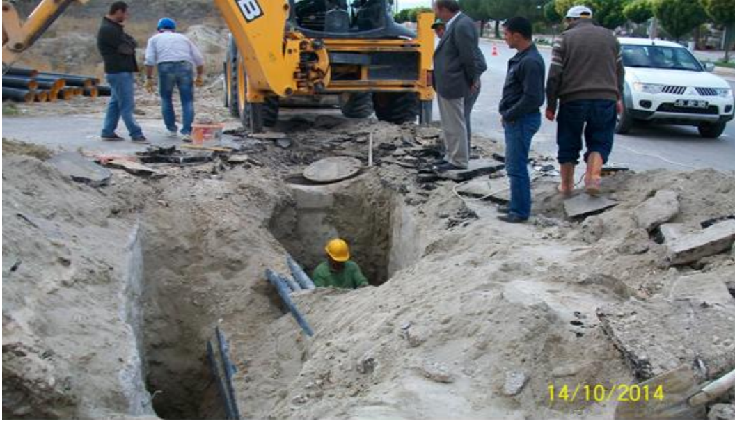
Emek Mahallesiinde kanalizasyon hattı eksikliklerini tamamlamaya çalıştık
