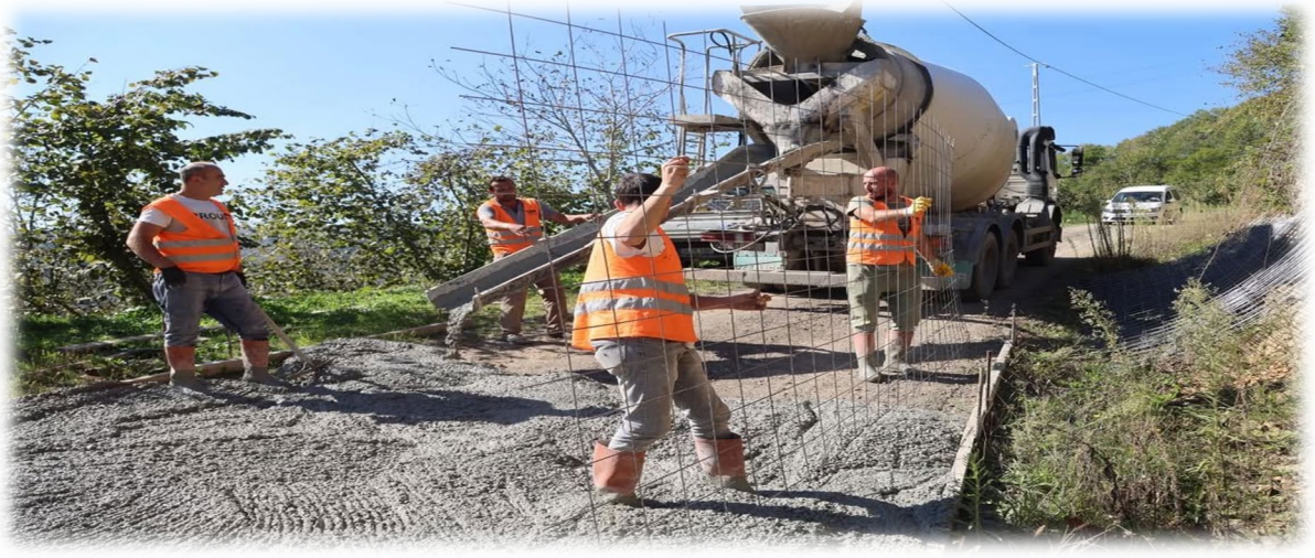
GÖKÇEPINAR MAHALLESİ BETON YOL ÇALIŞMASI
