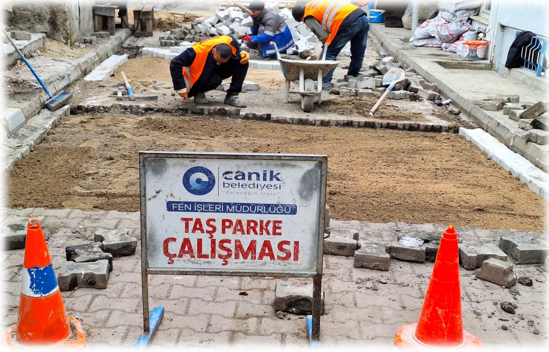
YAVUZSELİM MAHALLESİ PARKE TADİLAT ÇALIŞMASI
