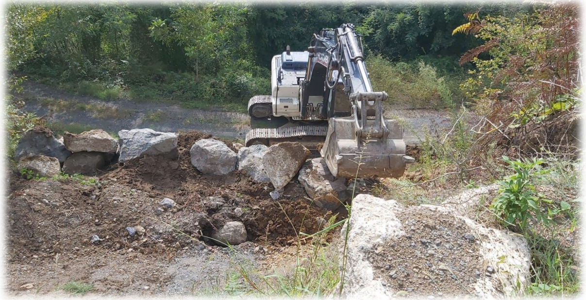
KESTANEPINAR MAHALLESİ TAŞ TAHKİMAT ÇALIŞMASI
