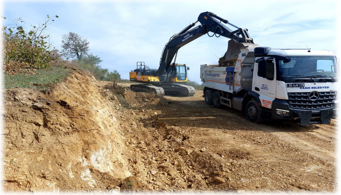
BAŞALAN MAHALLESİ YOL AÇMA ÇALIŞMASI
