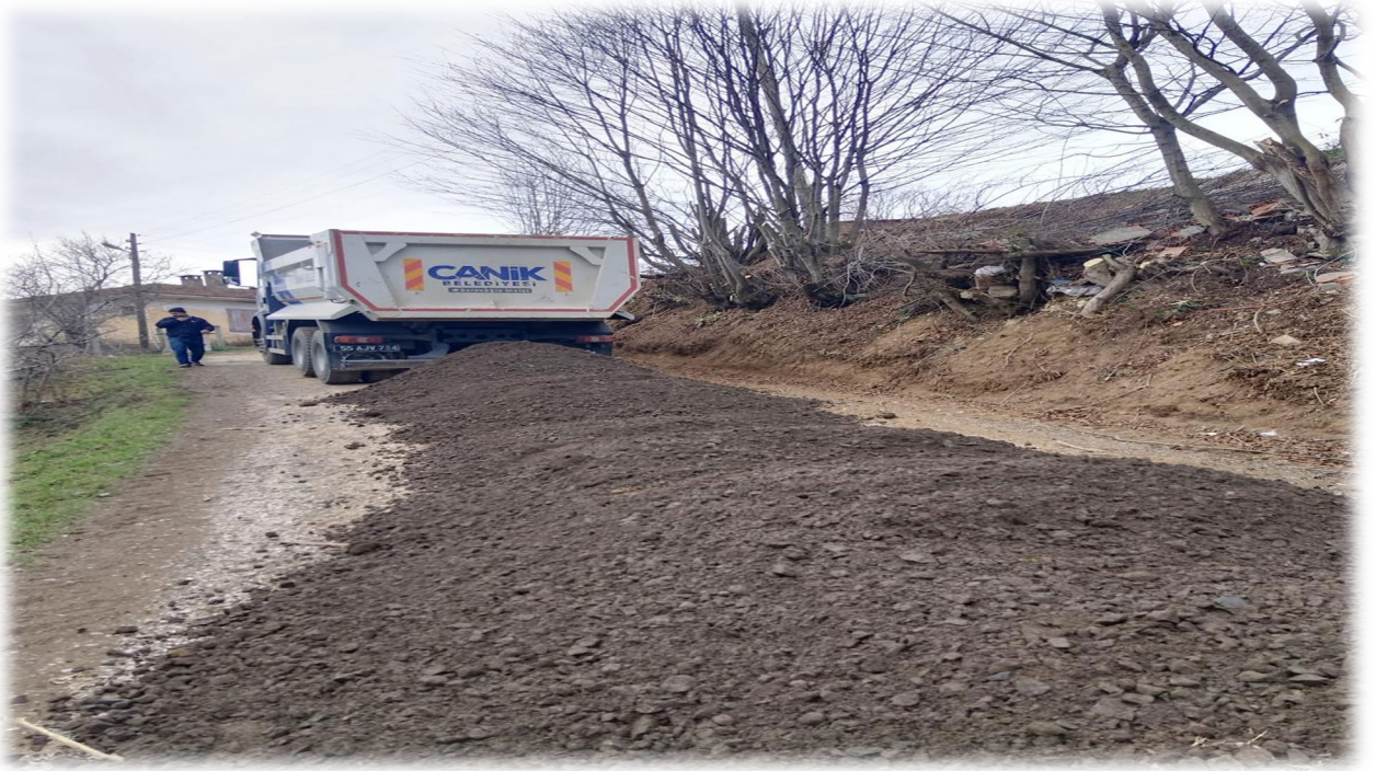
ÇAMALAN MAHALLESİ ELEKALTI MALZEME SERİM ÇALIŞMASI
