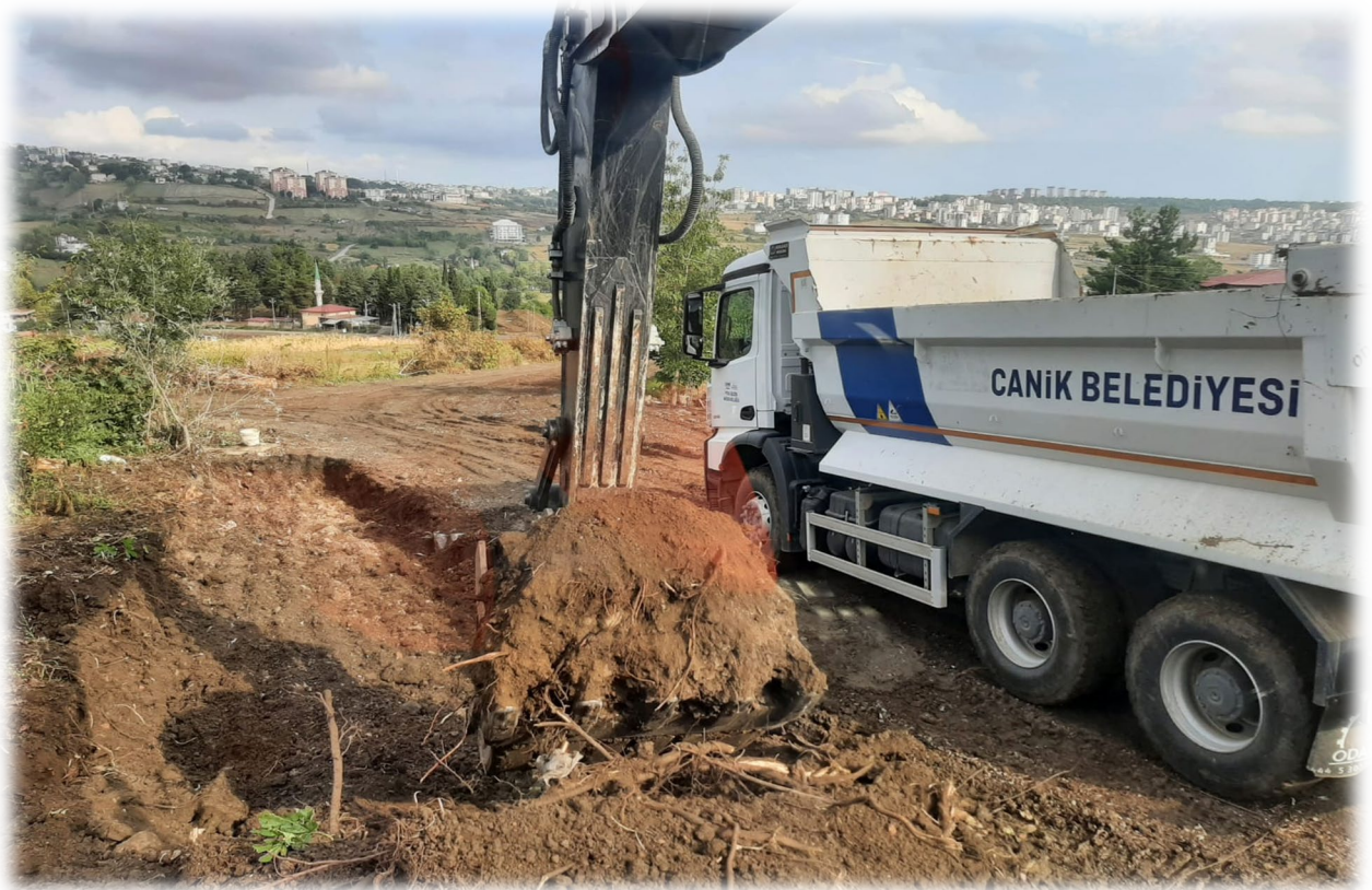
DERELER MAHALLESİ YOL GENİŞLETME ÇALIŞMASI
