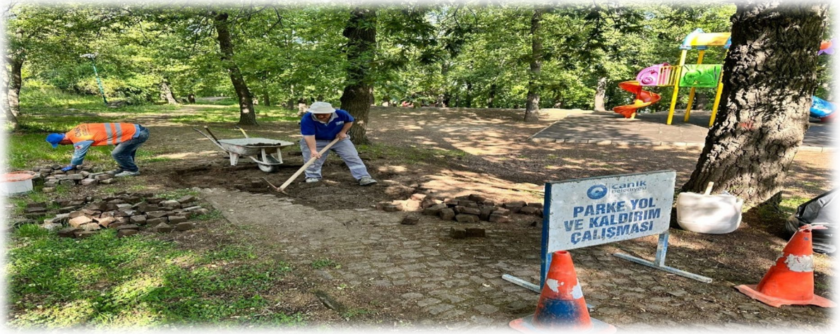
KUZEY YILDIZI MAHALLESİ KÜP TAŞ İMALAT ÇALIŞMASI
