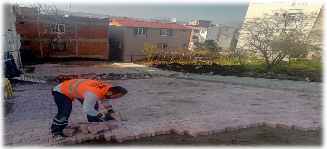
GAZİOSMANPAŞA MAHALLESİ PARKE İMALAT ÇALIŞMASI
