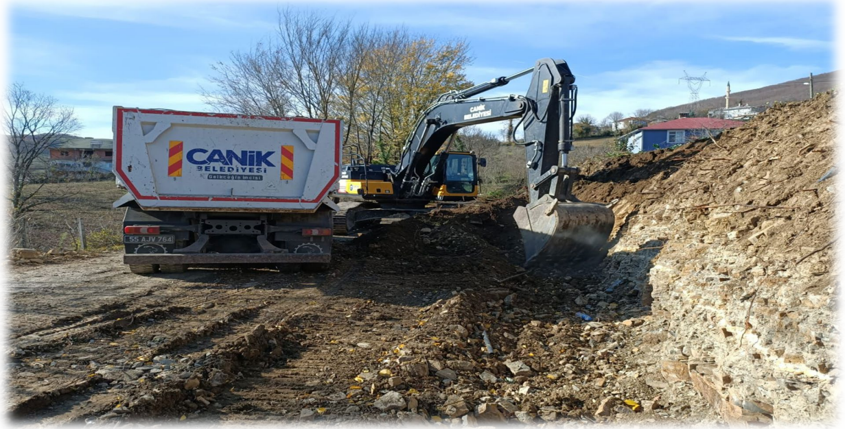
BAŞALAN MAHALLESİ KANAL AÇMA ÇALIŞMASI
