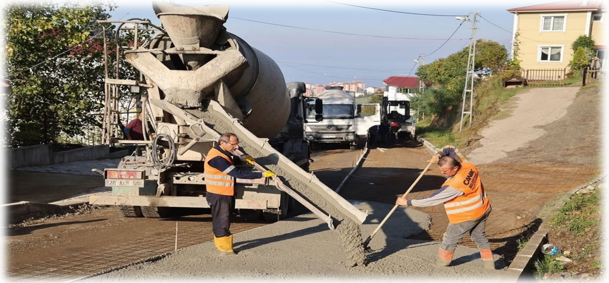
TEKNEPINAR MAHALLESİ BETON YOL ÇALIŞMASI
