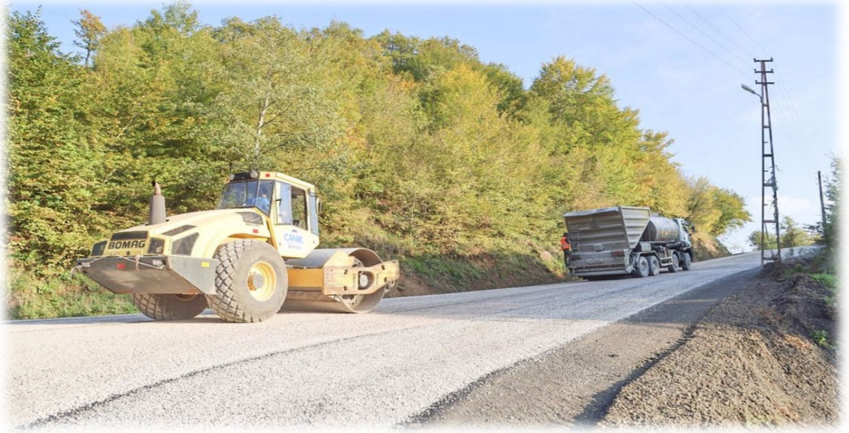
TOYGAR- ALİBEYLİ MAHALLESİ SATHİ KAPLAMA ÇALIŞMASI
