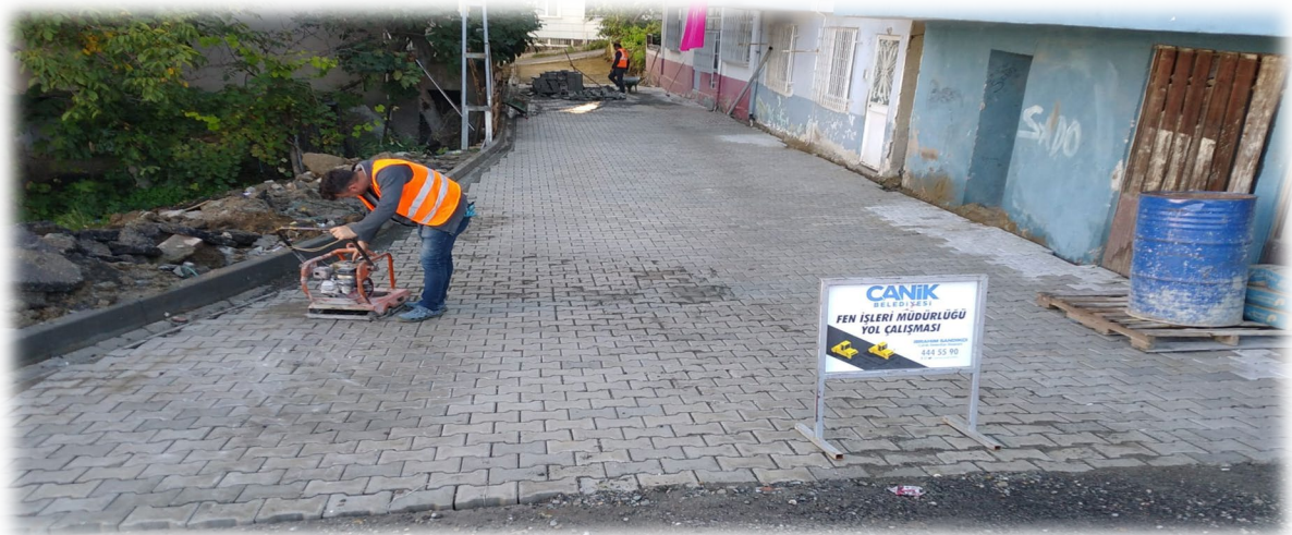
KARŞIYAKA MAHALLESİ PARKE İMALAT ÇALIŞMASI
