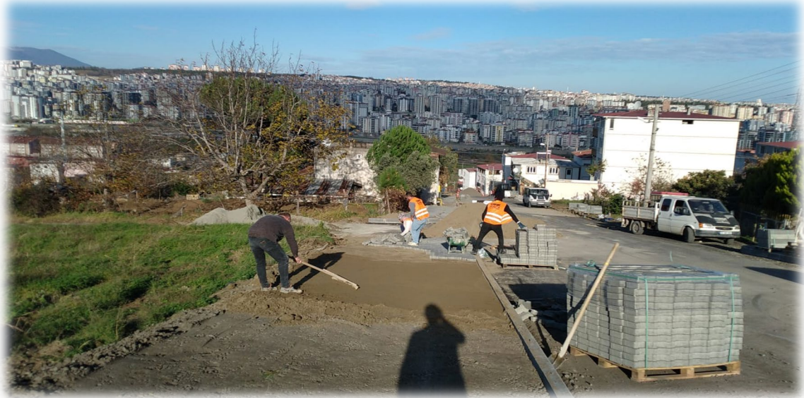
HACİİSMAİL MAHALLESİ KALDIRIM ÇALIŞMASI
