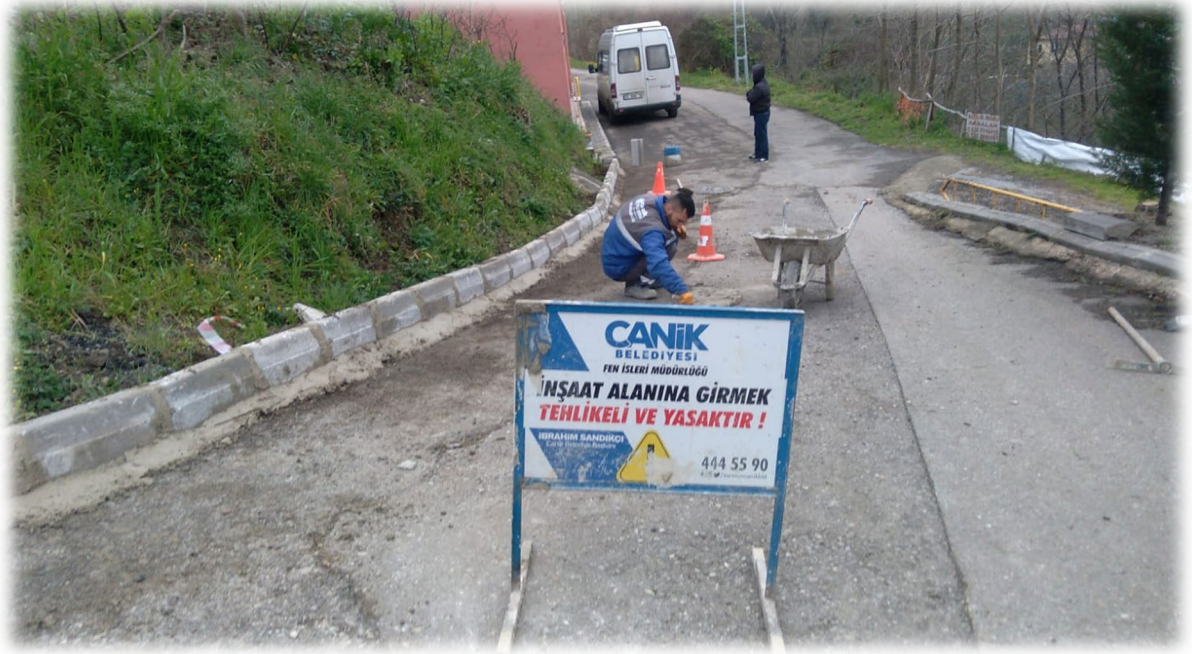
TEKNEPINAR MAHALLESİ BORDÜR TADİLAT ÇALIŞMASI
