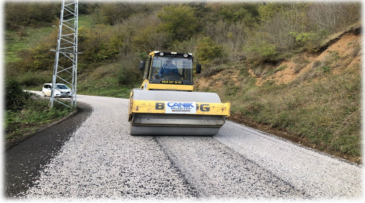
GÖKÇEPINAR MAHALLESİ SATHİ KAPLAMA ÇALIŞMASI
