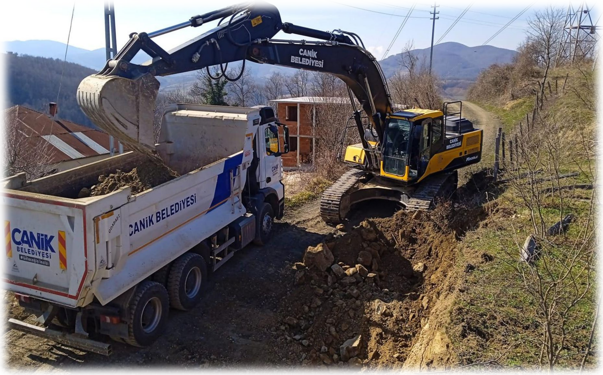
BAŞALAN MAHALLESİ YOL GENİŞLETME ÇALIŞMASI
