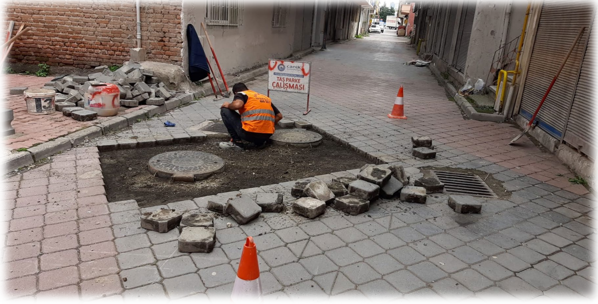
KUZEY YILDIZI MAHALLESİ PARKE TADİLAT ÇALIŞMASI
