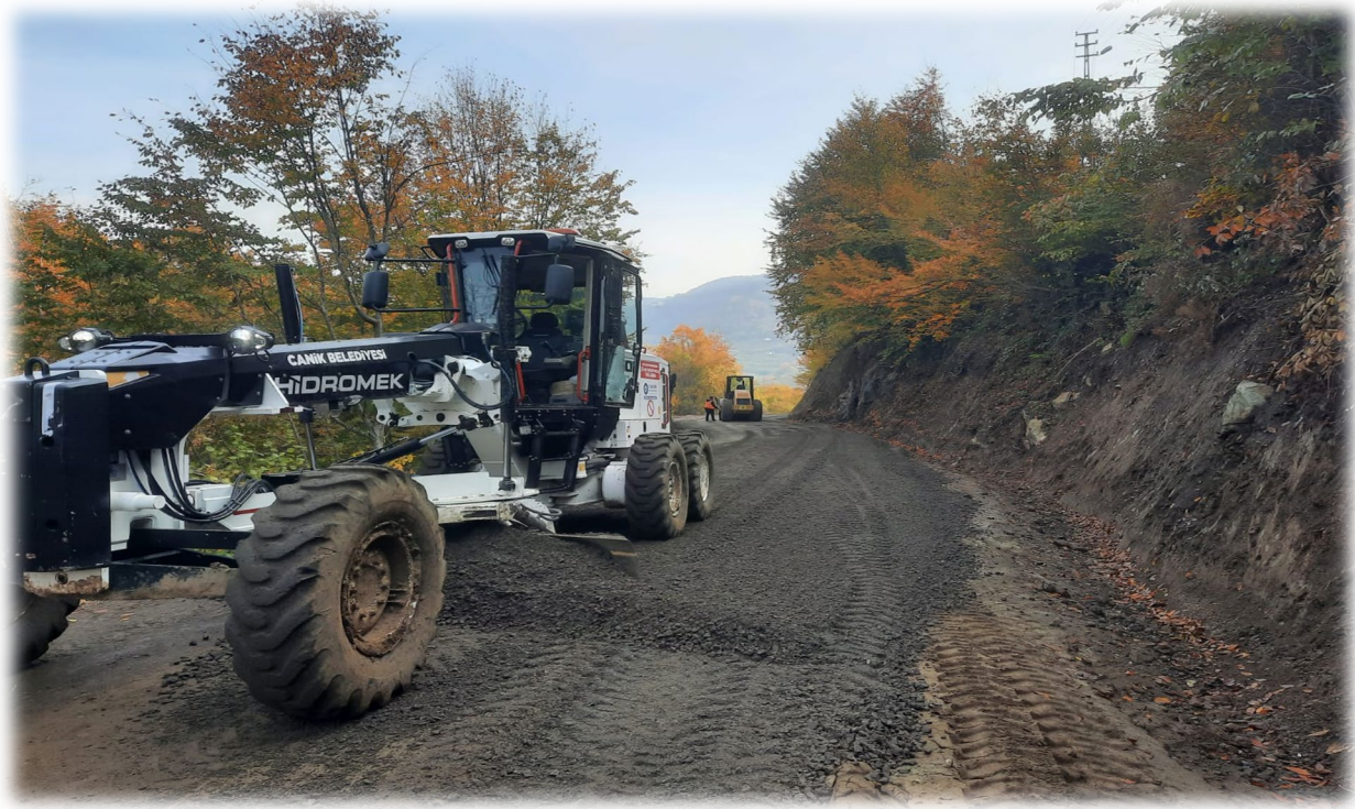
KESTANEPINAR MAHALLESİ ELEKALTI MALZEME SERİM ÇALIŞMASI
