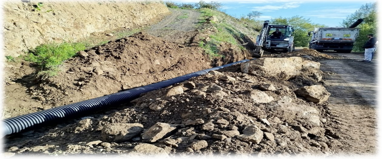
KESTANEPINAR MAHALLESİ KORUGE BORU DÖŞENMESİ
