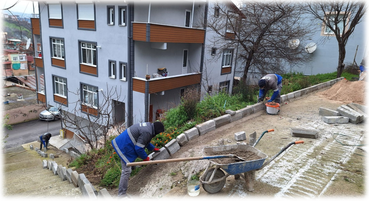
GAZİOSMANPAŞA MAHALLESİ BORDÜR İMALAT ÇALIŞMASI
