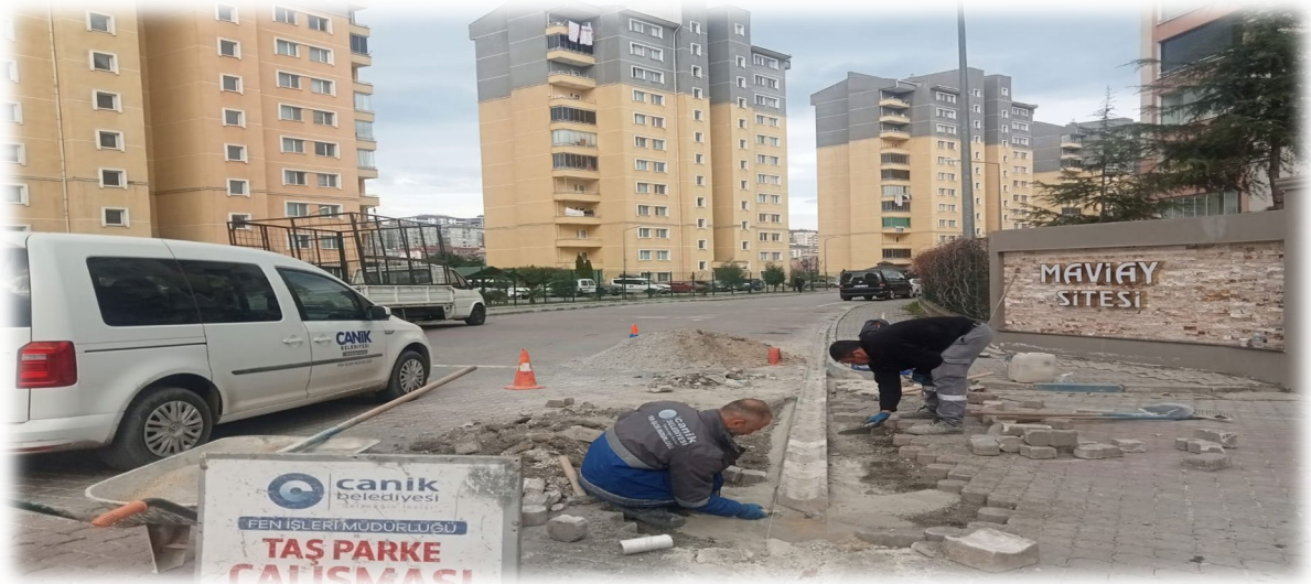
KUZEY YILDIZI MAHALLESİ OLUK İMALAT ÇALIŞMASI
