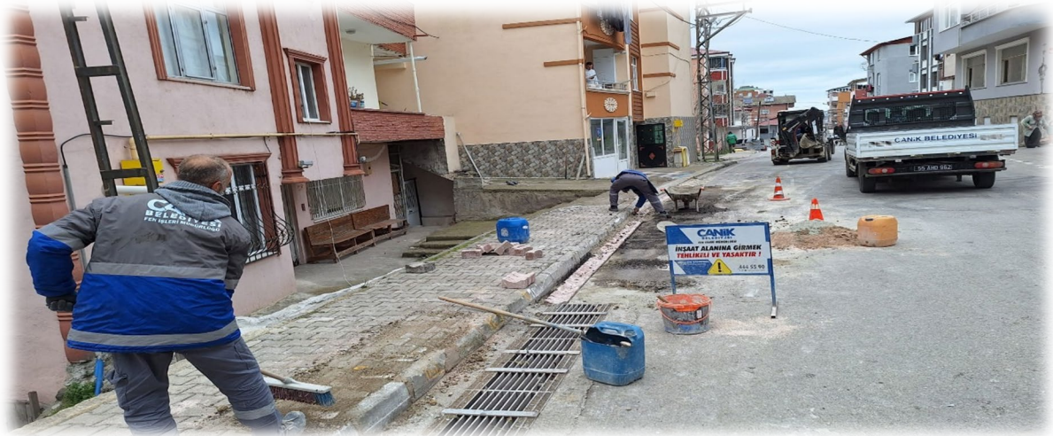
GAZİOSMANPAŞA MAHALLESİ OLUK TADİLAT ÇALIŞMASI
