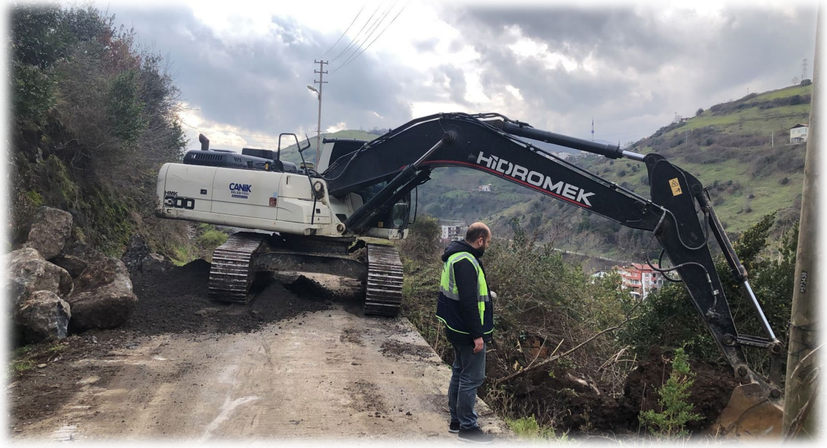
GAZİOSMANPAŞA MAHALLESİ TAŞ TAHKİMAT ÇALIŞMASI
