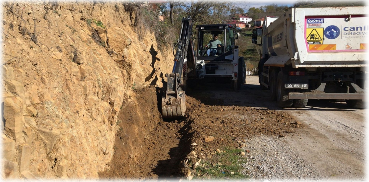
ULUÇAYIR MAHALLESİ KANAL AÇMA ÇALIŞMASI
