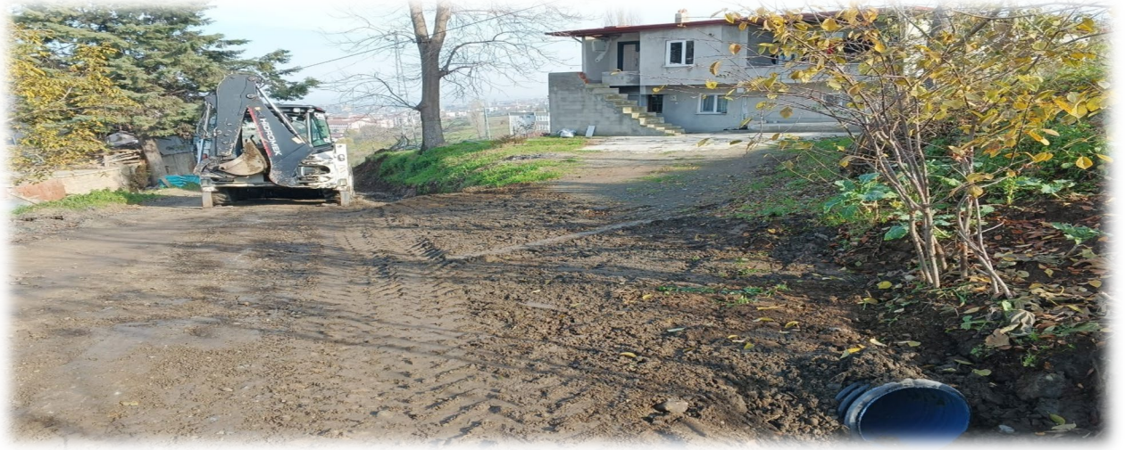
DÜVECİK MAHALLESİ KORUGE BORU DÖŞENMESİ
