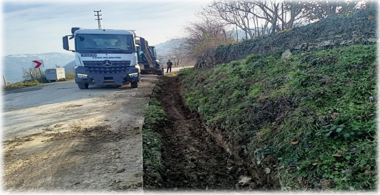
KALEBOĞAZI MAHALLESİ KANAL AÇMA ÇALIŞMASI
