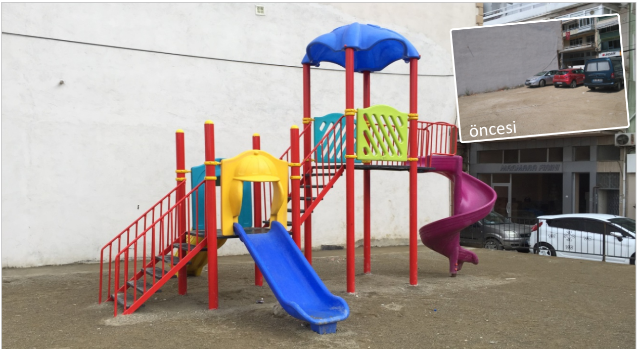
Hamidiye mahallesi Krom sokakta oyun grubu bulunmayan alana oyun grubu montajı yapılmıştır.
