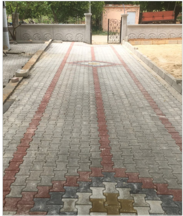
Haydariye Mahallesi Meydan Düzenleme İşi
