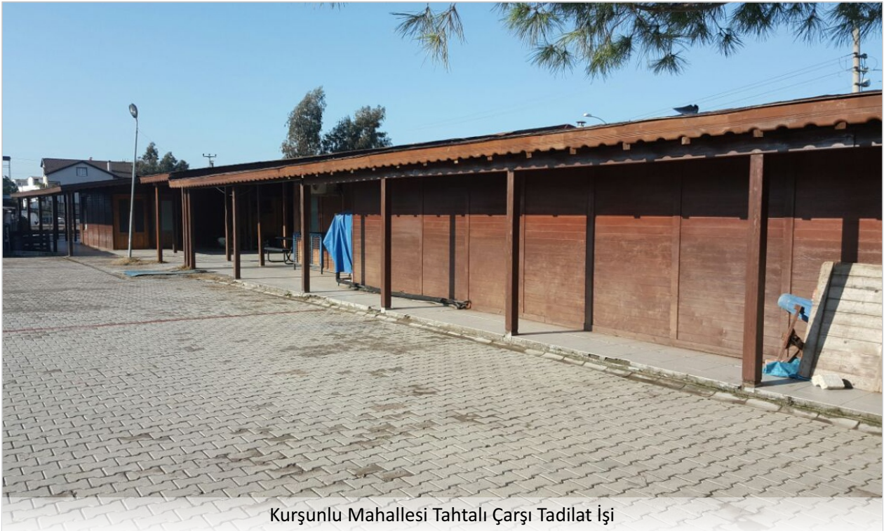
Kurşunlu Mahallesi Tahtalı Çarşı Tadilat İşİ
