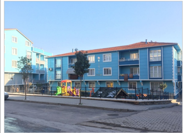
Korkuluk Yapılması İşi
