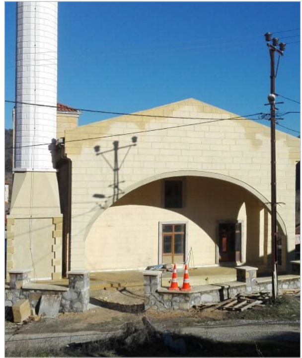
Fındıcak Mahallesi Camii Tadilatı İşİ
