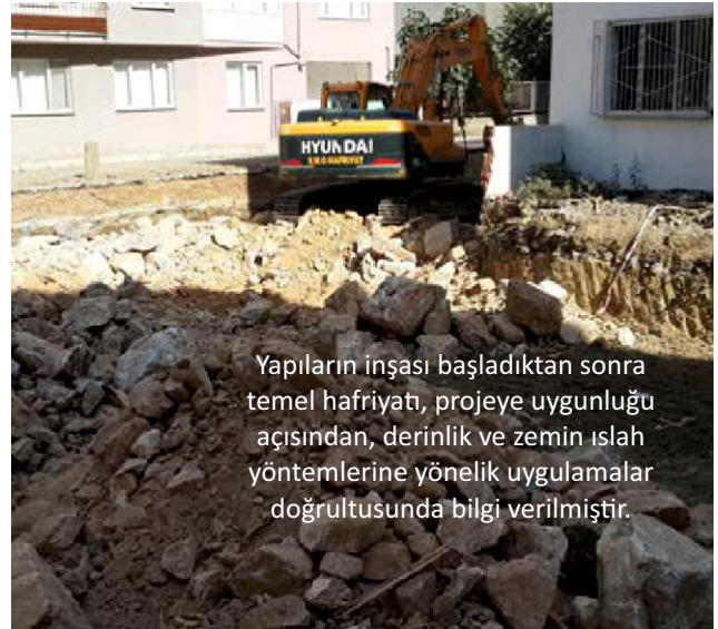
Yapıların inşası başladıktan sonra temel hafriyatı, projeye uygunluğu açısından, derinlik ve zemin ıslah yöntemlerine yönelik uygulamalar doğrultusunda bilgi verilmiştir.
