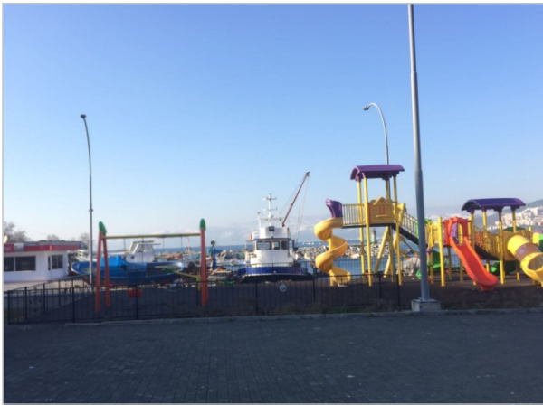
Korkuluk Yapılması İşi
