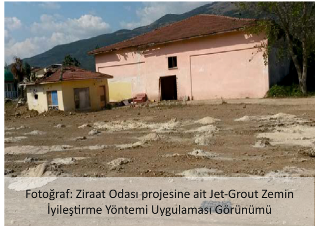
Fotoğraf: Özdilek İHO yanı mescit projesine ait Jet-Grout Zemin İyileştirme Yöntemi Uygulaması Görünümü
