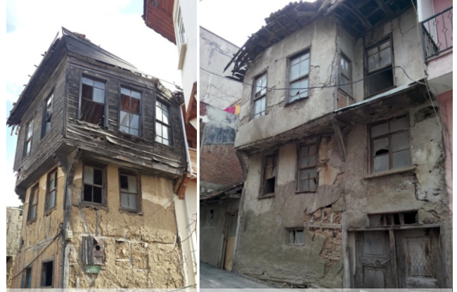
Sivil Mimarlık Örneği yapının mevcut durumu
