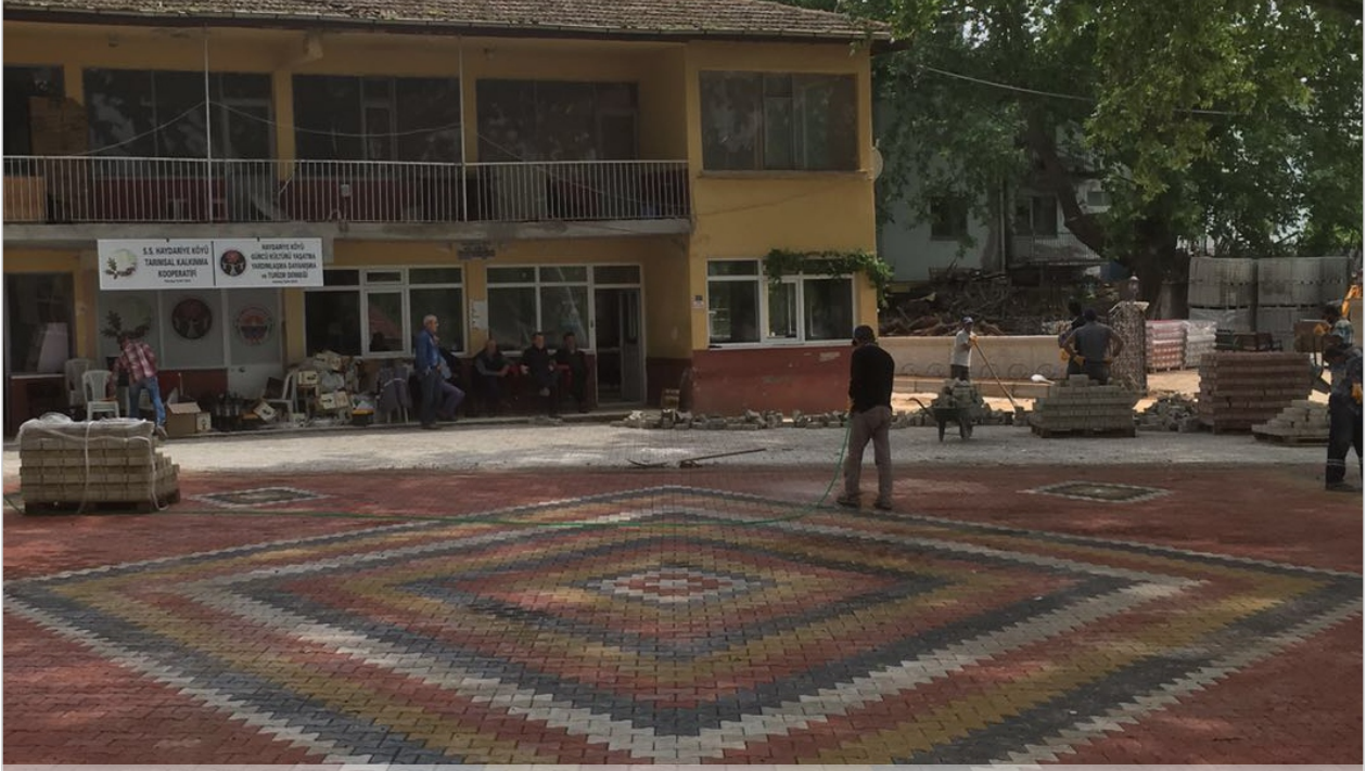
Haydariye Mahallesi Meydan Düzenleme İşi
