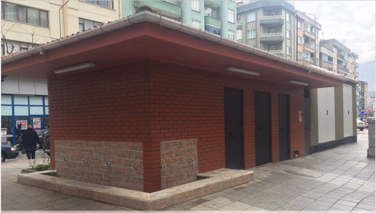
Karsak Camii Trafo, WC Yapılması ile Washbeton Döşeme İşi
