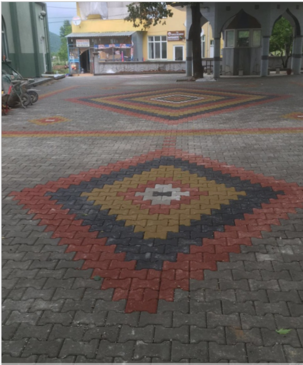
Haydariye Mahallesi Meydan Düzenleme İşi
