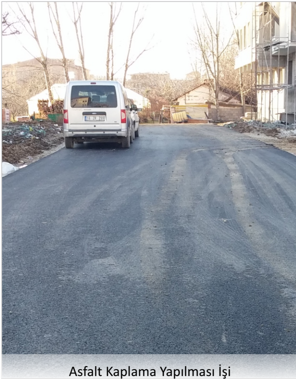
Asfalt Kaplama Yapılması İş'i
