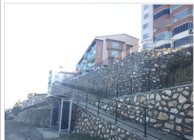
Korkuluk Yapılması İşi
