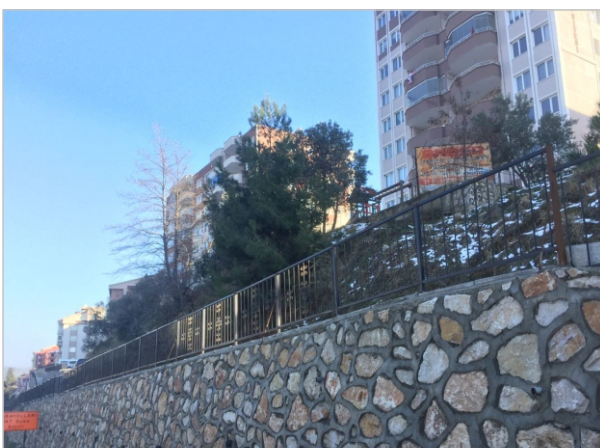
Korkuluk Yapılması İşi
