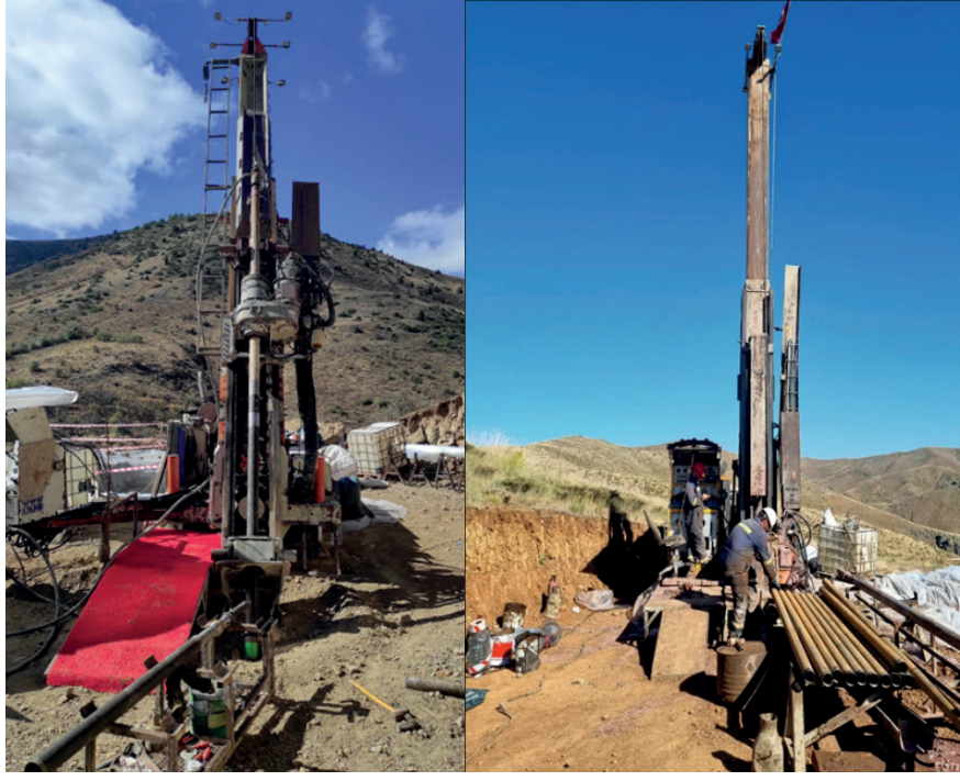
Sondaj çalışmalarından görünüm
