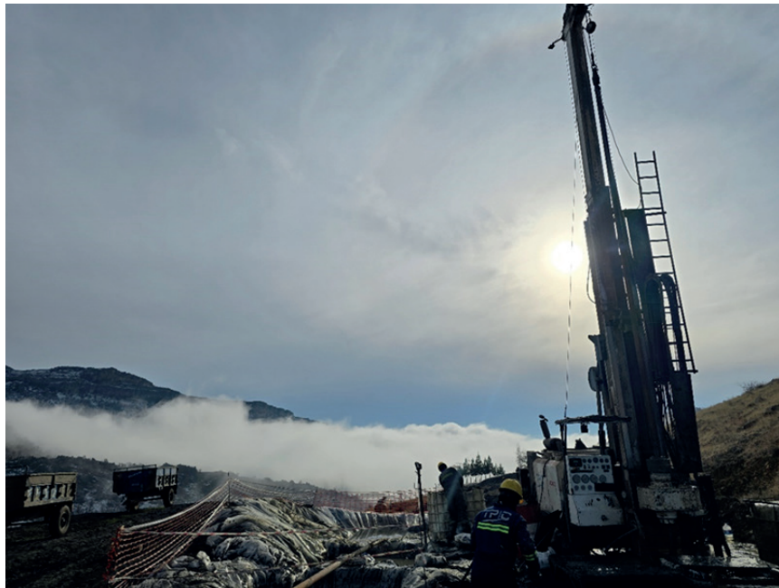
Sondaj çalışmalarından görünüm
