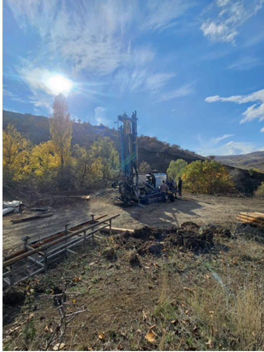
Ruhsat sahalarında yapılan çalışmalardan görünüm
