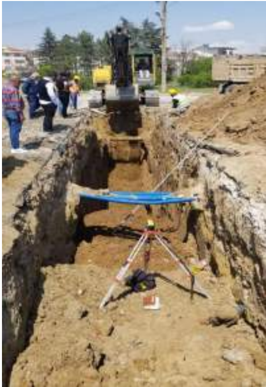
Ø2000 mm buhar kürlü entegre contalı Olin Kavşağı Yağmur Suyu İmalatı
