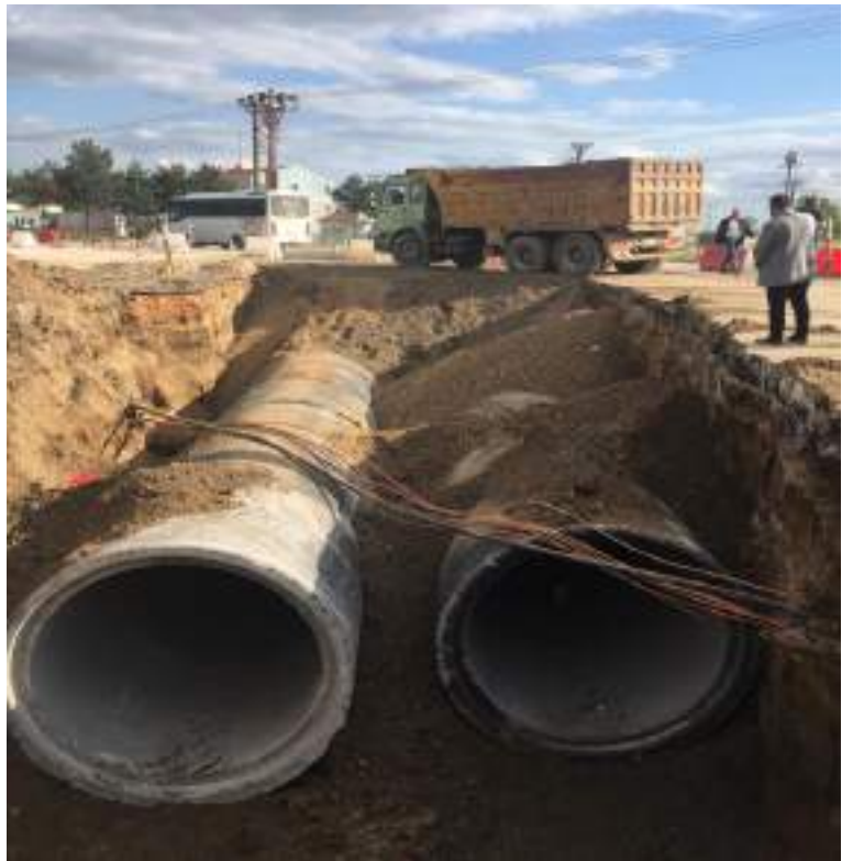
Ø2000 mm buhar kürlü entegre contalı Olin Kavşağı Yağmur Suyu İmalatı
