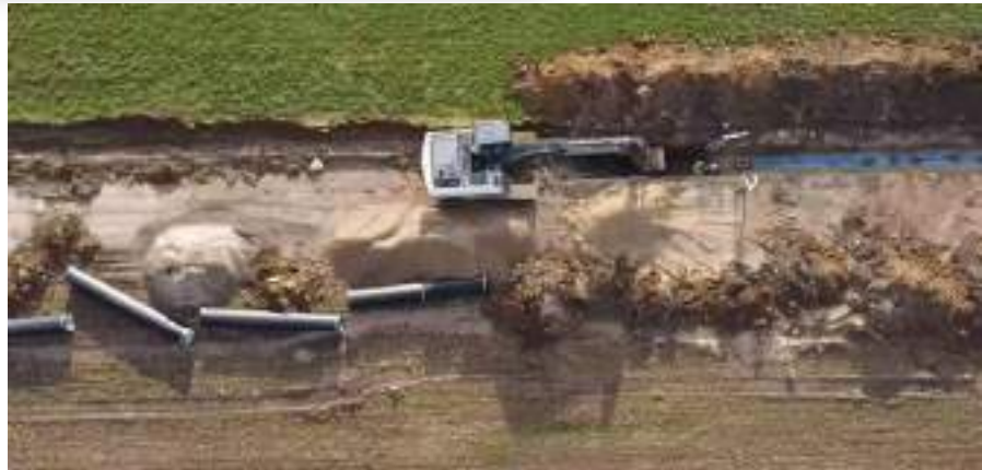
Paşacayırı Ø700 mm düktül boru imalatı
