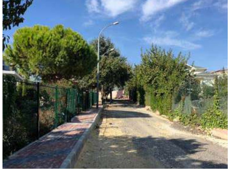
EKİNOBA MAHALLESİ MARMARA VİLLALARI AYDINLATMA ÇALIŞMASI
