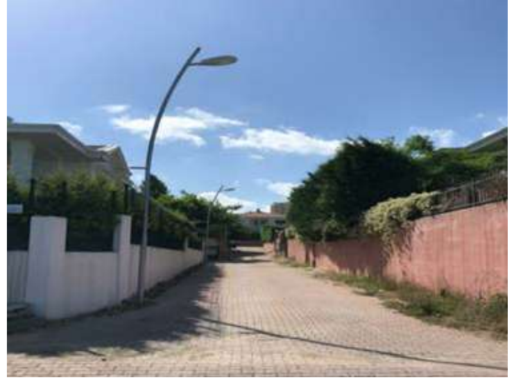
SİNANOBA MAHALLESİ DİDEM SOKAK AYDINLATMA ÇALIŞMASI
