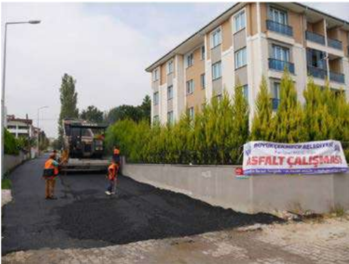
MURATÇEŞME MAHALLESİ ACEM SOKAK
