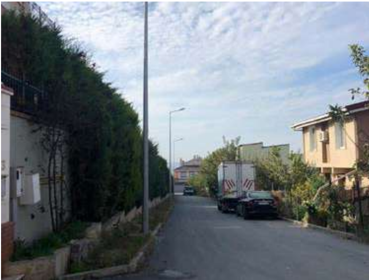
GÜZELCE MAHALLESİ İTİR 1 SOKAK AYDINLATMA ÇALIŞMASI
