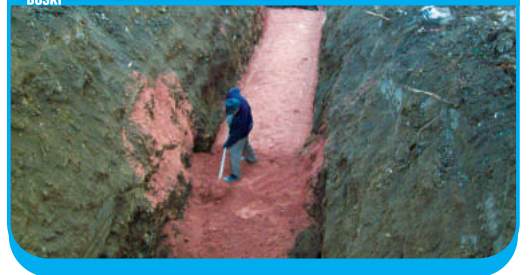
Yeni Şebeke İnşaatı
