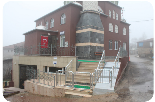
Bollu Umurcalı Camii mermer kaplama çalışması Sonrası
