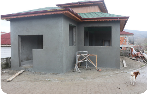
Topluca Mahallesi Köylü Binası Sıva Çalışması
