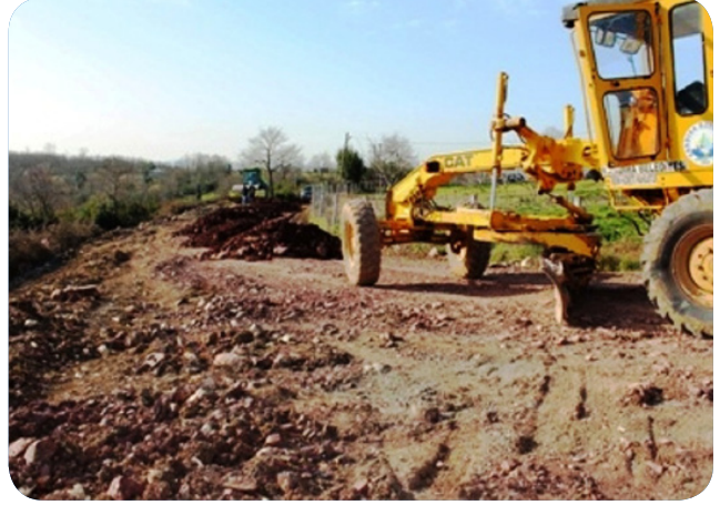
Arazi Yolları tesviye çalışması
