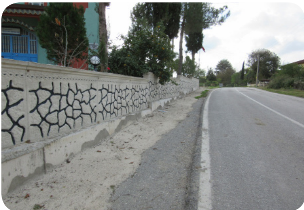
Kubuzcu-AbdiPaşa Camii Çelik Kalıp Perde Duvarı
