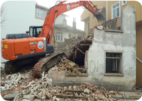
Metruk Bina Yıkım Çalışması-1
