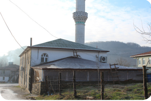
Akçaova Camii Çatı Tadilat Çalışması
