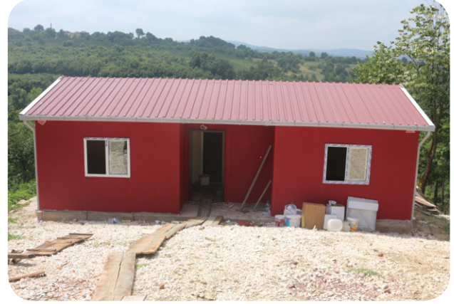
Antaplı Gariban Prefabrik Tadilat Çalışması
