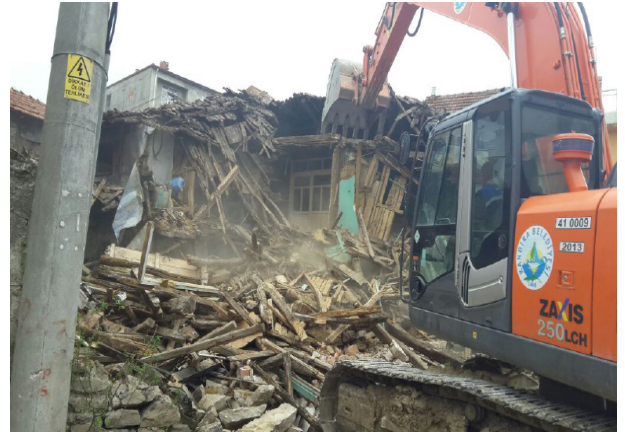
Metruk Bina Yıkım Çalışması-2
