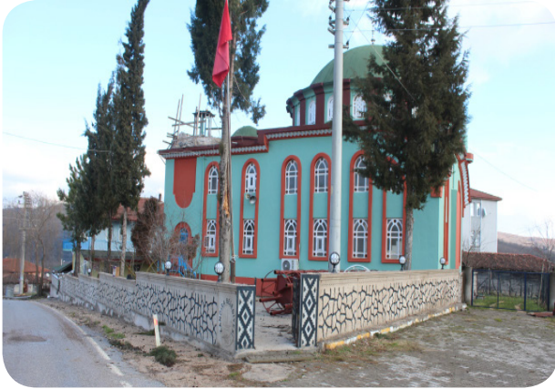
Kubuzcu Abdipaşa Camii Boyama Çalışması
