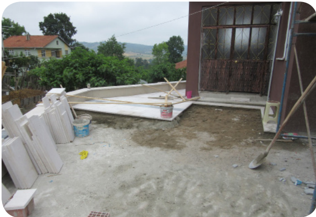
Bollu Umurcalı Camii mermer kaplama çalışması Öncesi
