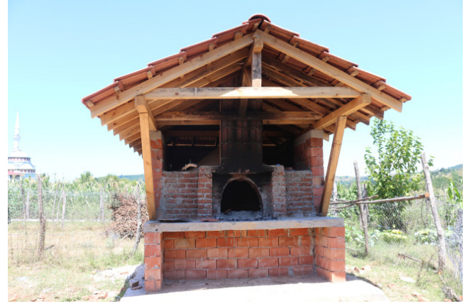
Beylerbeyi Mahallesi Fırın Çalışması
