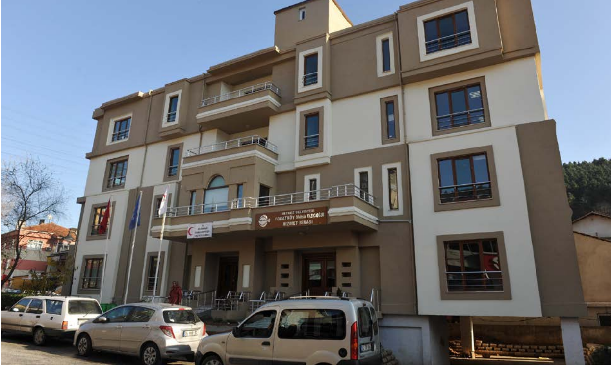
Tokatköy Muhsin Yazıcıoğlu Hizmet Binasımız; Aile Sağlığı Merkezi Ve Belediyemizce Ücretsiz Kurs Yeri Olarak Kullanılmaktadır.
