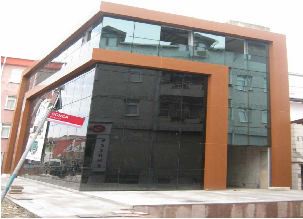
İncirköy Hizmet Binası; Binanın tamamı Aile Sağlığı Merkezi olarak kullanılmaktadır.
