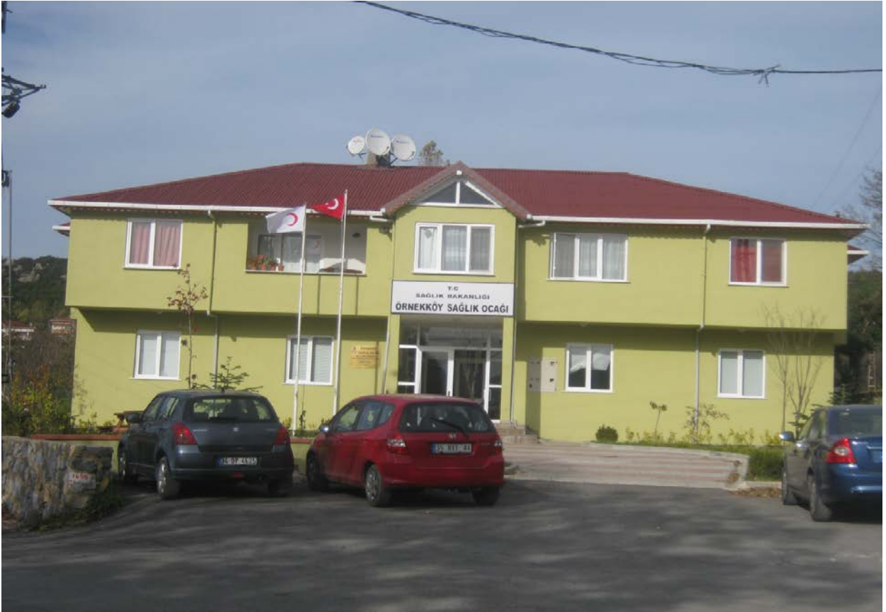
Örnekköy Hizmet Binasımız; Aile Sağlığı Merkezi Olarak Kullanılmaktadır.
