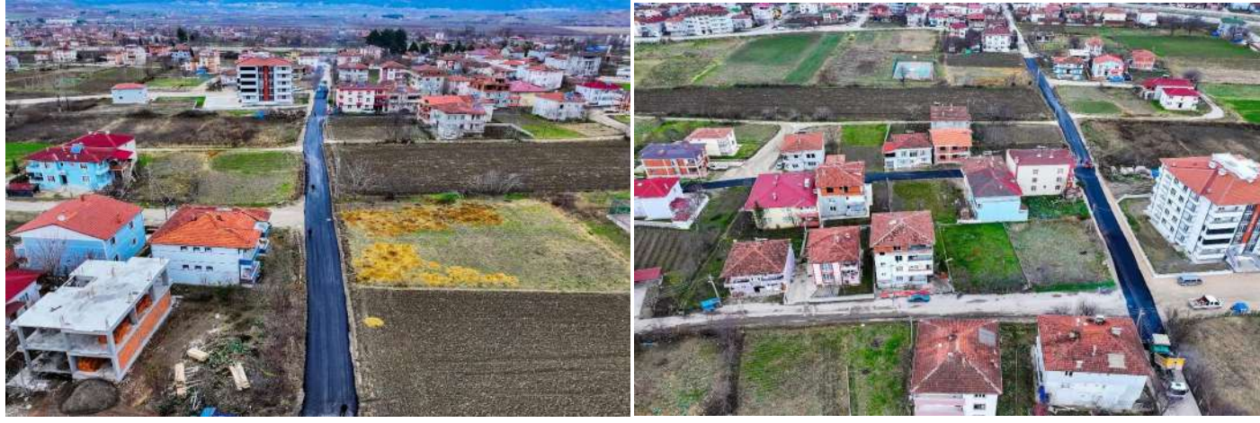
Yıldırım Beyazıt Mahallesi Asfalt Çalışması
