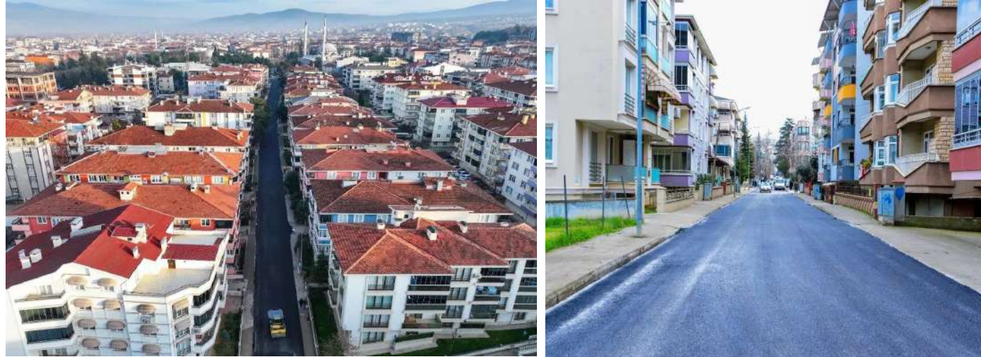
Fevzipaşa Mahallesi Asfalt Çalışması
