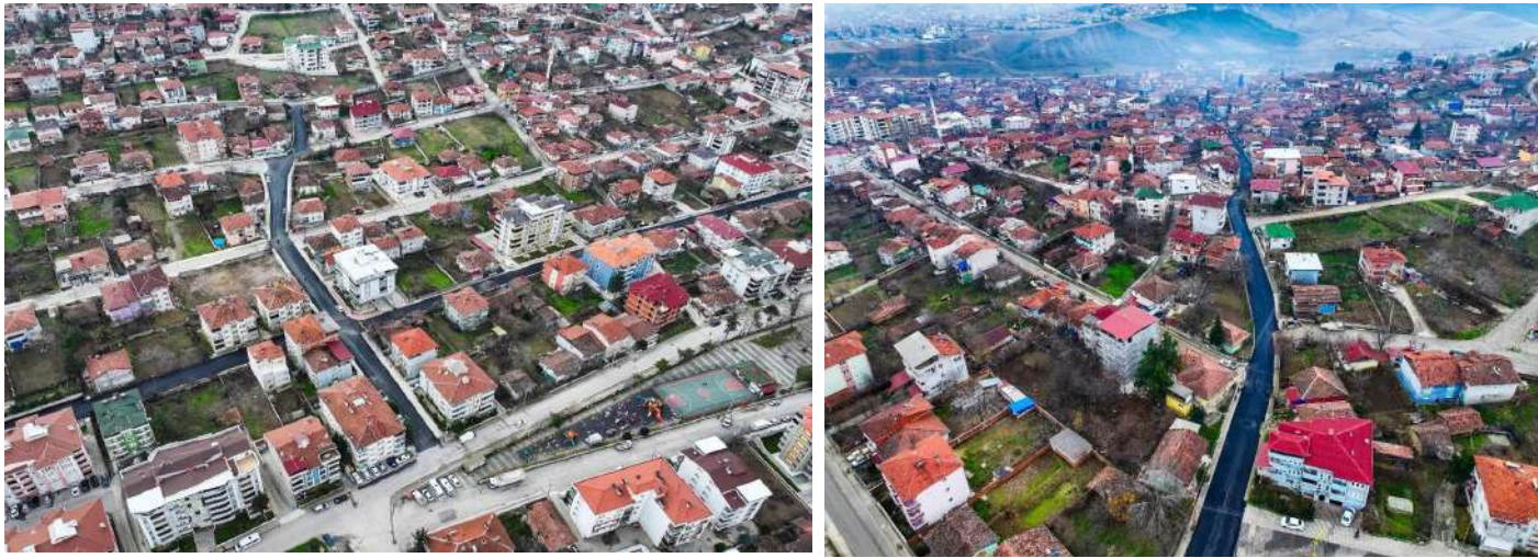
İsmetpaşa Mahallesi Asfalt Çalışması
