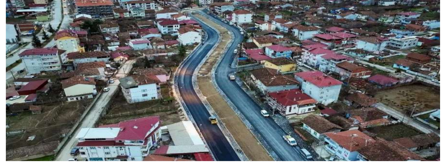
Yunus Emre Mahallesi Asfalt Çalışması
