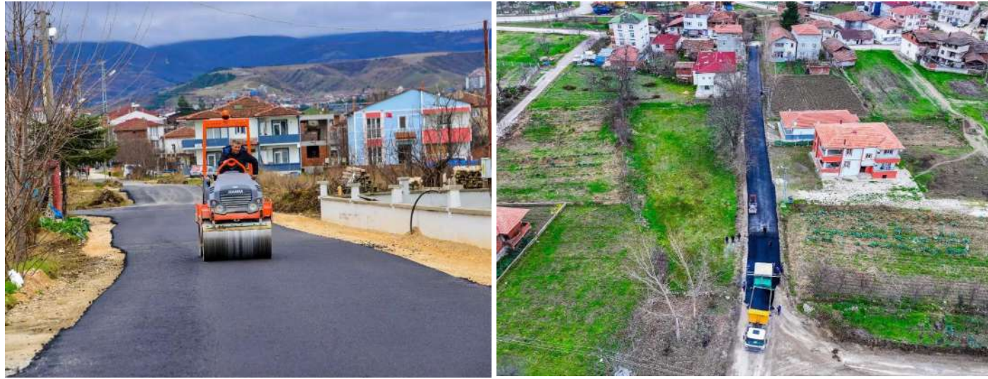
Erek Mahallesi Asfalt Çalışması
