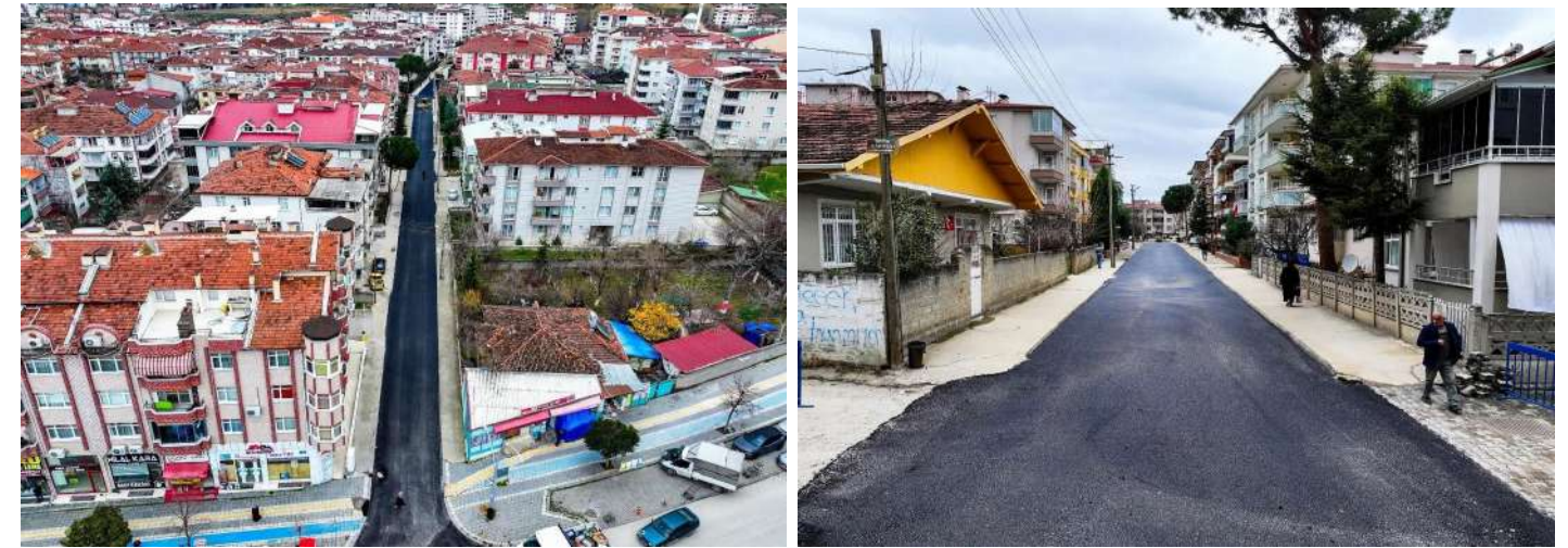
Yeşilyurt Mahallesi Asfalt Çalışması
