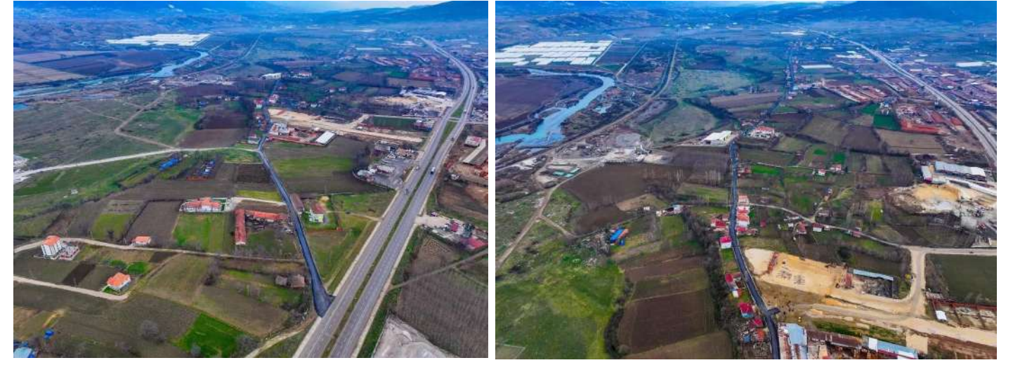
Yeni Mahalle Asfalt Çalışması
