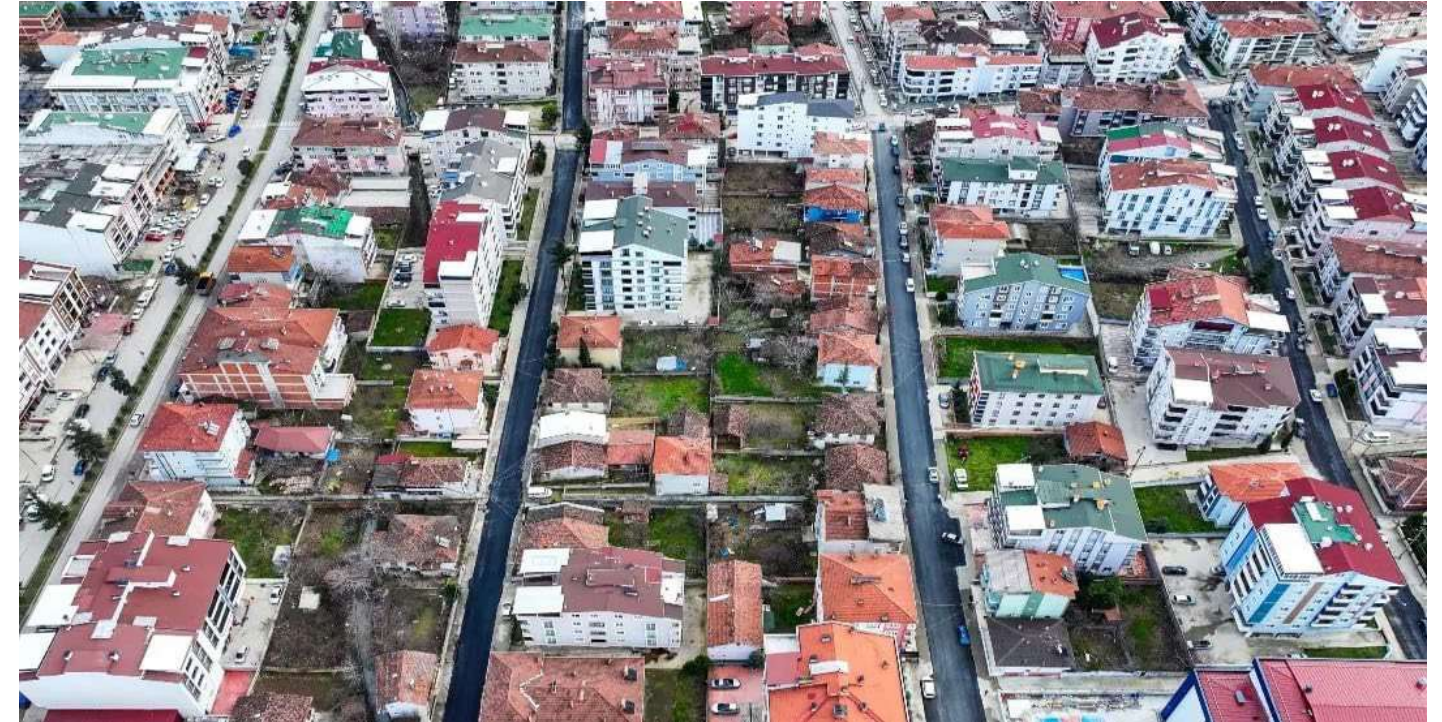
Mehmet Akif Mahallesi Asfalt Çalışması
