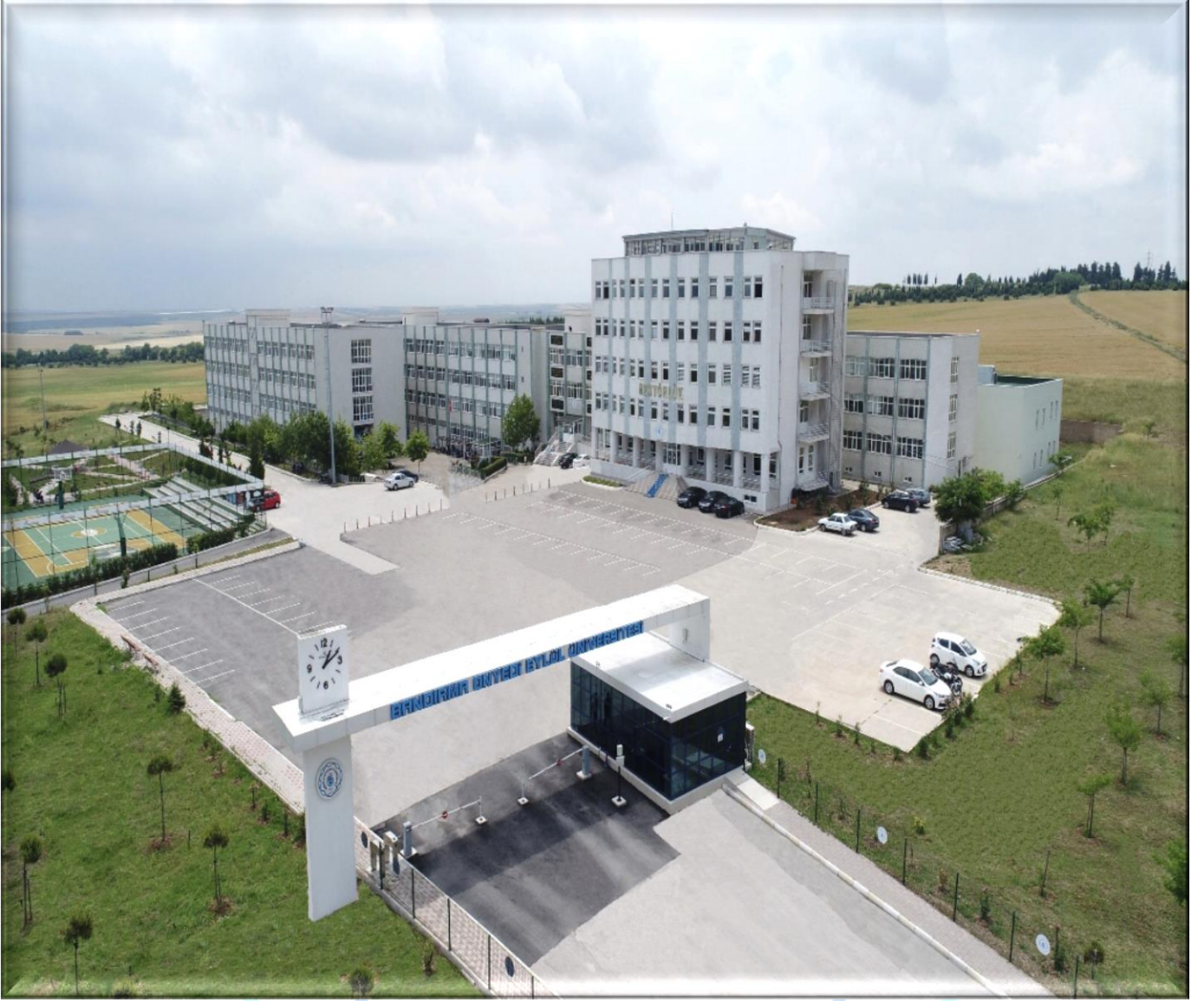
RESİM-1- Rektörlük Merkez Yerleşkeden Bir Görüntü
