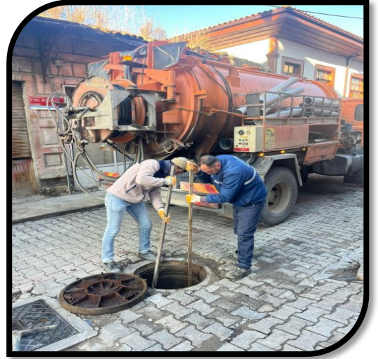
Kanalizasyon Hattı Temizliği
