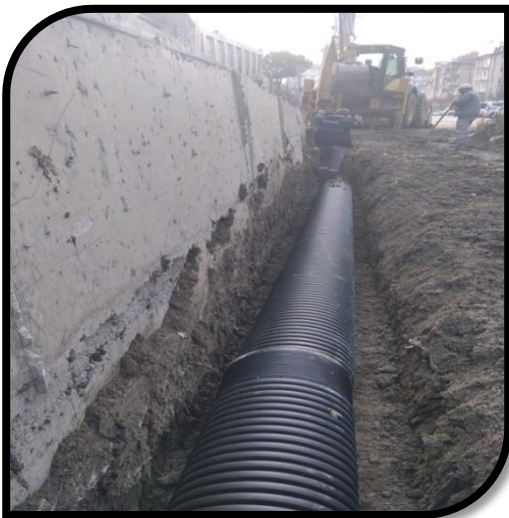
Drenaj Hattı Döşeme
