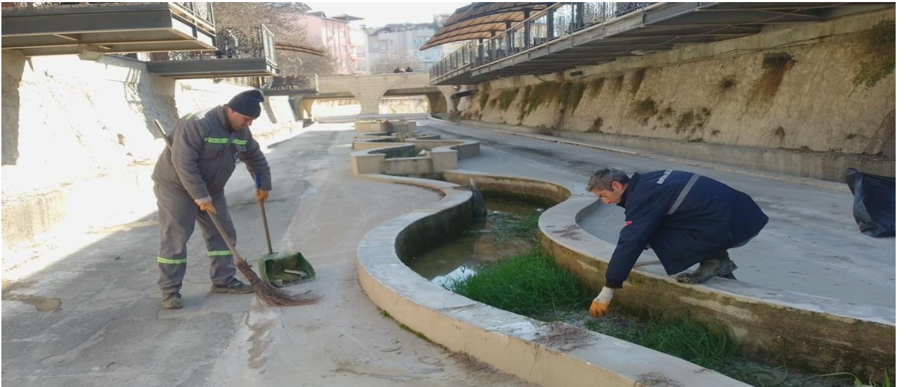
Çay içerisinde kanal temizliği yapılmıştır.
