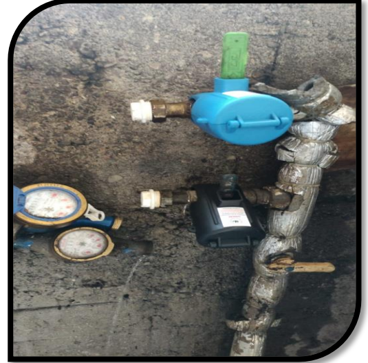
Su Kesimi Sonrası Aparat Takma
