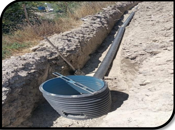
Kanalizasyon Hattı Döřeme
