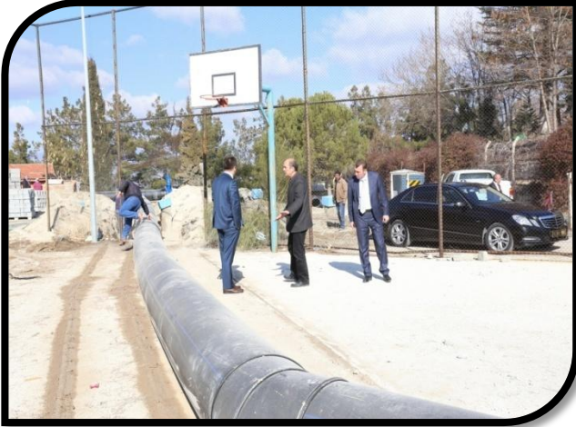
4000 'lük Depo Girişi Bypass Çalışması Yapıldı
