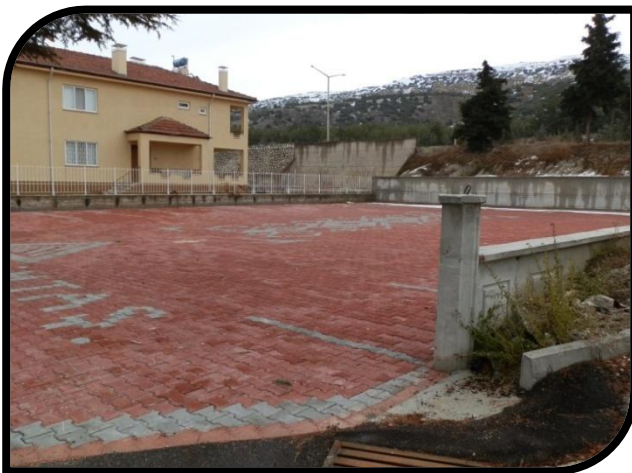
ATATÜRK MAHALLESİ BİMTAŞ TESİSLERİ OTOPARK ALANI VE YOLU KİLİT TAŞ DÖŞENMİŞTİR.
