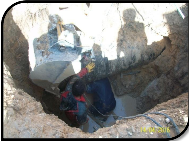
İnsuyu Çelik Boru Tamirâtı
