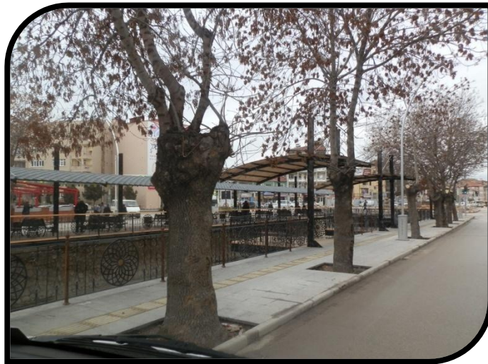
İNÖNÜ MAHALLESİ&YENİ MAHALLE KESİŞİMİ ÇAYBOYU 2. ETAP ÇALIŞMASININ %88 İ TAMAMLANMIŞTIR.
