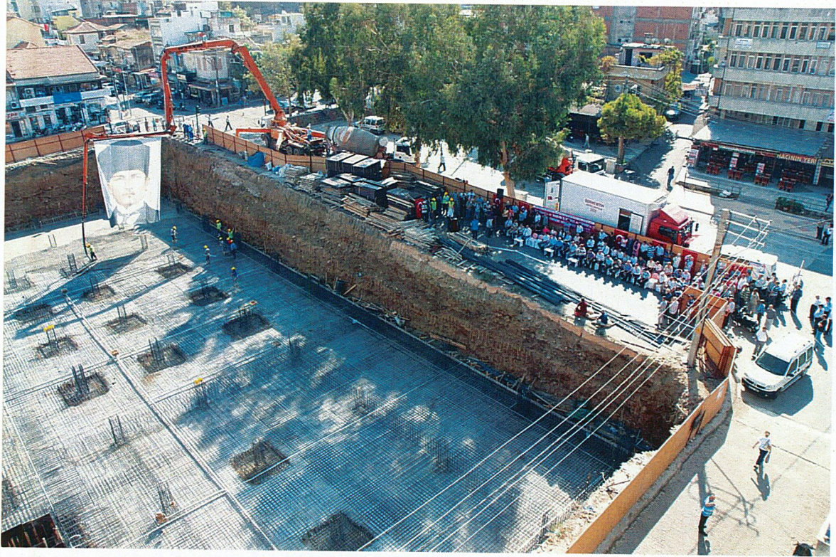
Perakendeci Hali İş Merkezi İnşaatı Temel Atma Töreni (10 Eylül 2014)
