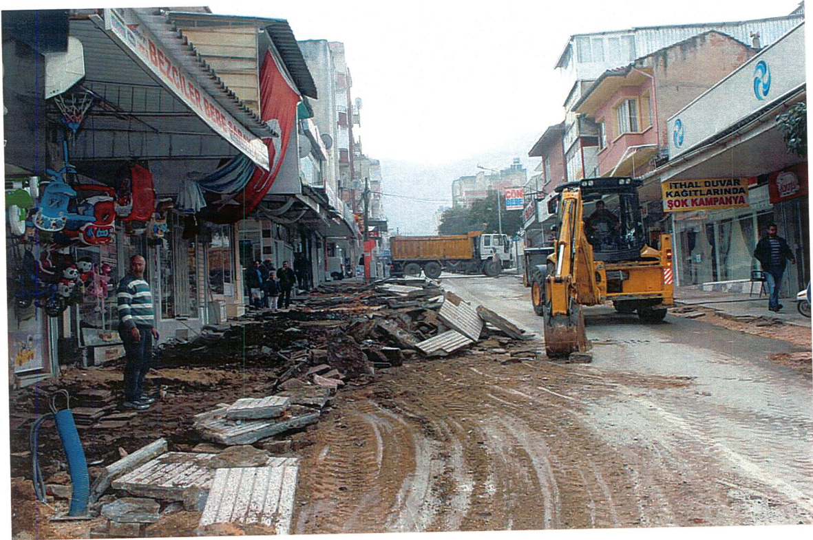
Atatürk Caddesi Kaldırım Çalışmaları
