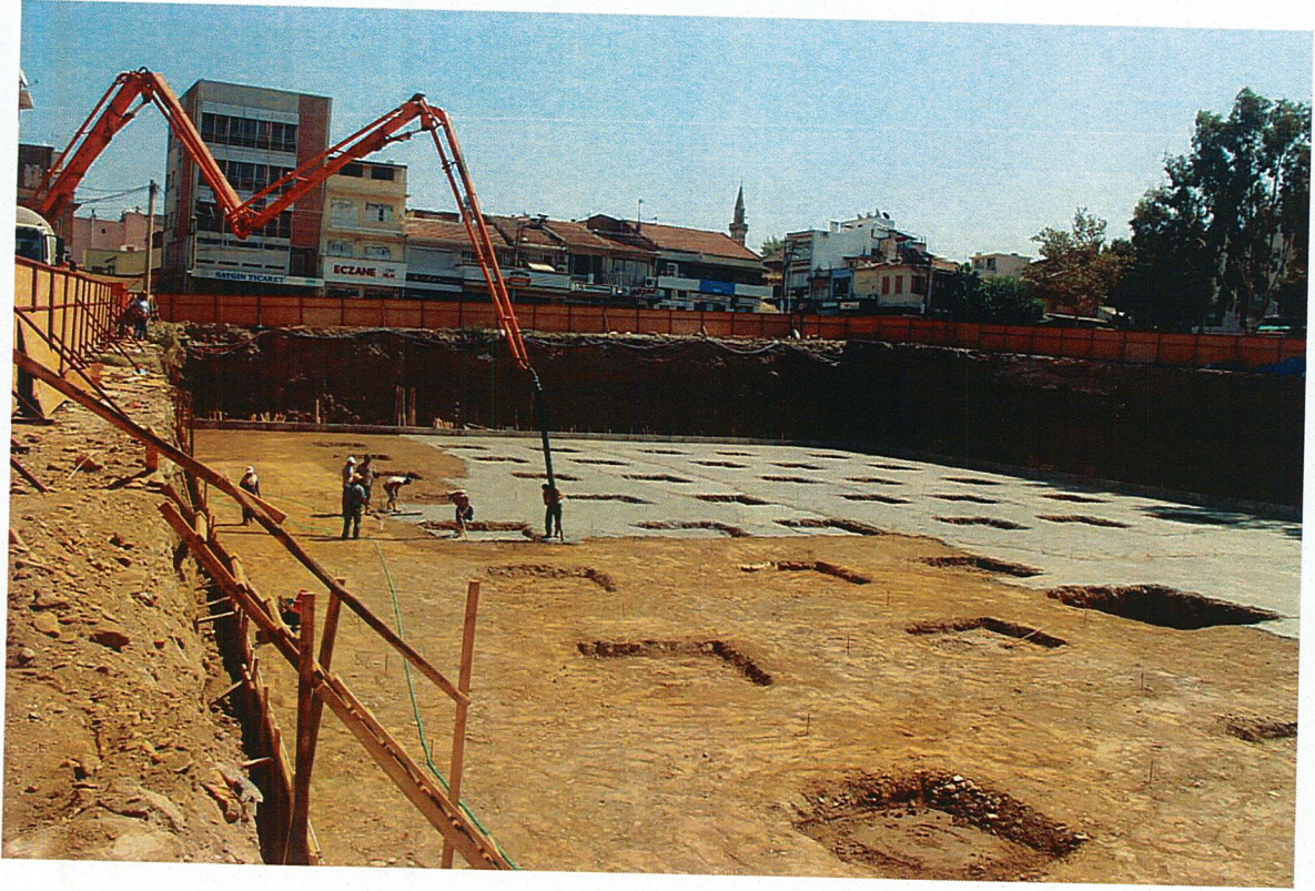
Perakendeci Hali yerine yükselen iş merkezi inşaatı
