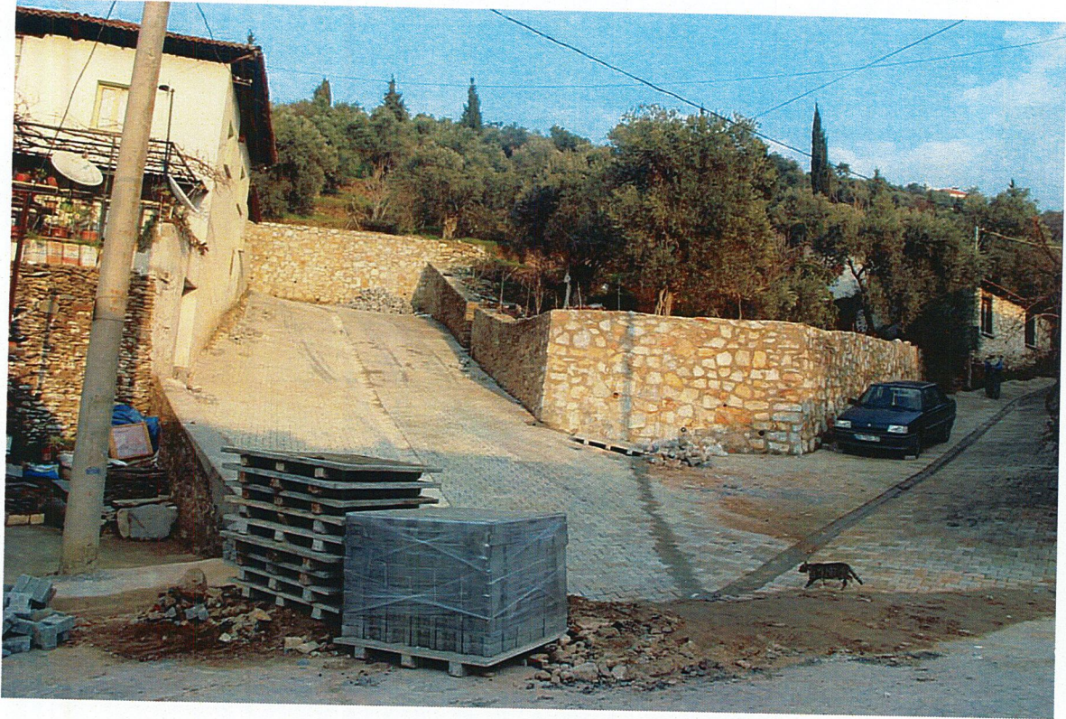
Kırıkdiř Sokak Alt - Üst Yapı alıřmaları
