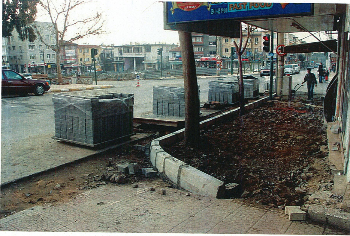
Gümüşpala Caddesi Bordür Çalışmaları
