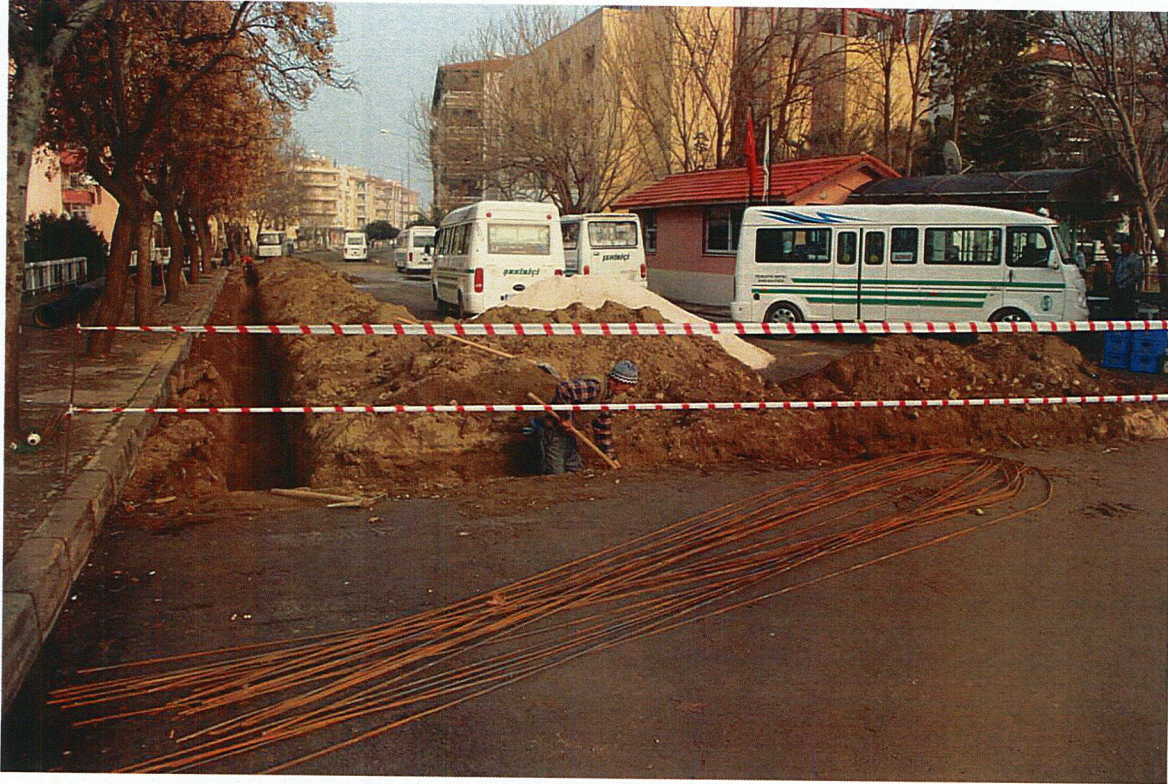
Halil Çulhaoğlu Caddesi Alt Yapı ve Üst Yapı Çalışmaları
