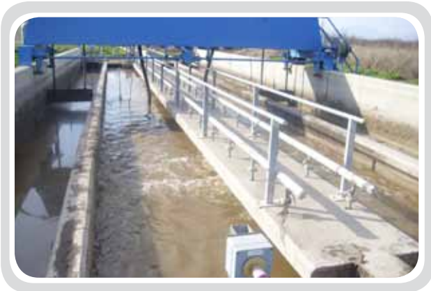
Kum tutucu ve terfi pompa istasyonu
