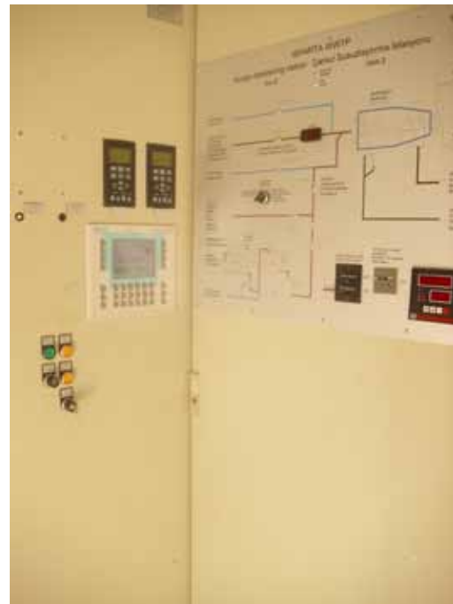
Çamursuzlaşma Ünitesindeki Yeni değiştirilen PLC ve monitörü
