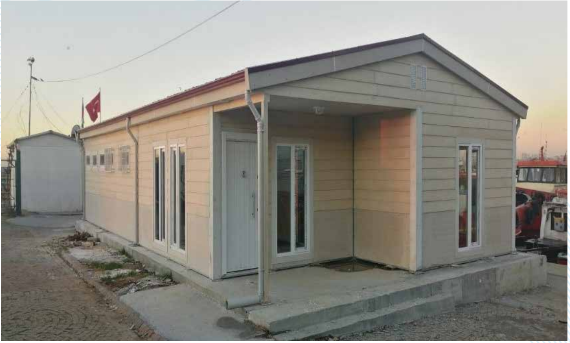
S.G. Avcılar Kolluk Destek Tim Binası İnşaatı
