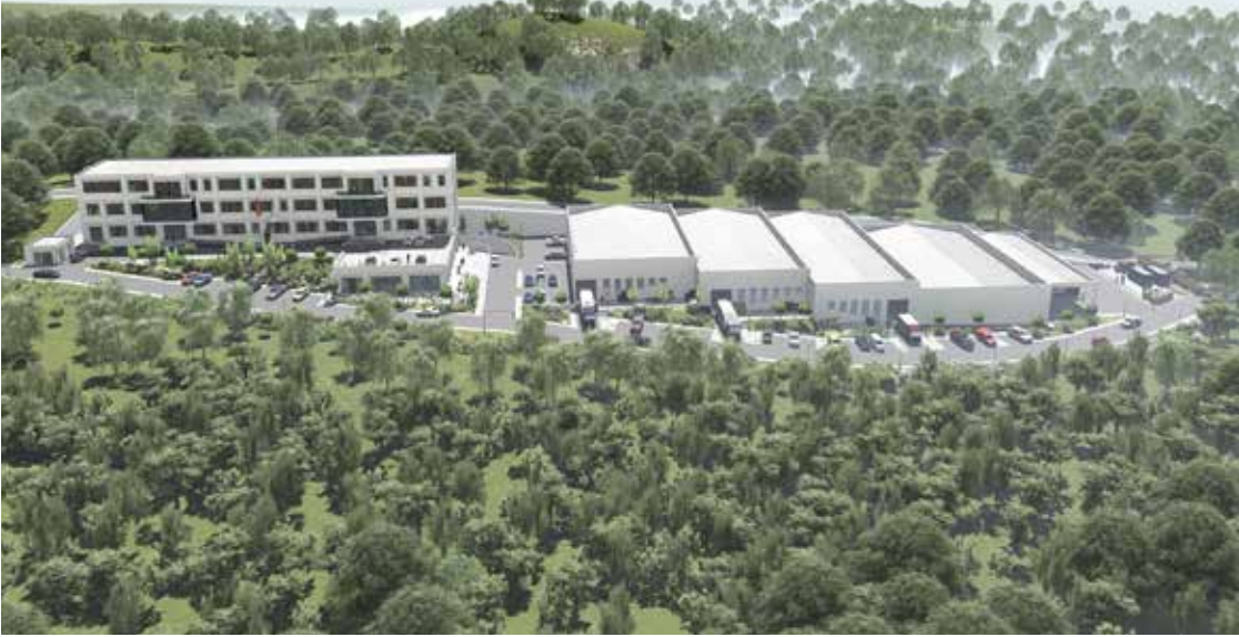
S.G. İkmal Destek K.İği (İzmir) ve Envanter Kontrol Merkezi K.İği İnşaati
