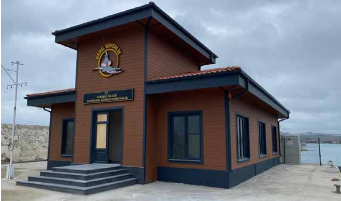
S.G. Silivri Kolluk Destek Tim Binası İnşaatı
