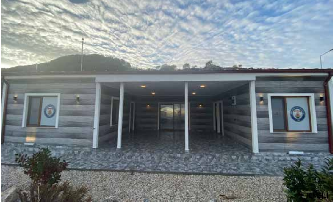
S.G. Kumkale Kolluk Destek Tim Binası İnşaatı
