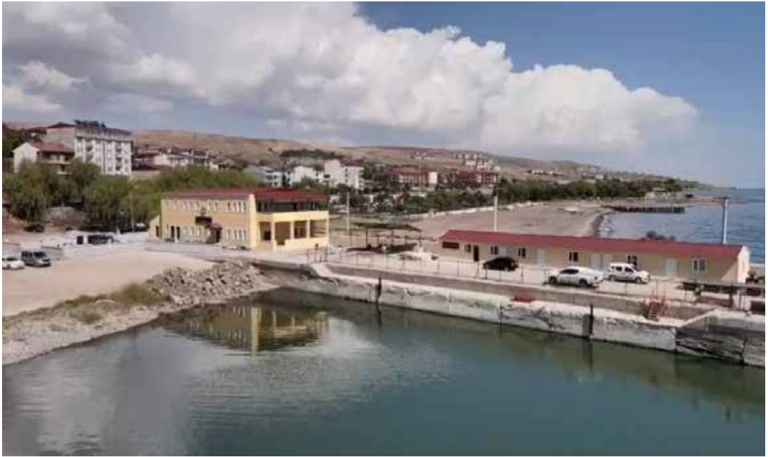
Ahlat S.G. Karakol Komutanlığı İnşaatı
