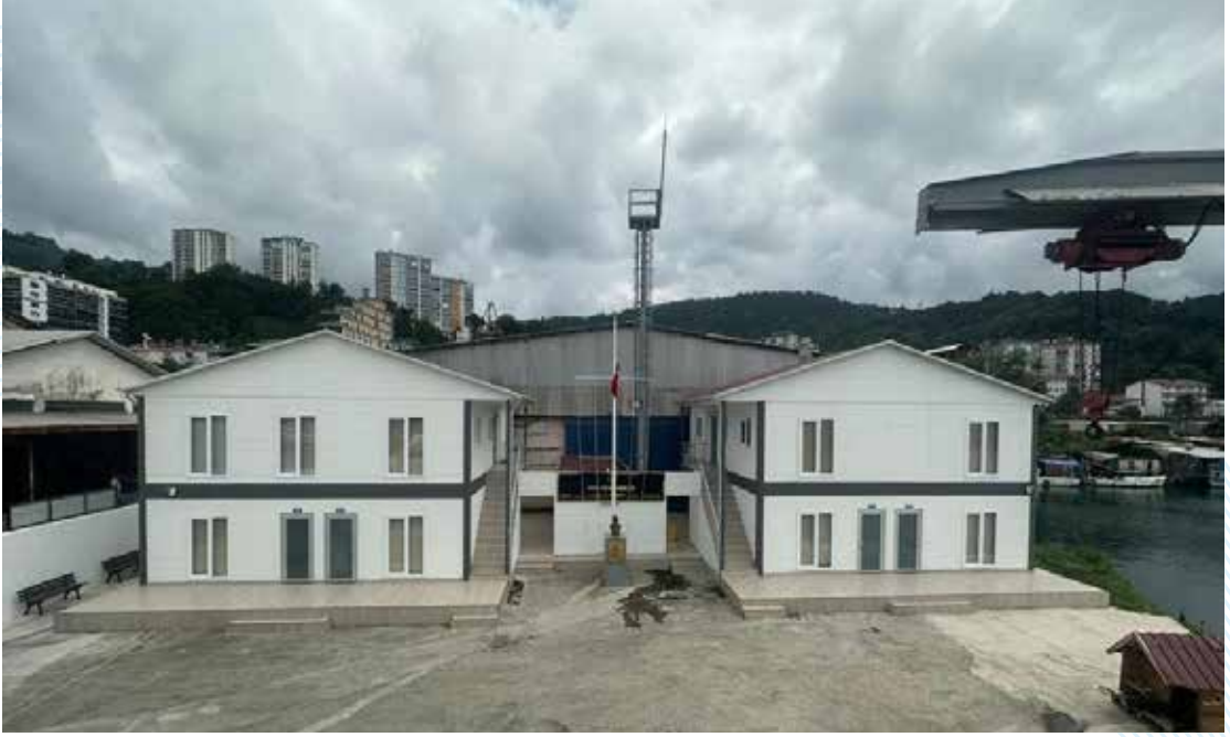
Hopa S.G. Karakol Komutanlığı İnşaatı
