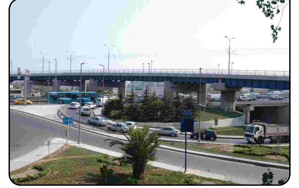
Merter E5 Bağlantı Kavşağı ve Çevre Düzenlemesi
