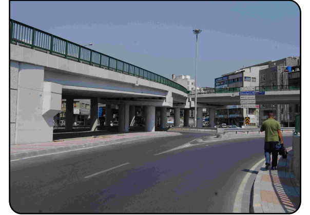
Mehmet Akif Köprülü Kavşağı ve Çevre Düzenlemesi
