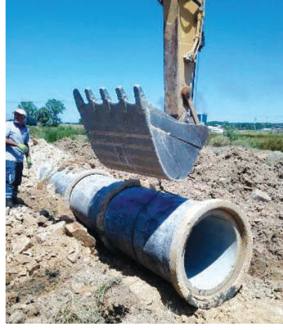
Tepeören Mahallesi Yağmursuyu Kanal Hattı Çalışması
