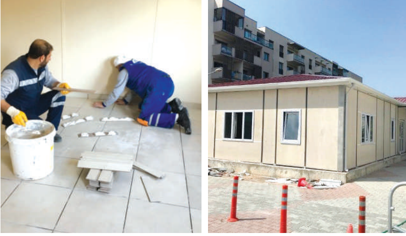
Sosyal Yardımlaşma Vakfı Prefabrik İnşaati
