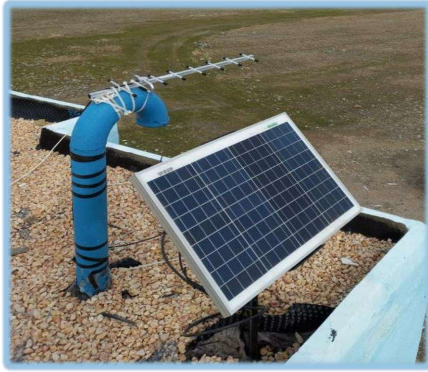
Güneş Panelli Anten Sistemi Kurulma İşi
