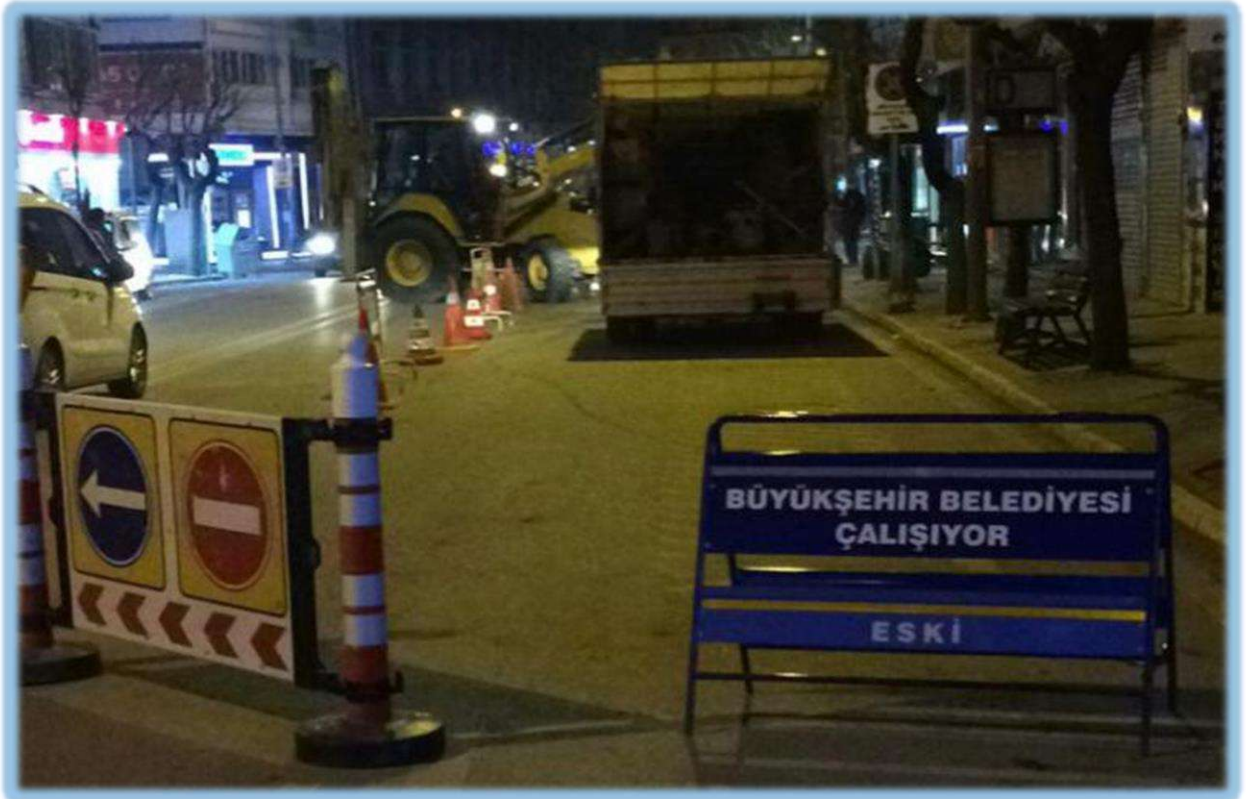
Kent Merkezi Altyapı Çalışmaları
