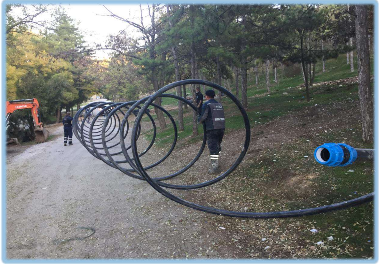
Kaptaj – Drenaj Çalışması
