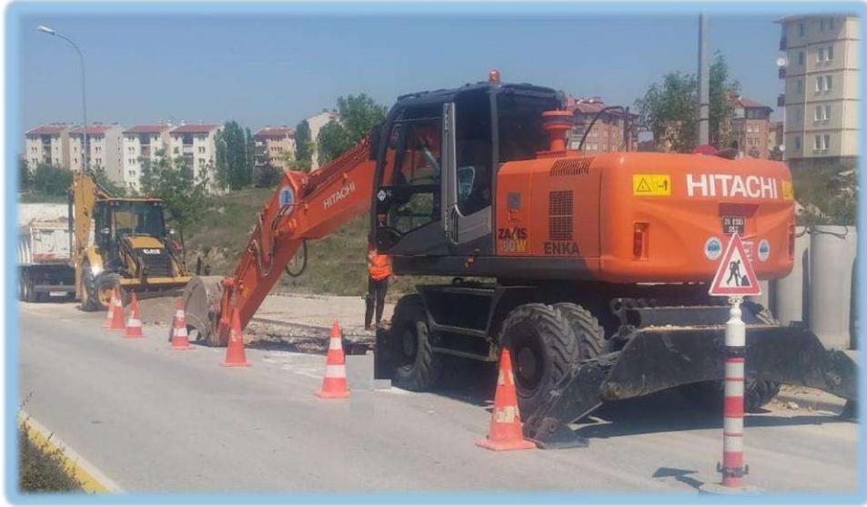
Kent Merkezi Altyapı Çalışması
