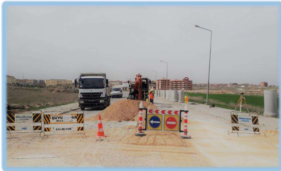
Kent Merkezi Kanalizasyon Hattı Çalışması
