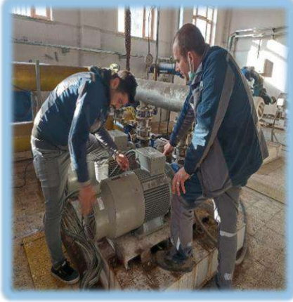
TM3 Terfi İstasyonu Pompa Tadilatı Çalışmaları
