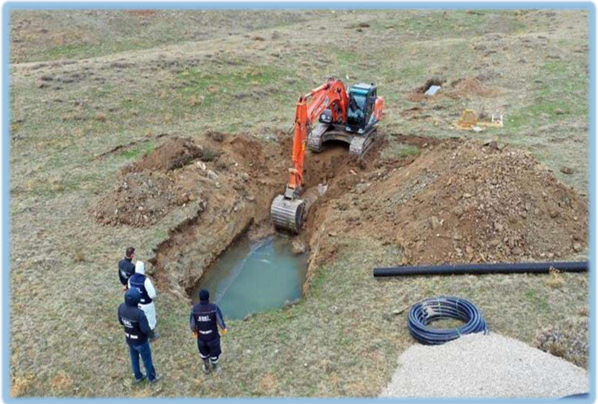
Kaptaj – Drenaj Çalışması
