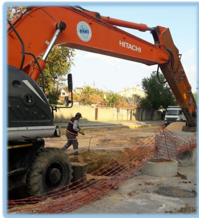
Kanalizasyon Ana Kanal Tamir Çalışması
