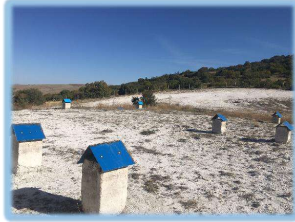
Sultandere Su deposu Baca Kapaklarının Takılması İşi
