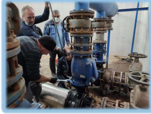
Sazova Atıksu Pompası Montajı
