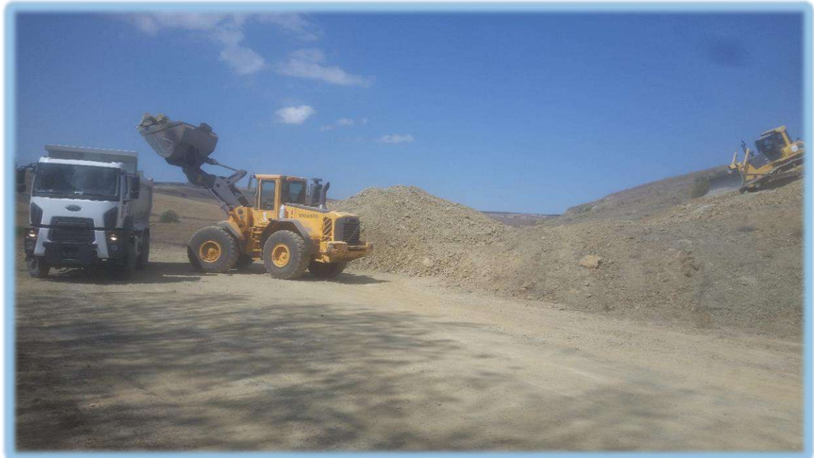
Dolgu Malzemesi Yükleme Çalışması
