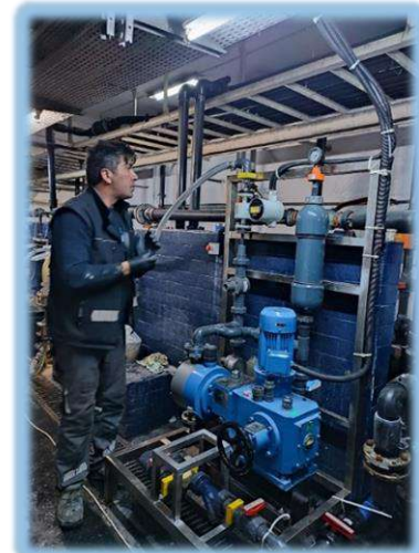
Alüminyum Sülfat Pompası Montajı
