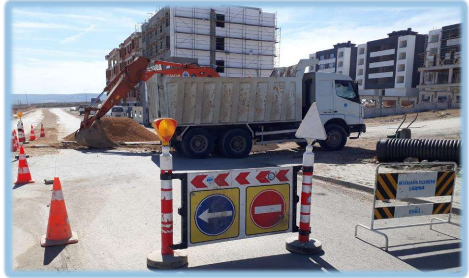
Kent Merkezi Altyapı Çalışması
