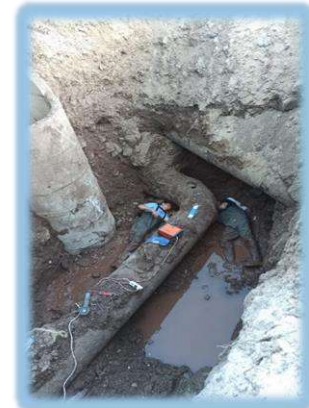
D4 Deposu Hattı Kaynak İşi
