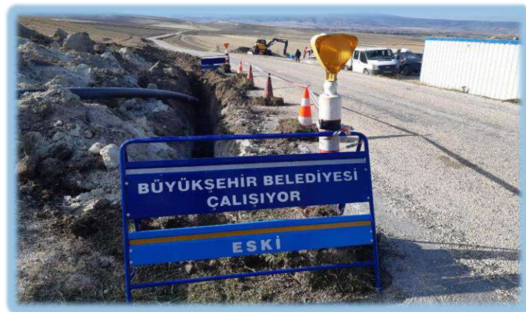
Hat Yapım Çalışması
