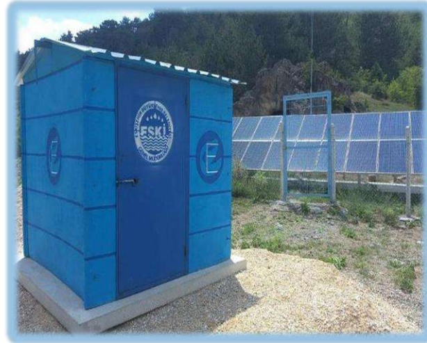
Su Sondaj Kuyu Binası Kurulması İşi
