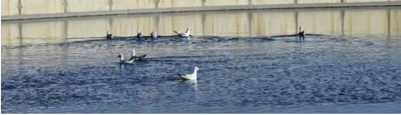
Nizip Atık Su Arıtma Tesisi
