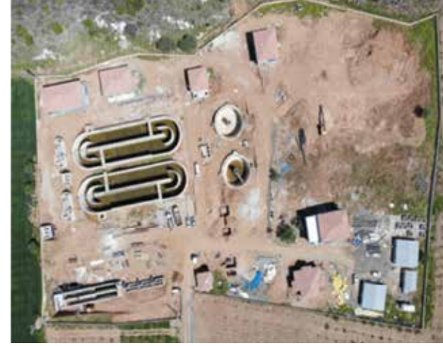
İslahiye Boğaziçi - Yeşilyurt Atık Su Arıtma Tesisi
