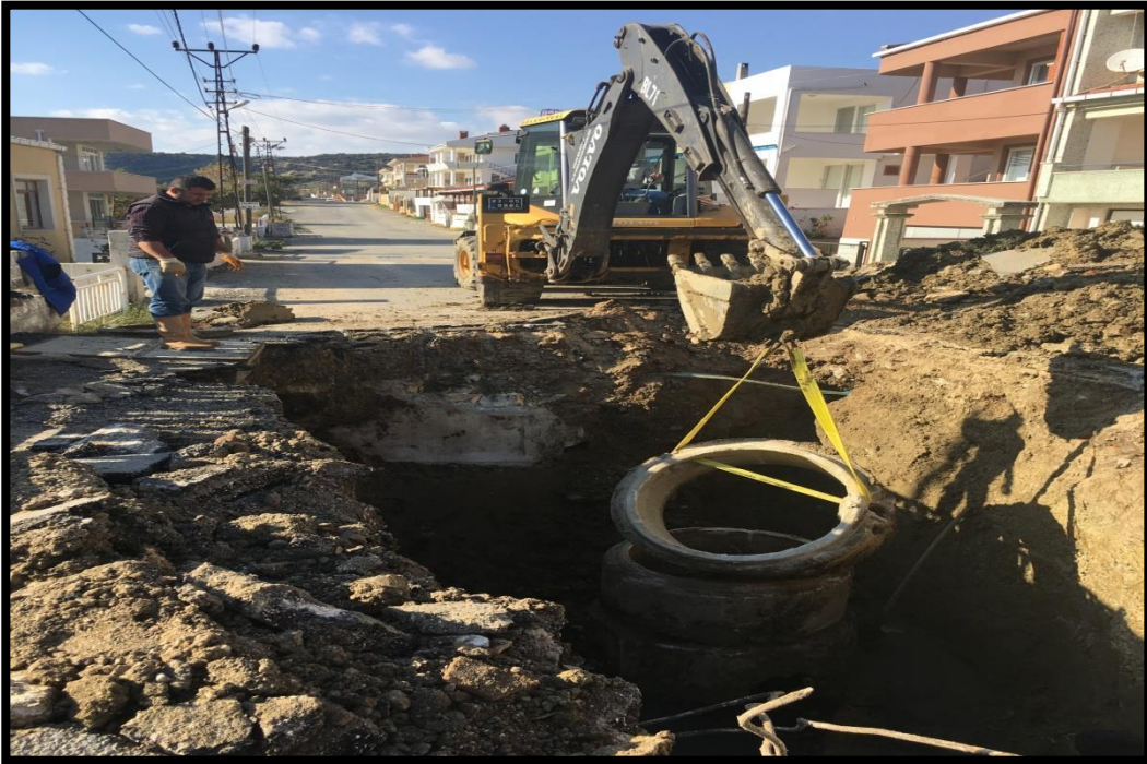
Yayla Liman Caddesi Kanalizasyon Çalışmaları
