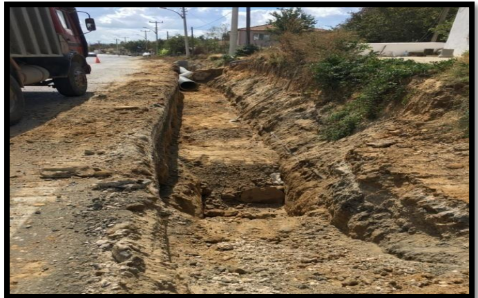
Paşayığıt Mah. Knlz. Şebeke Döşeme Çalışmaları
