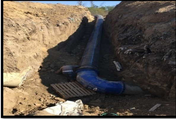
Kumdere Köyü Deplase İşİ
