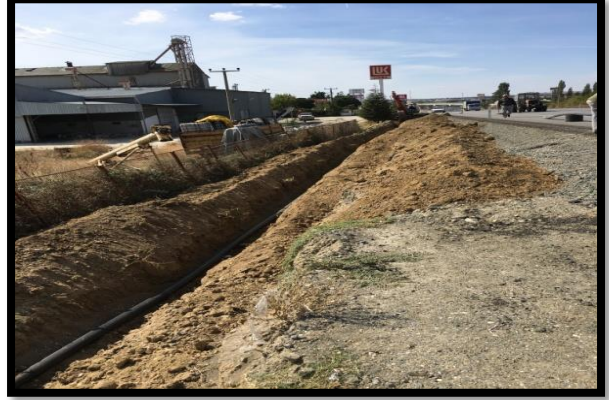
İstanbul Kavşağı Su İshale Hattının Deplasesi
