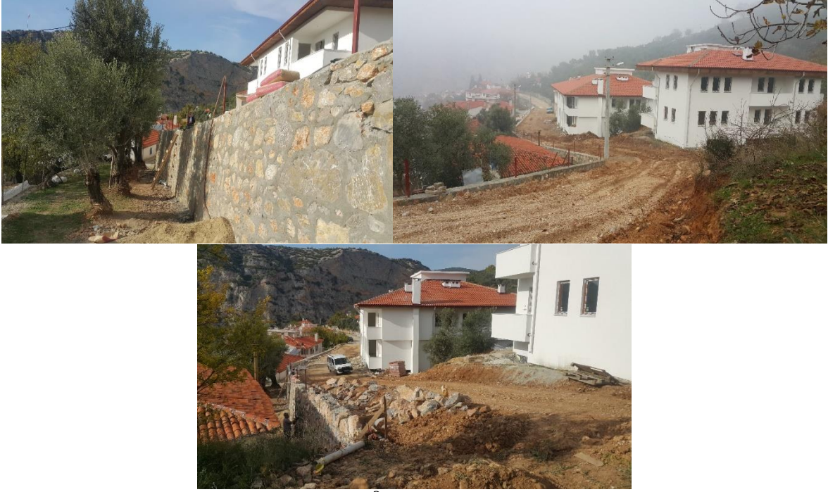
Karşıyaka mahallesi yüksek sokakta 120 m 3 taş istinat duvarı yapılarak yol kullanıma açılmıştır.
