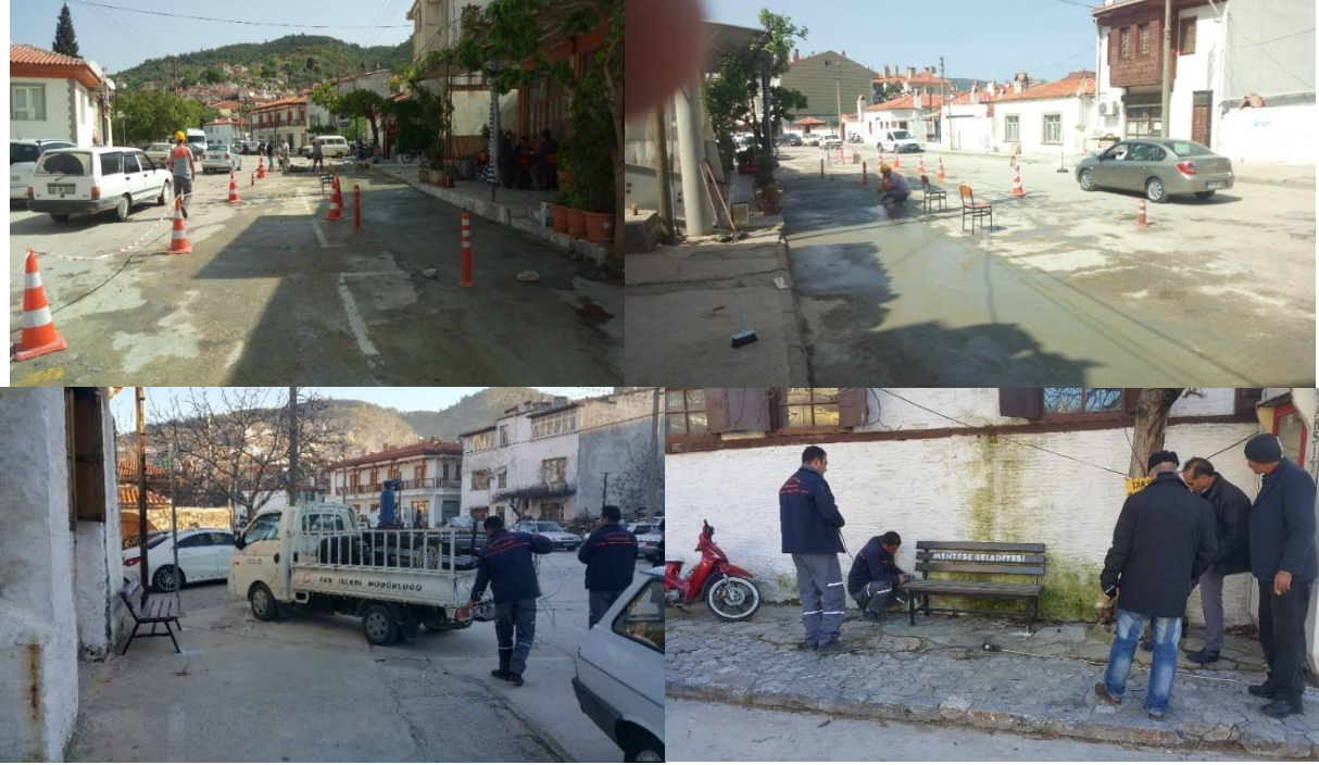
Kara muğla caddesi üzeri uygun alanlara bank yerleştirilmiş ve beton yol tamirat çalışmaları yapılmıştır.
