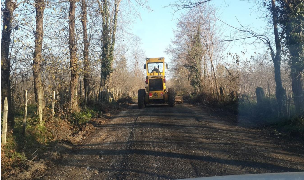
İlçemizde Yapmış olduğumuz yol yapım çalışmalarımızdan bir kesit
