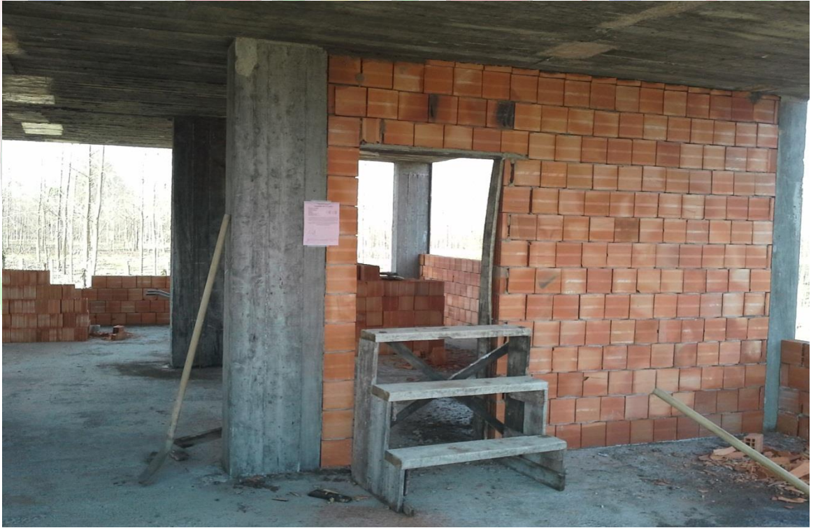
Yapı Kontrol servisi personeli sahada Kaçak Yapı Mühürleme Yaparken çalışma esnasında
