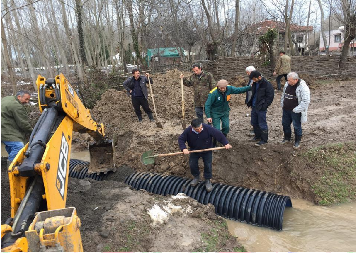
Belediye Ekiplerimiz Yol üstündeki Su Geçişlerine korige boru yerleştirilmesinden bir kesit
