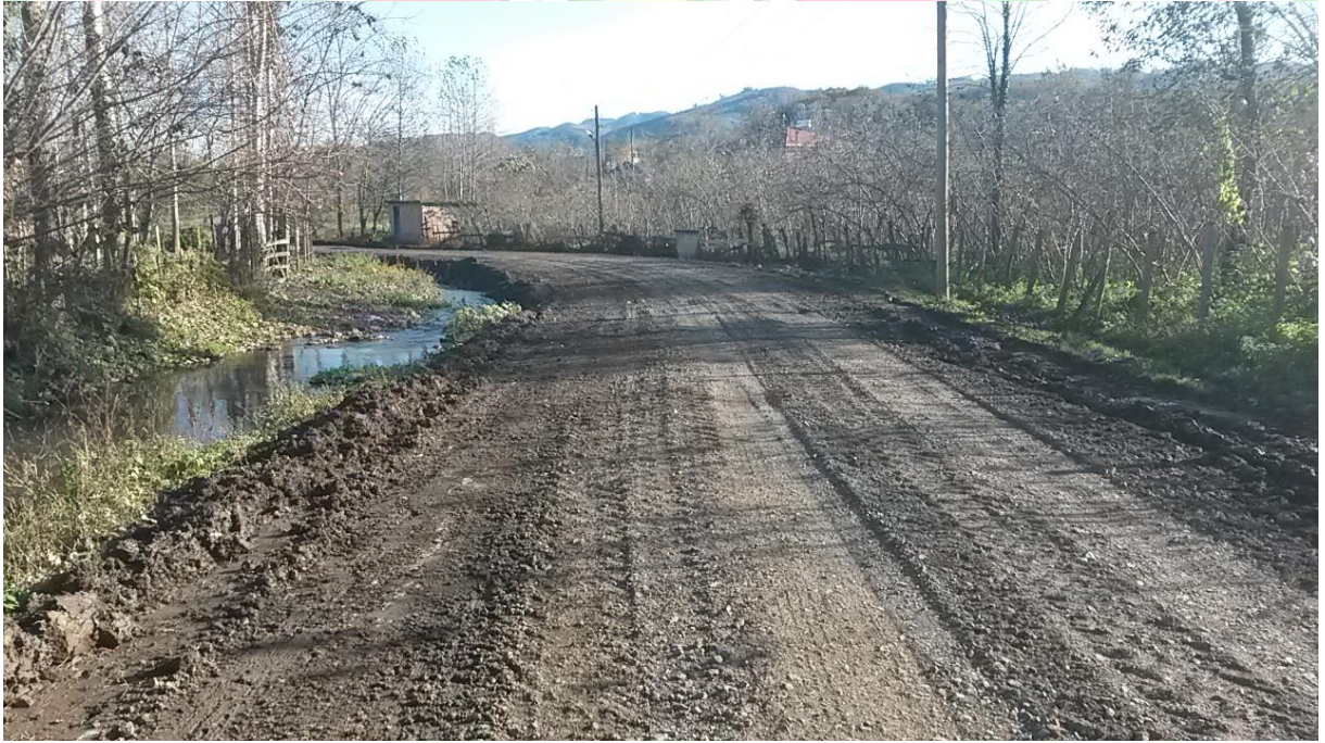
İlçemizde Greyder ile Yol Düzeltme Çalışmalarımızdan bir kesit
