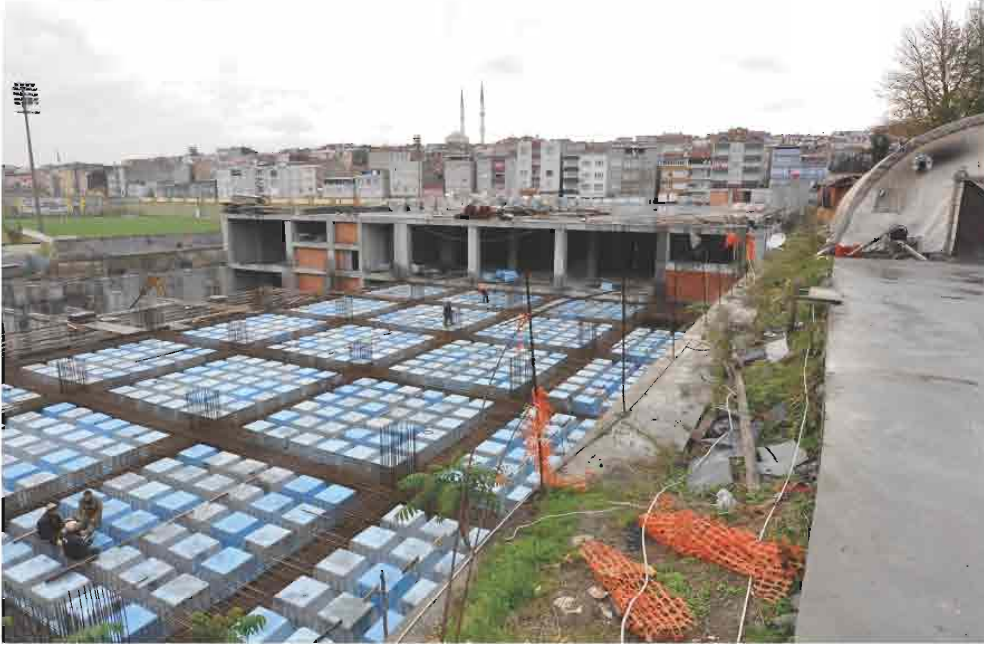
Uygur Caddesinde yer alan 5'i Bir Yerde hizmet yerinin inşaatından bir görünüm.
