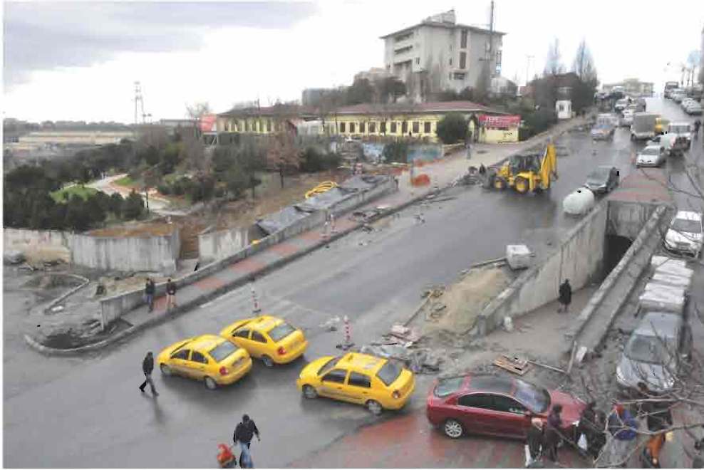
Kocatepe Metro çıkışında yer alan alt geçit inşaatından bir görünüm.
