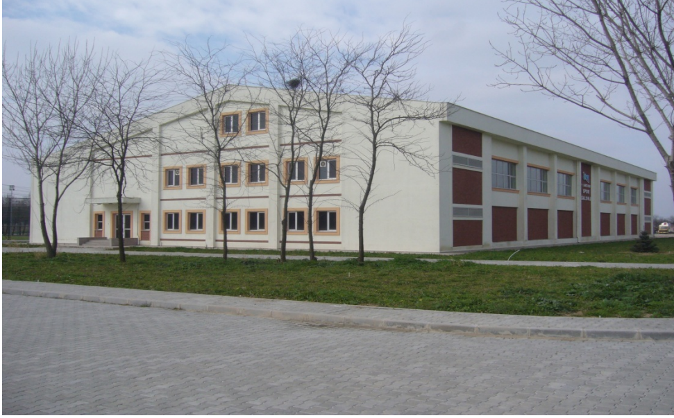
500 Kişilik Kapalı Spor Salonu Ön Cephe Görünüşü
