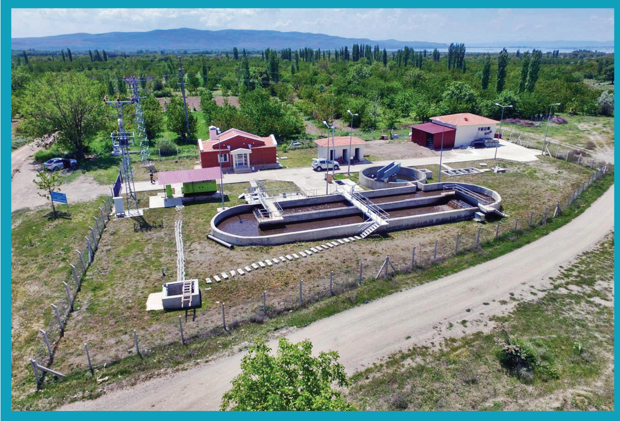
Gümüşsu Atıksu Arıtma Tesisi
