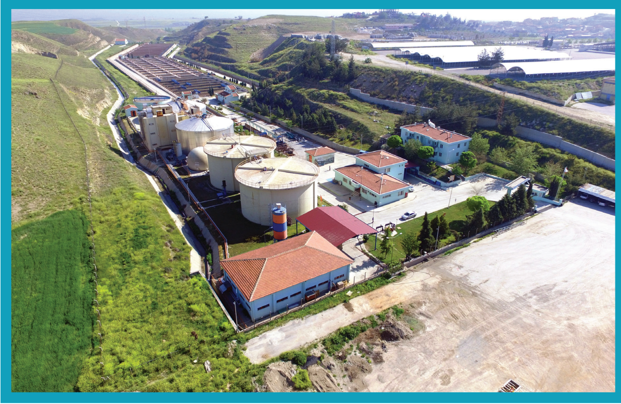
Merkez Atıksu Arıtma Tesisi
