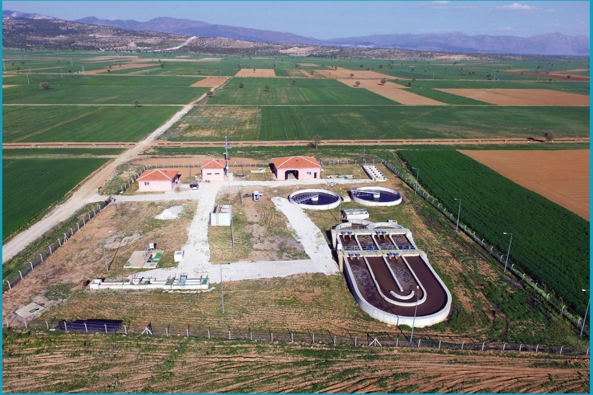
Serinhisar Atıksu Arıtma Tesisi
