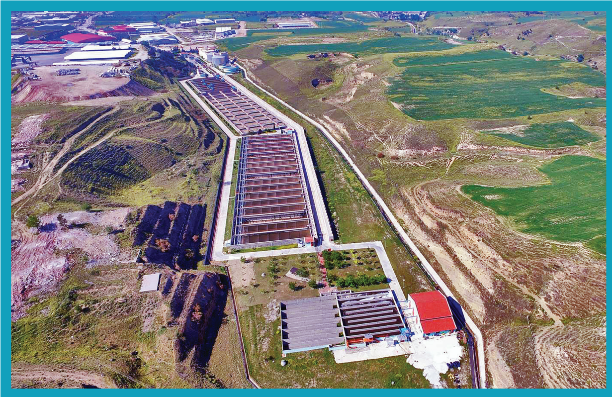
Merkez Atıksu Arıtma Tesisi
