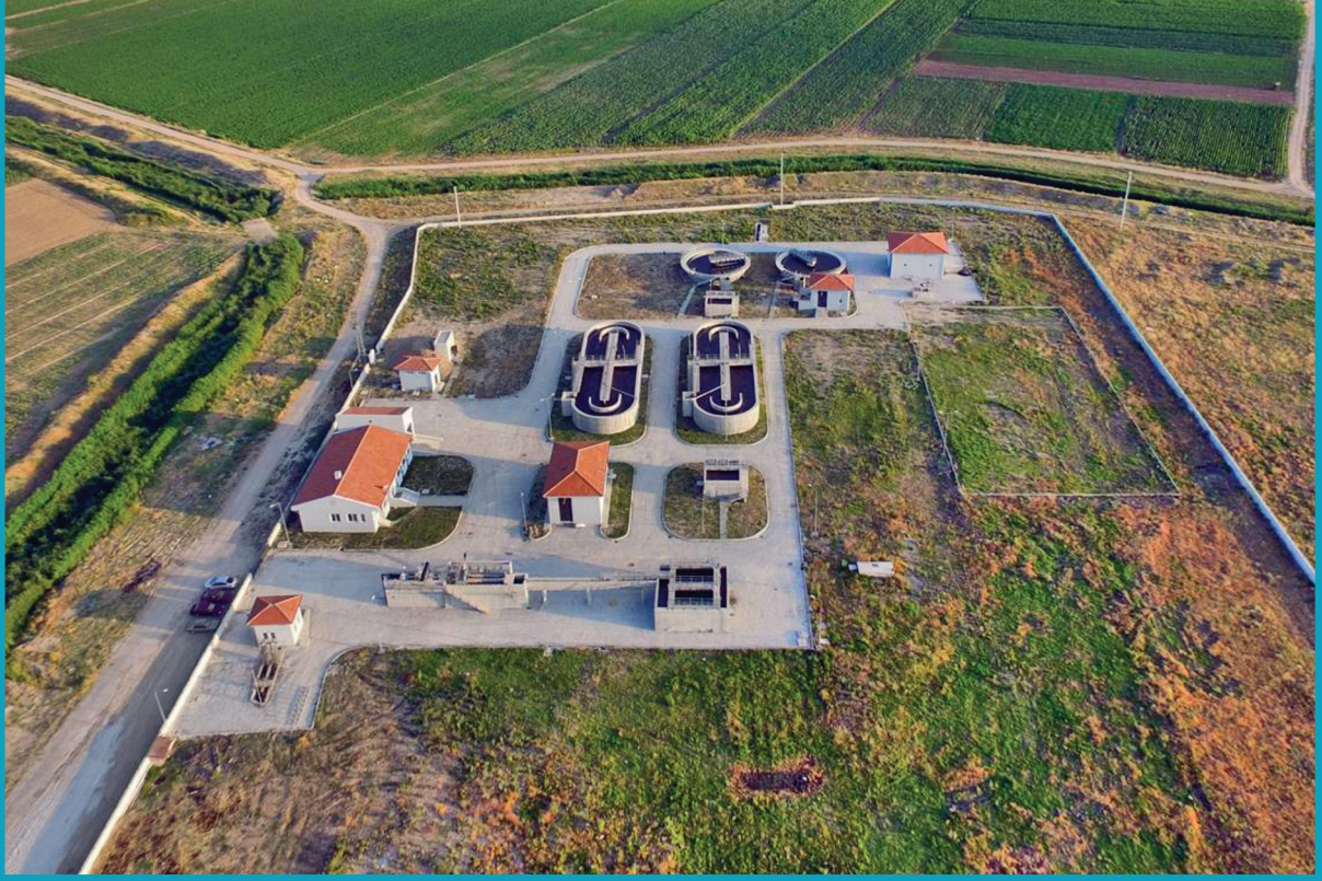
Çivril Atıksu Arıtma Tesisi
