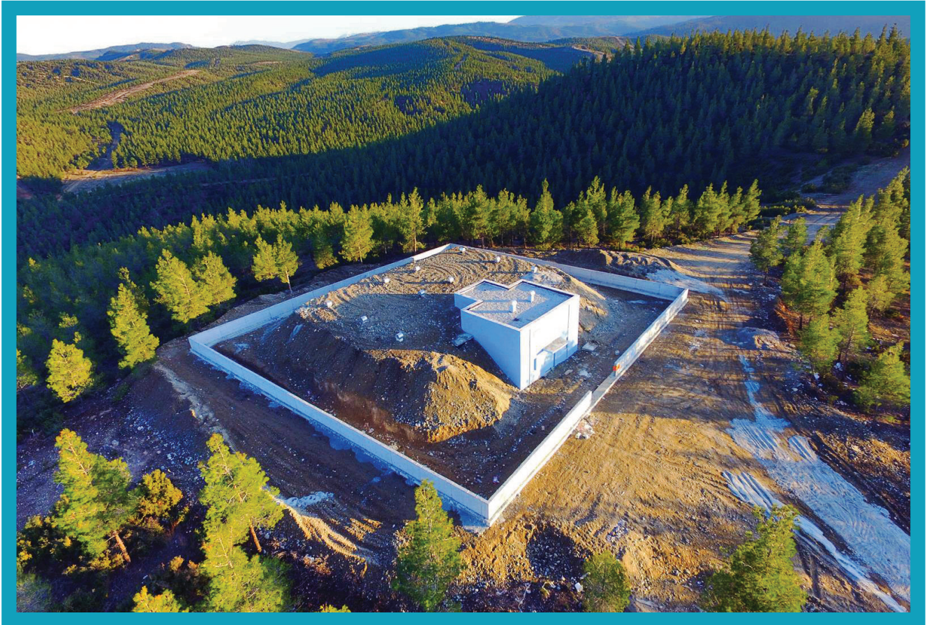
Honaz-Bozkurt İçmesuyu Deposu
