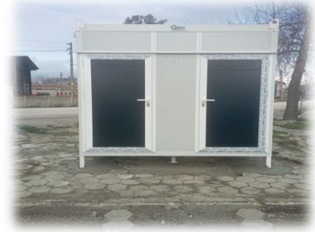
Kozyörük Mahallesi Portatif Tuvalet Kurulumu
