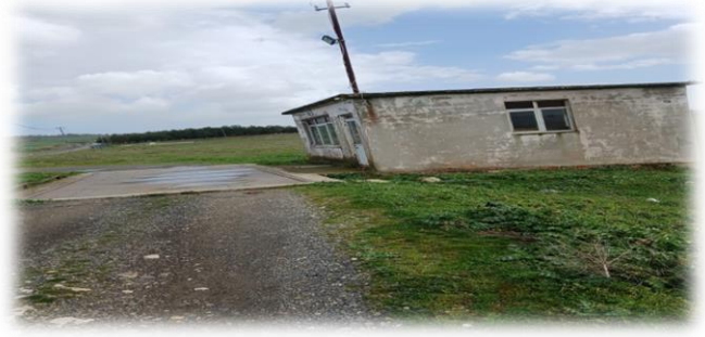
Balabancık Mahallesi 40 Ton Kapasiteli Taşıt Kantarı
