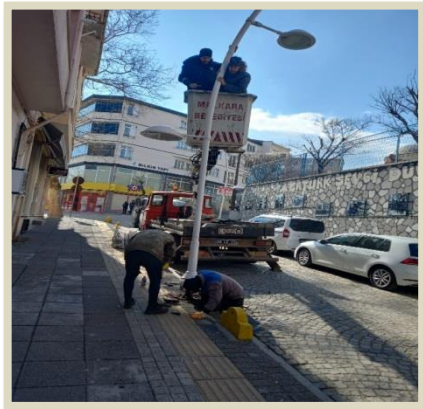
Cadde Aydınlatma Sistem Onarımları
