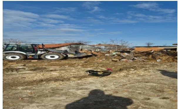
Balabancık Mahallesi yanan evin enkaz atımı
