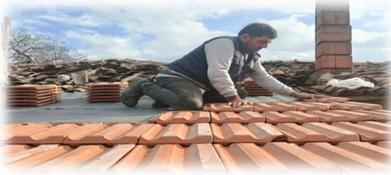
Kalaycı Mahallesi Köy Tuvaletleri Çatı Onarımı
