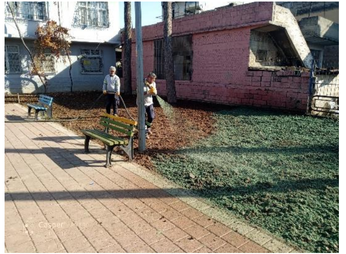
Tesislerimizde Hydroseeding Yöntemi Çim Ekimi Uygulaması
