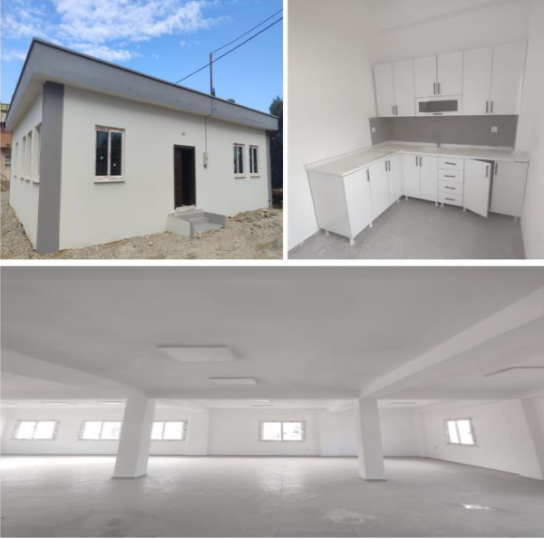
Mürseloğlu Mahallesi Taziye Evi Yapılması;
