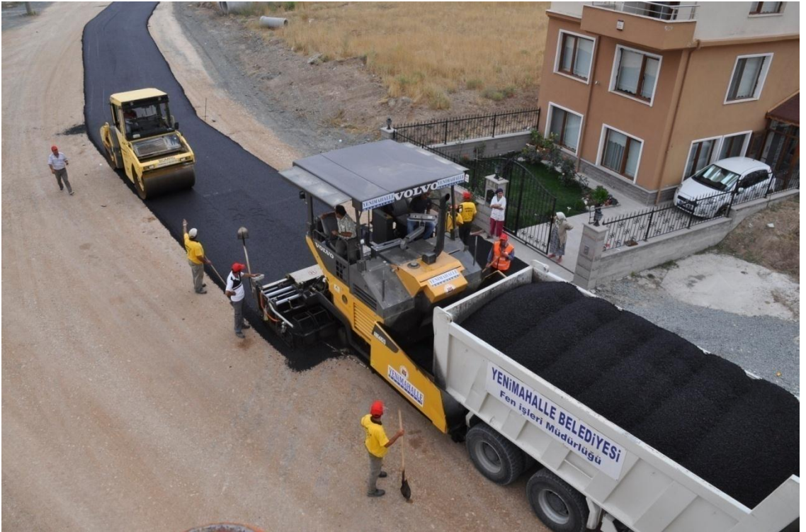
Asfalt Serim Çalışması
