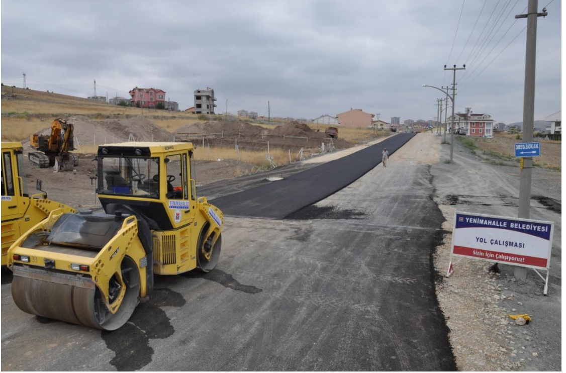
Asfalt Serim Çalışması
