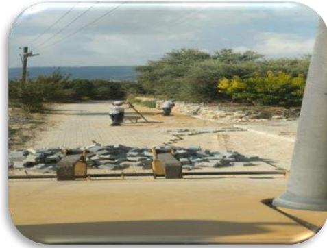
TAŞKUYU MAHALLESİ PARKE DÖŞEME ÇALIŞMASI
