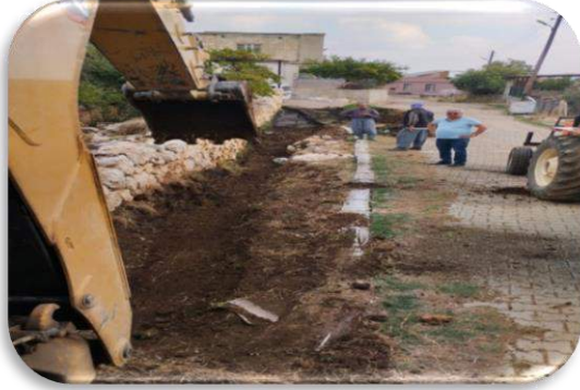
KIZILÇUKUR MAHALLESİ DRENaj AÇMA ÇALIŞMASI
