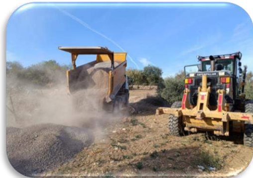
GÖÇÜK MAHALLESİ YOL BAKIM VE ONARIM ÇALIŞMASI
