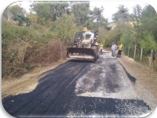
KURTÇUKURU MAHALLESİ ASFALT YAMA ÇALIŞMASI
