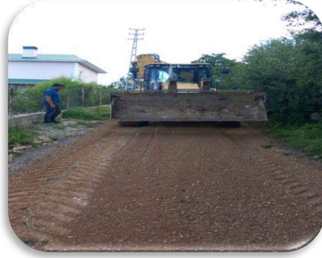
ZİFTLİK MAHALLESİ YOL BAKIM VE ONARIM ÇALIŞMASI
