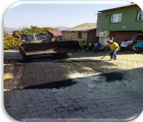
BOZTEPE MAHALLESİ ASFALT YAMA ÇALIŞMASI
