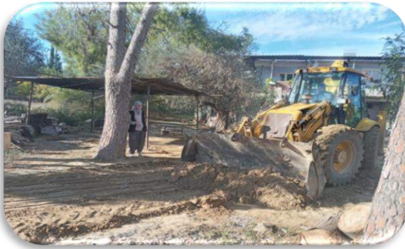
KARADİRLİK MAHALLESİ MİL TEMİZLEME ÇALIŞMASI
