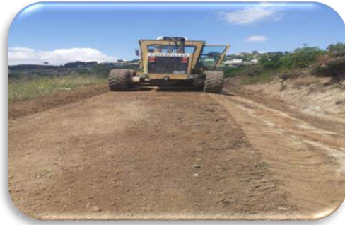
BOZTEPE MAHALLESİ TESVİYE ÇALIŞMASI
