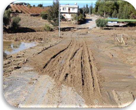
CİN MAHALLESİ AFET SONRASI KONTROL
