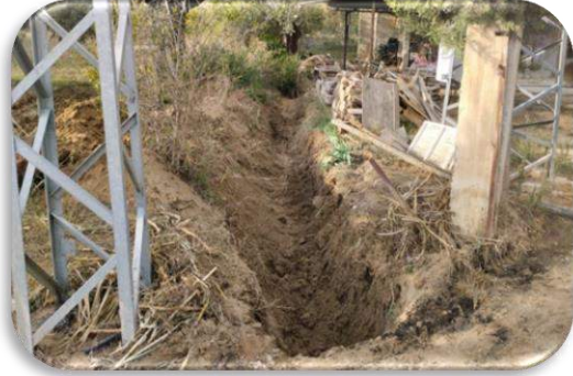
KARADİKEN MAHALLESİ DRENaj AÇMA ÇALIŞMASI
