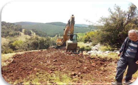
SANLICA MAHALLESİ YOL AÇMA ÇALIŞMASI
