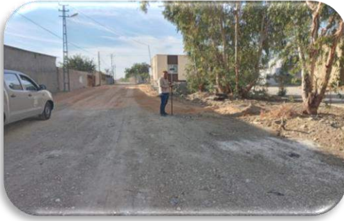
ÇİÇEKLİ MAHALLESİ YOL ÖLÇME ÇALIŞMASI
