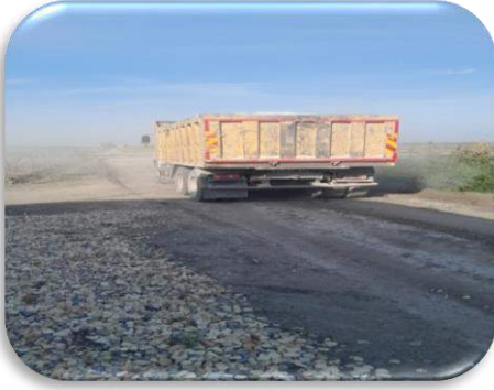
BAHŞIŞ MAHALLESİ YOL BAKIM VE ONARIM ÇALIŞMASI
