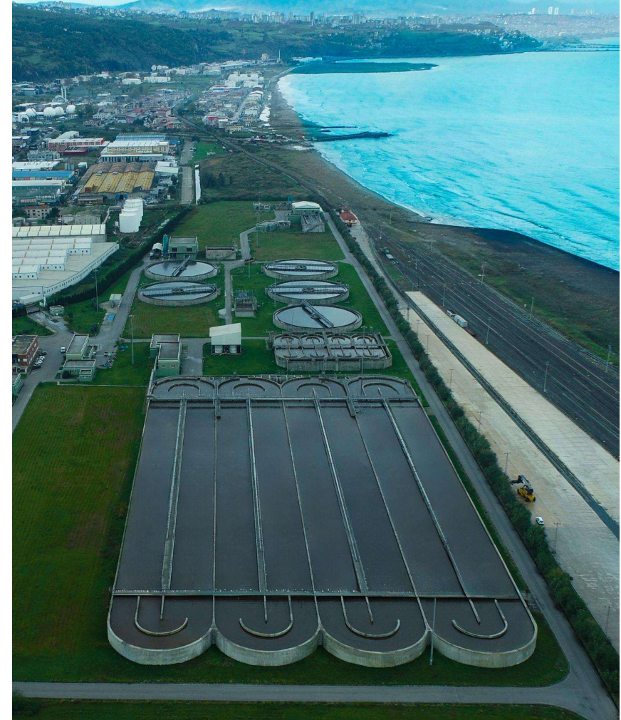
Doğu İleri Biyolojik Atık Su Arıtma Tesisi
