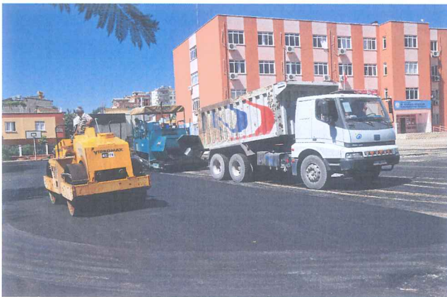
Okul Bahçesi Asfaltlanması çalışmalarından bir örnek
