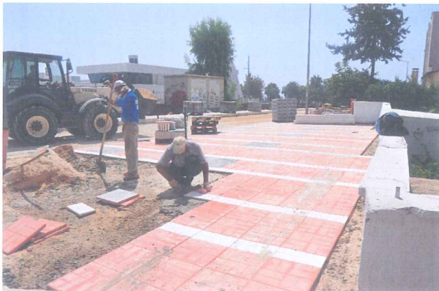
Karo kaldırım ve yol gövdesi yapım çalışmaları
