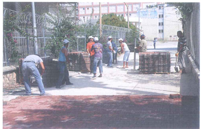
Kilit Parke yapım çalışmaları
