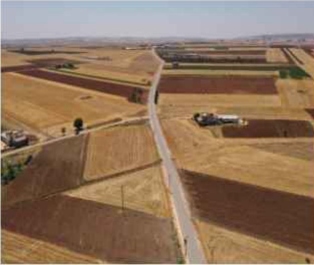
Şehitkamil Uğurca Mahallesi Yolu Sathi Kaplama Yapım Çalışması
