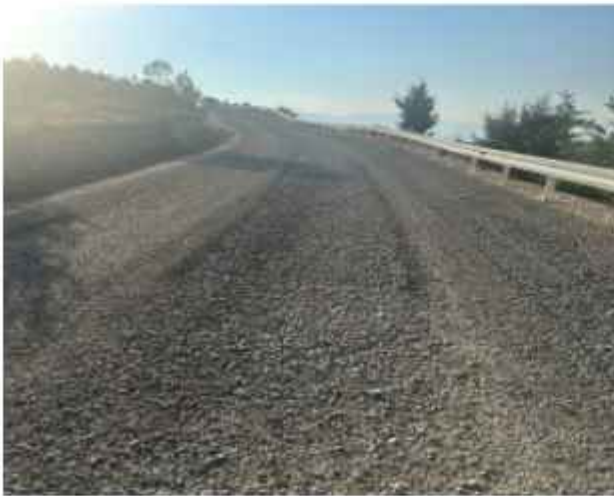
Nurdağı İlçesi Çakmak Mahallesi Yolu Sathi Kaplama Yapım Çalışması
