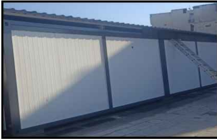
Çatı Onarım Çalışmaları
