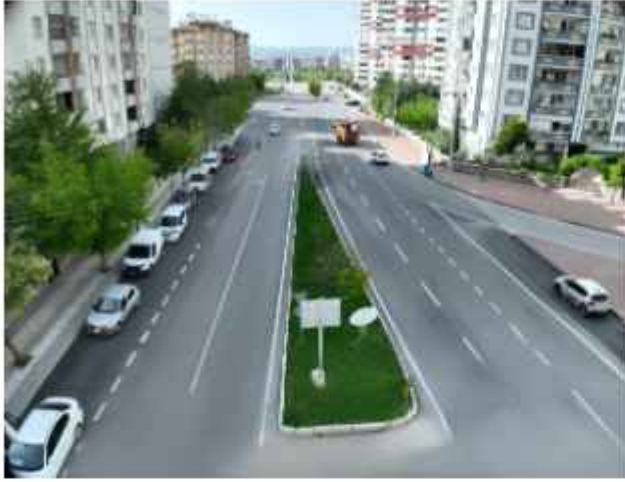
Karataş Mahallesi 394 Nolu Cadde
