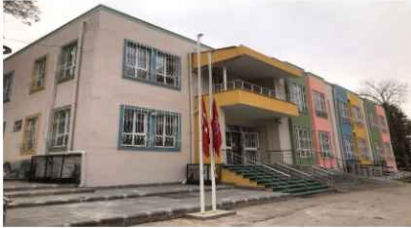
Alleben Mahallesi Kreş Binası Bakım Onarım Yapım İşi
