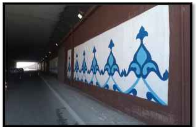
Sanat atölyesi köprü onarım çalışmaları
