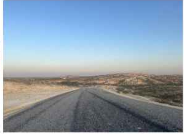
Sekili Köy Yolu Sathi Kaplama Yapım Çalışması
