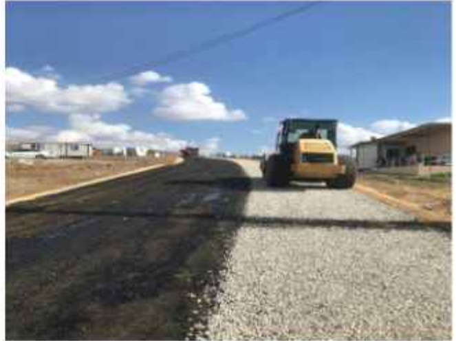
Şehitkamil İlçesi Altınova Mahallesi Yolu Sathi Kaplama Yapım Çalışması
