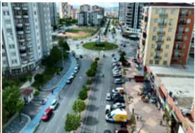
Karataş Mahallesi 398 Nolu Cadde
