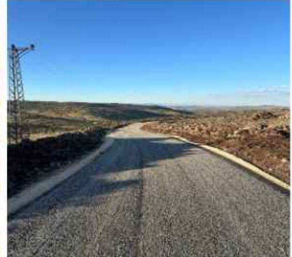
Şehitkamil İlçesi Bağbaşı Mahallesi Yolu Sathi Kaplama Yapım Çalışması
