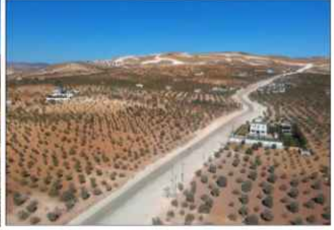
Nizip Fıstıkkent Bölgesi İmar Yolları Açılması Yapımı
