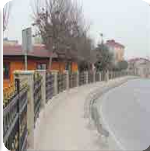
Çevre Duvarı Yapımı Yeni Hali
