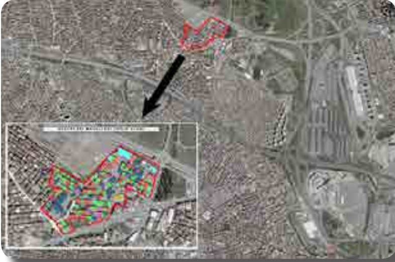
Havaalanı Mahallesi Riskli Alan Bölgesi
