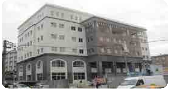
Hükümet Konağı İnşaat Çalışmaları
