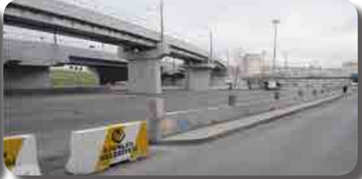
Yavuz Selim Mahallesi Otopark Çalışmaları
