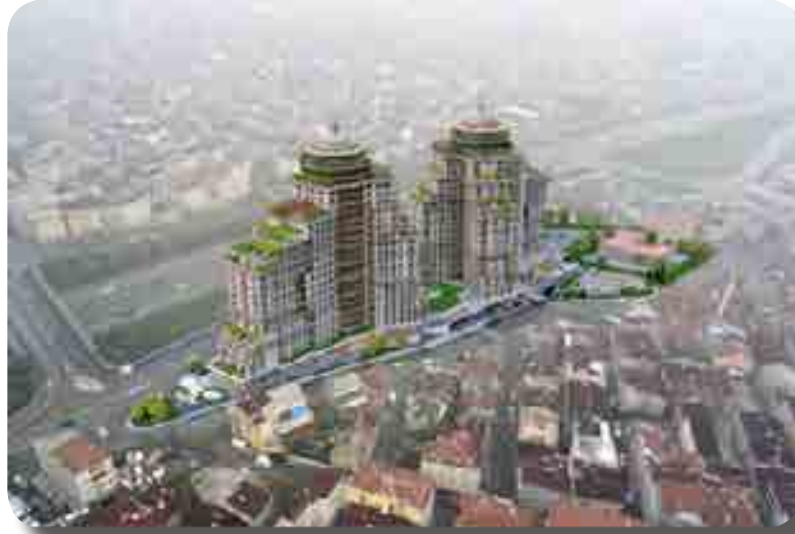
Tuna Mahallesi Riskli Alan Bölgesi
