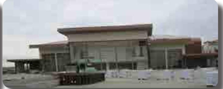
Kültür Merkezi İnşaat Çalışmaları
