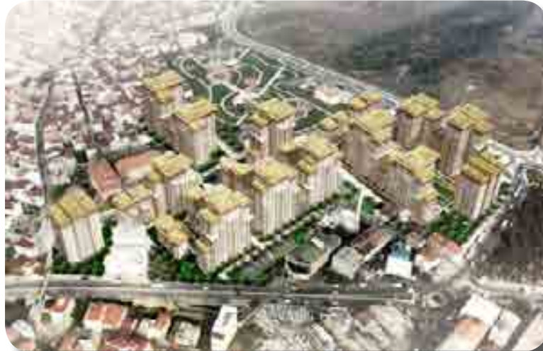
Havaalanı Mahallesi Riskli Alan Bölgesi
