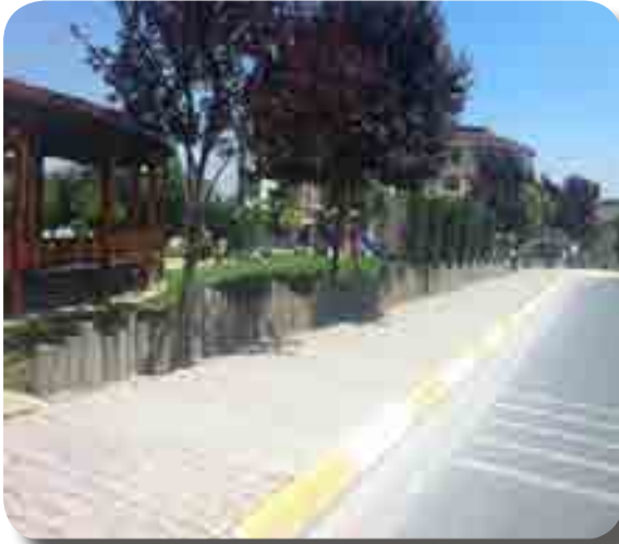
Çevre Duvarı Yapımı Eski Hali
