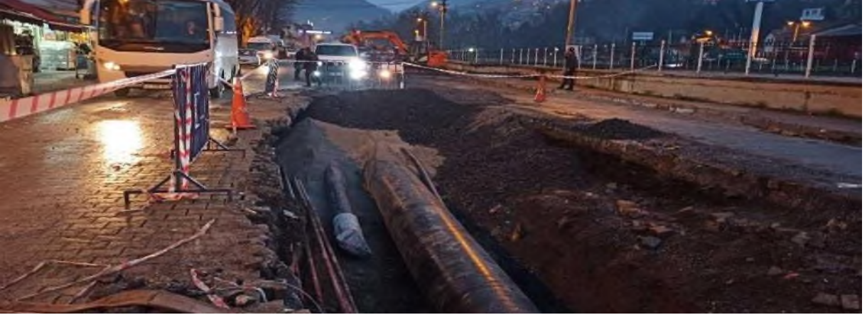
AYNI BÖLGEDE BULUNAN ÖMRÜNÜ DOLDURMUŞ PİK DÖKÜM VE ÇELİK HATLARIN YERİNE POLİETİLEN İCMESUYU HATLARI DÖSENDİ
