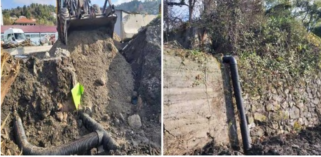
İnağzı Mahallesi: Belediye Garaj Amirliği altı (Toplam: 70m. Kanalizasyon yenileme işi yapılmıştır.)
