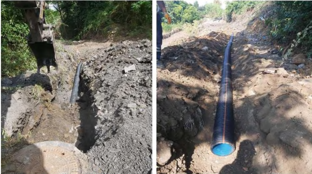
Yayla Mahallesi: Fener Cad. (Toplam:200m. Kanalizasyon yenileme işi yapılmıştır.)
