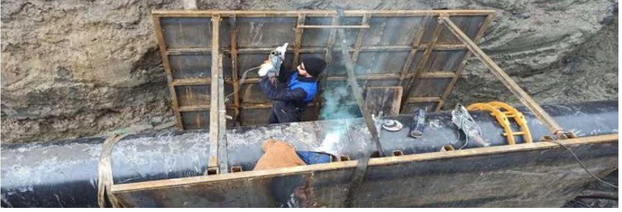
DERİN KAZIDA HENDEK İÇERİSİNDE KAYNAK YAPIMI SIRASINDA İKSA UYGULAMASI
