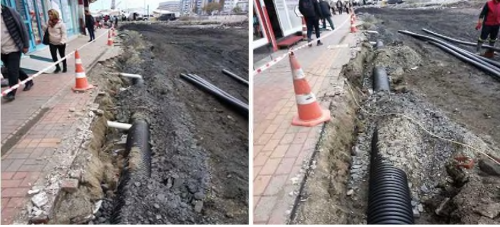
Ontemmuz Mahallesi: Belediye Bulvarı (Toplam: 100m. Kanalizasyon yenileme işi yapılmıştır.)
