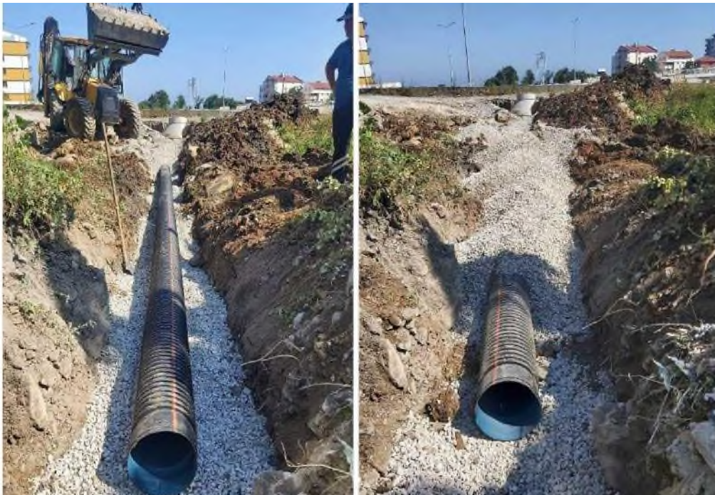
Yenimahalle: Gölbaşı Sok. (Toplam: 350m. Kanalizasyon yenileme işi yapılmıştır.)
