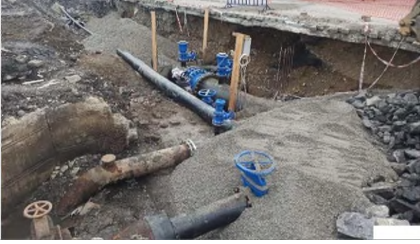
KARAEKMAS MAHALLESİ İSTASYON CADDESİ VANA ODALARININ YAPIMI
