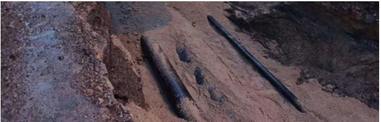
BORULARIN YATAKLAMA VE GÖMLEKLEMELERİ İCMESUYU HATLARINA UYGUN KUM DOLGU İLE YAPILMASI
