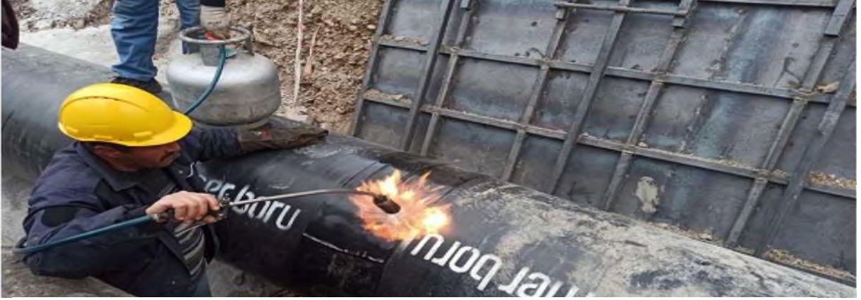
ÇELİK BORULARIN KAYNAK BÖLGELERİNİN İZOLE İLE SARIMI
