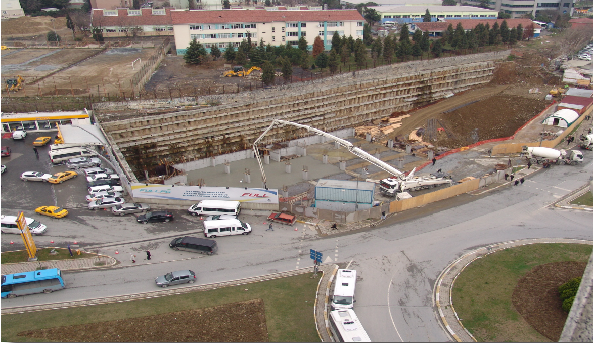
Yeni Hizmet Binası Temel İnşaatı
