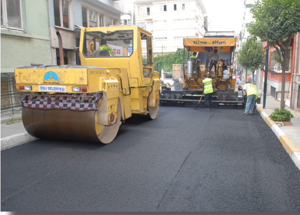
Ayazağa Asfalt Çalışması
