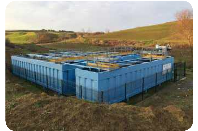
1.000 m 3 /gün kapasiteli Büyükçavuşlu Paket Atık Su Arıtma Tesisi
