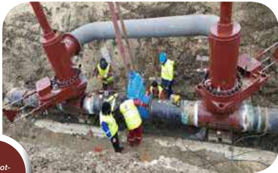
Yerli Hot-Tapping Uygulaması
