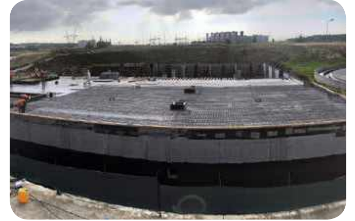
Geri Kazanım Ünitesi 1. Kısım Döşeme Kalıp İmalatı ve Donatı Montajı
