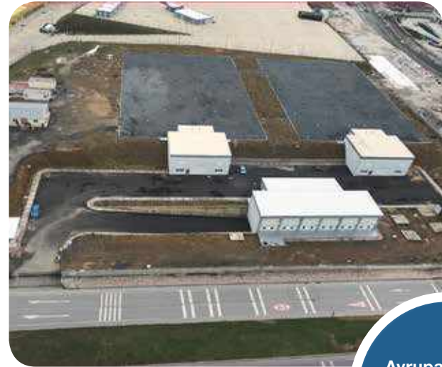
Avrupa Bölgesi 25.Kısım Müteferrik İçme Suyu İnşaatı
