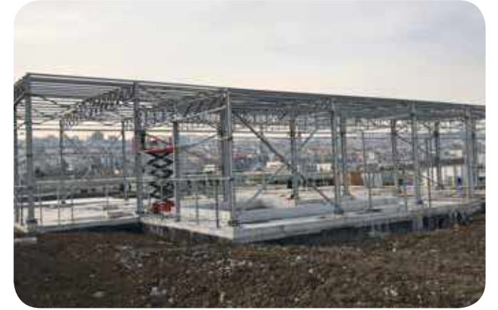
Geri Kazanım Ünitesi 1. Kısım Döşeme Kalıp İmalatı ve Donatı Montajı
