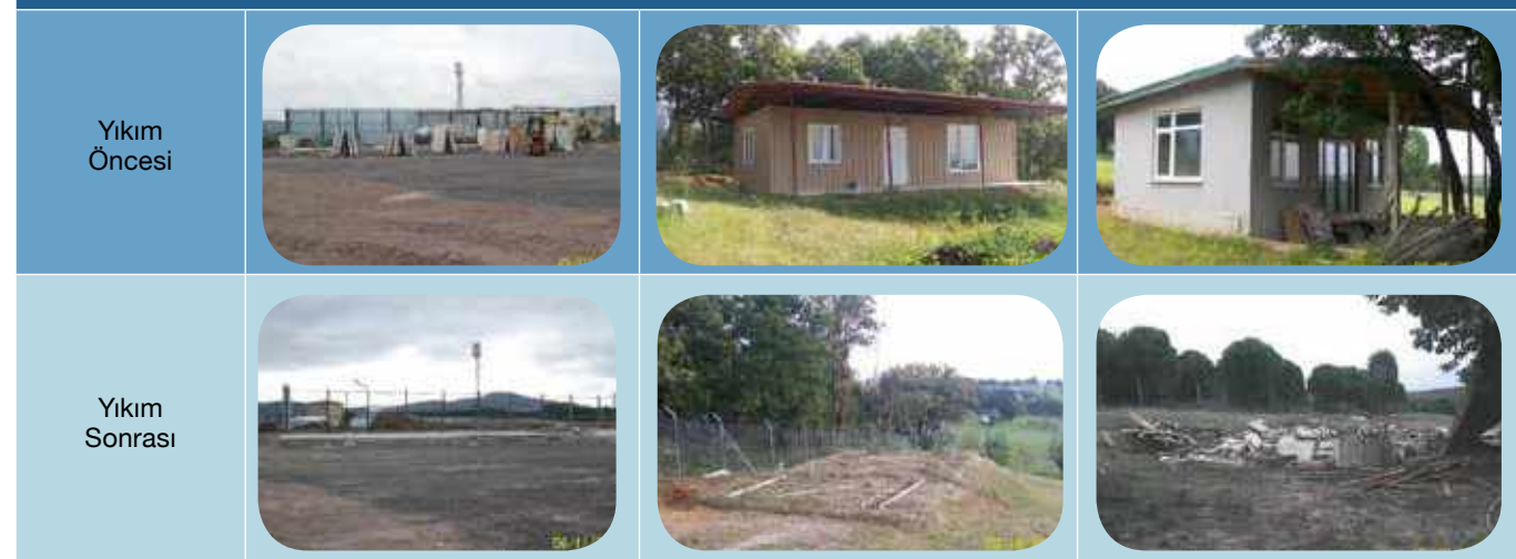
Yıkım Gerçekleştirilen Yapılardan Görünüm
