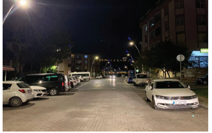
Cumhuriyet Mahallesi Kemerdere Caddesi Aydınlatma Çalışması
