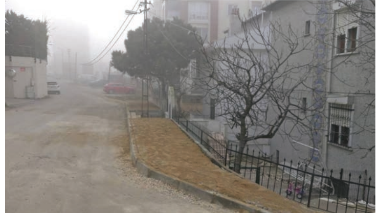
PINARTEPE MAHALLESİ NEDİME SOKAK KALDIRIM ÇALIŞMASI
