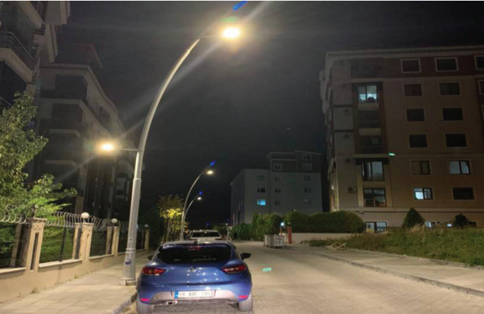
Pınartepesi Mahallesi Akboğa Sokak Aydınlatma Çalışması
