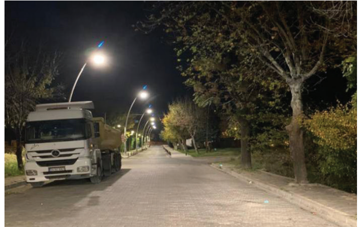
Ulus Mahallesi Bayrak Caddesi Aydınlatma Çalışması
