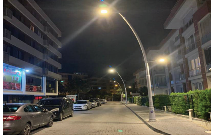
Pınartepesi Mahallesi Mayıs Sokak Aydınlatma Çalışması
