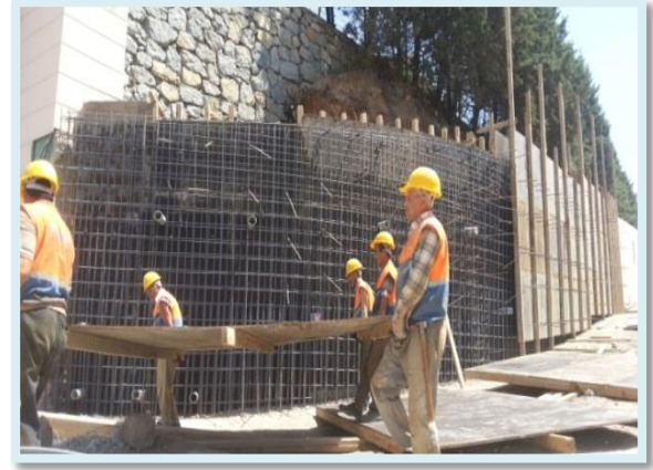
Betonarme Duvar Çalışması
