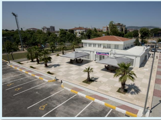
Spor Koordinasyon Binası
