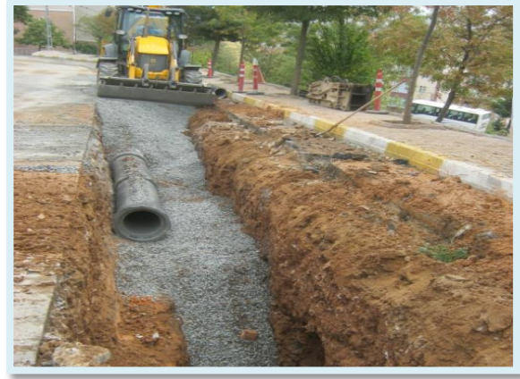
Yağmur Suyu Kanalı Çalışması
