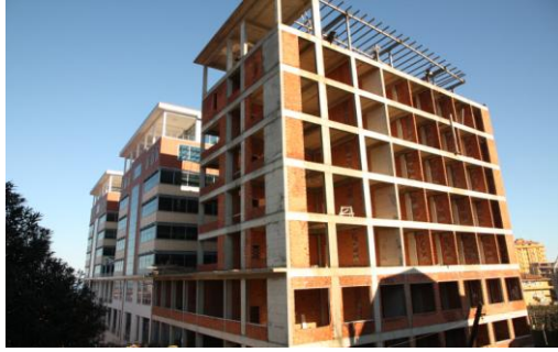
C Blok İnşaatı
