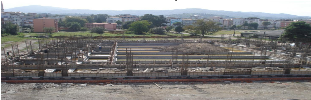
Ardeşen Meslek Yüksekokulu Kapalı Spor Salonu İnşaatı
