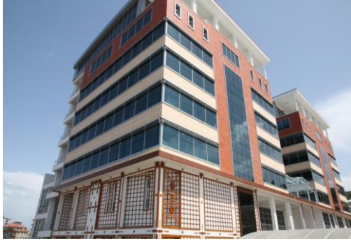
A ve B Blokların İnşaatı
