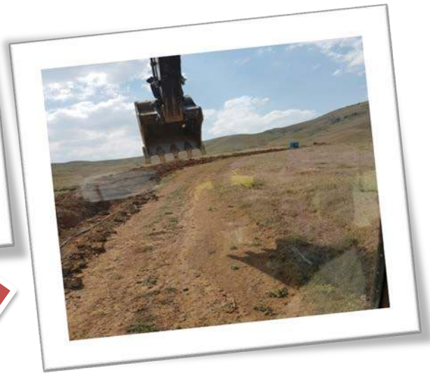
GÜNEYDERE KÖYÜ İÇME SUYU İSALE HATTI YAPIMI
