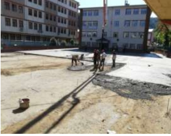
Saha Betonu Çalışması:
