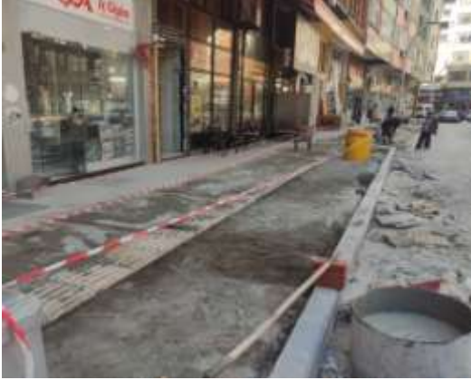
Granit Kaldırım Çalışması:
