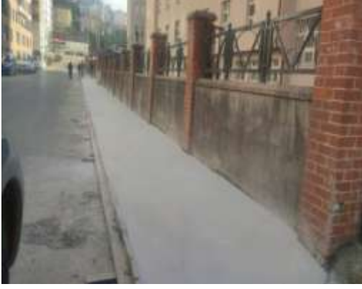
Beton Kaldırım Çalışması:
