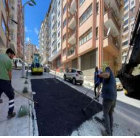
Asfalt Yama Çalışması:
