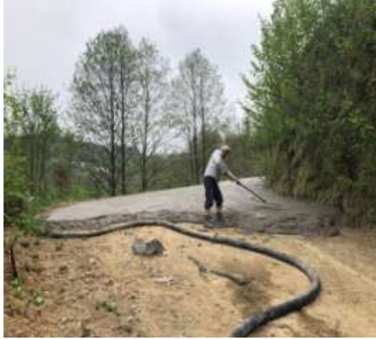
Yol Betonu Çalışması:
