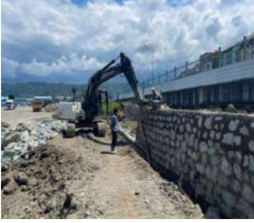
Taş Duvar Çalışması:
