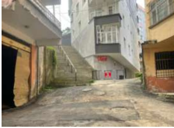
Asfalt Yama Çalışması:
