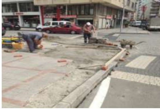
Granit Kaldırım Çalışması:
