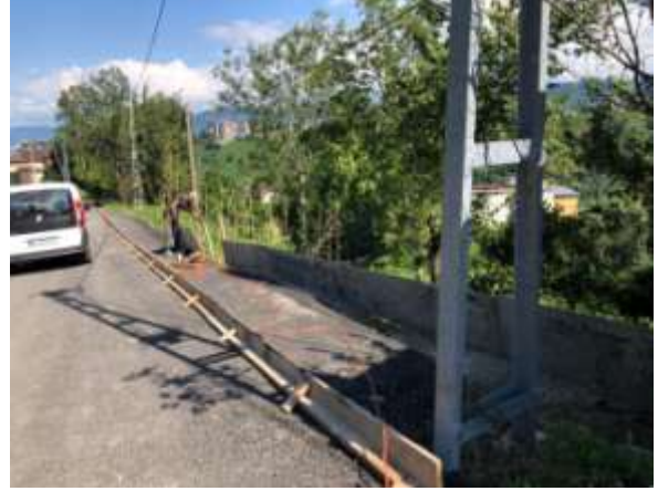
Beton Kaldırım Çalışması:
