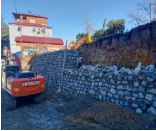
Taş Duvar Çalışması:
