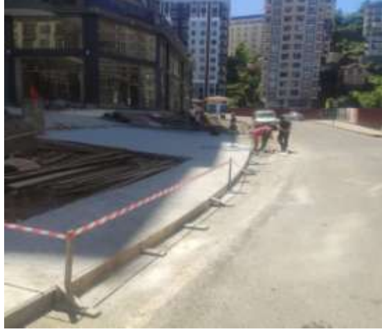
Beton Kaldırım Çalışması:
