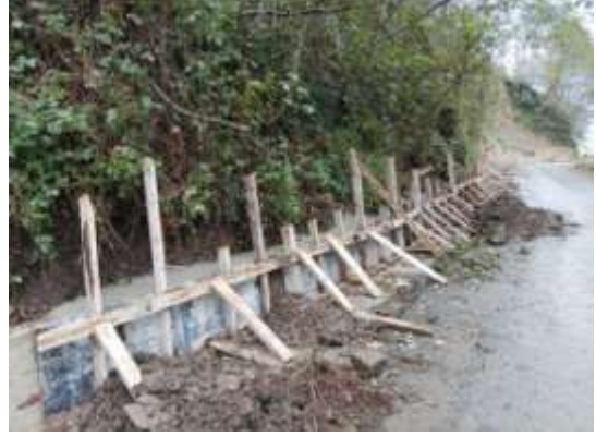
Perde Duvar Çalışması:
