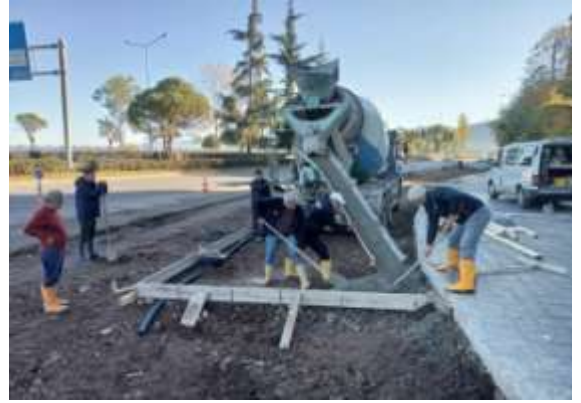
Kaldırım Beton Çalışması:
