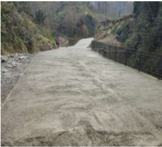
Yol Betonu Çalışması:
