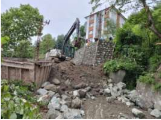
Taş Duvar Çalışması:
