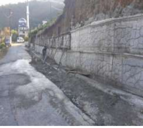
Perde Duvar Çalışması:
