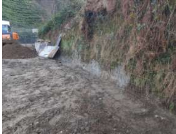
Perde Duvar Çalışması:
