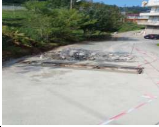
Yağmursuyu Mazgal Çalışması:
