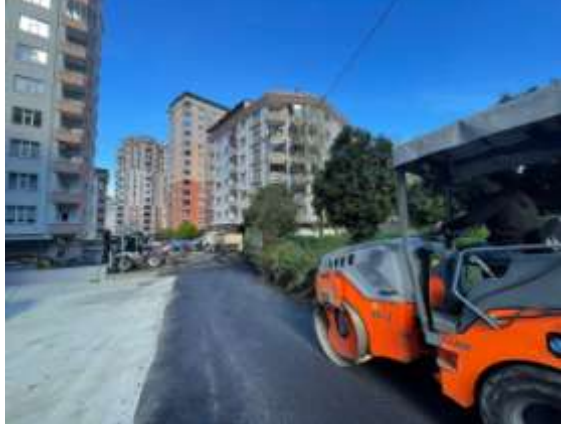
Asfalt Yama Çalışması:
