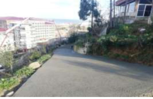
Yol Betonu Çalışması:
