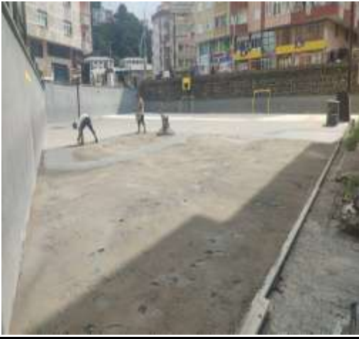
Saha Beton Çalışması:
