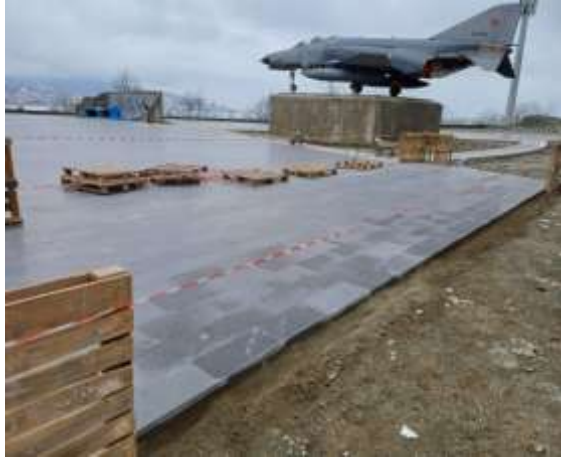
Zemin Taş Kaplama Çalışması:
