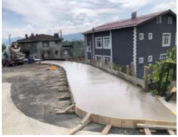
Beton Kaldırım Çalışması:
