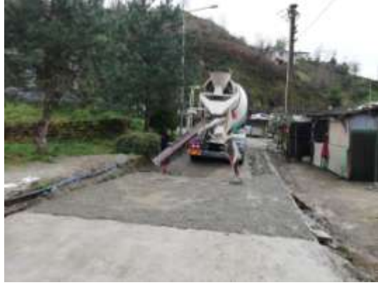
Yol Betonu Çalışması:
