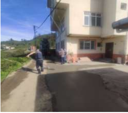
Yol Betonu Yama Çalışması:
