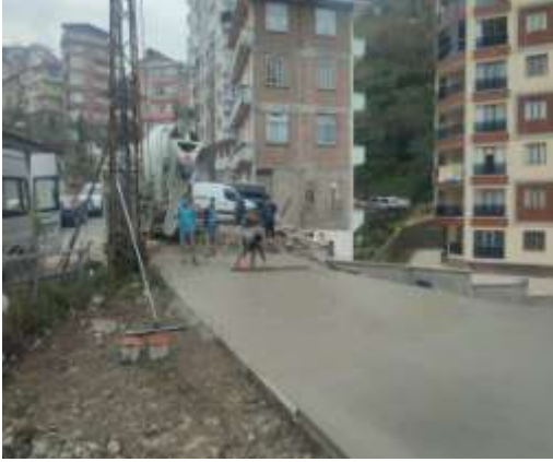
Yol Betonu Çalışması:
