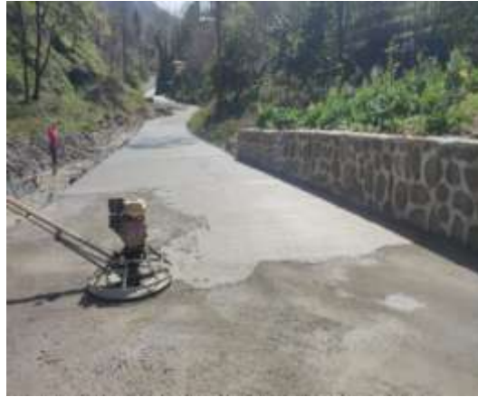
Yol Betonu Çalışması:
