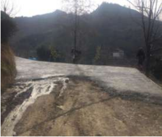
Yol Betonlama Çalışması :
