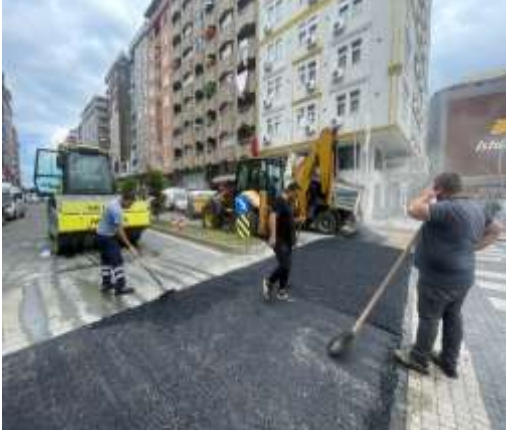
Asfalt Yama Çalışması:
