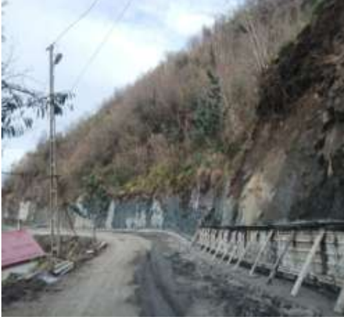
Perde Duvar Çalışması:
