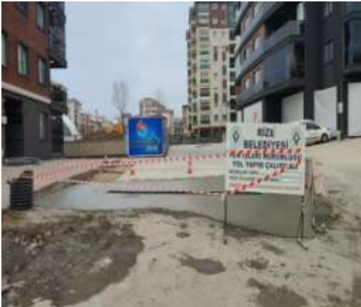
Yağmursuyu Mazgal Çalışması:
