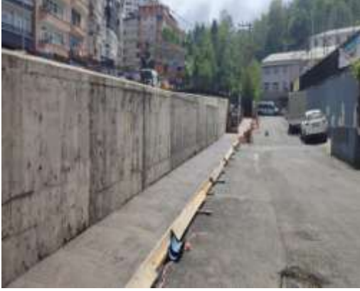
Beton Kaldırım Çalışması:
