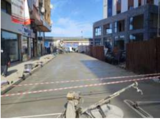
Yol Betonu Çalışması:
