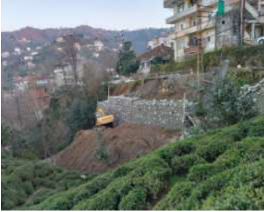
Taş Duvar Çalışması:
