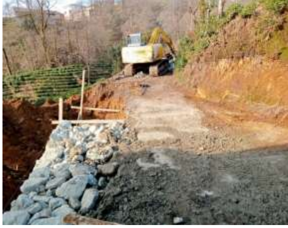
Yol Geniřletme ve Tař Duvar Çalışması:
