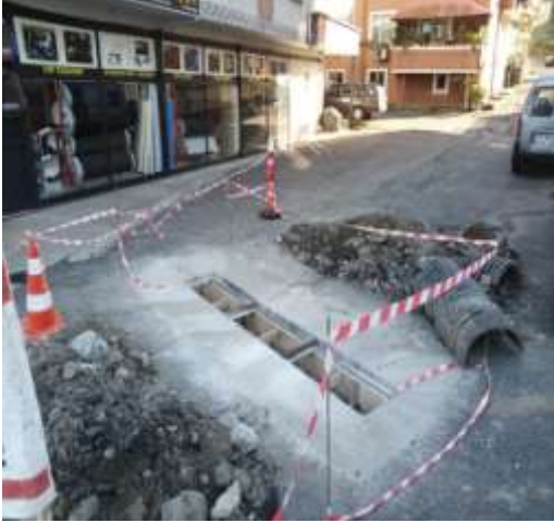
Yağmursuyu Mazgal Çalışması:
