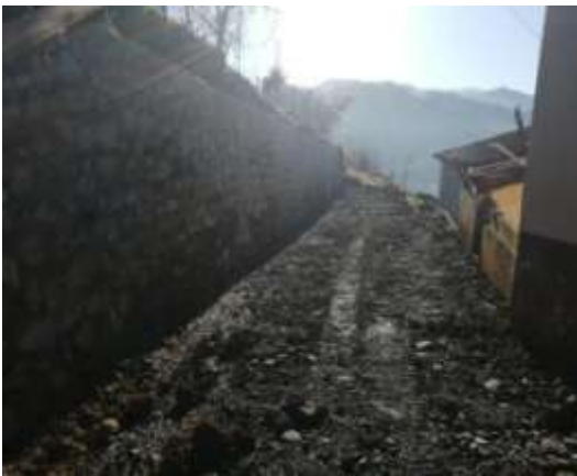
Taş Duvar Çalışması:
