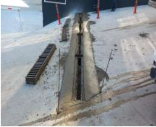
Yağmursuyu Mazgal Çalışması:
