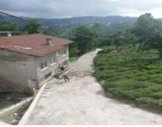
Yol Betonu Çalışması:
