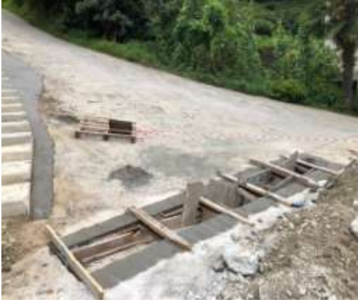
Yağmursuyu Mazgal Çalışması:
