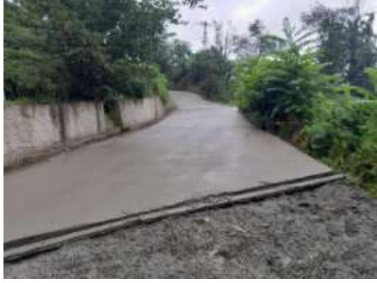
Yol Betonu Çalışması:
