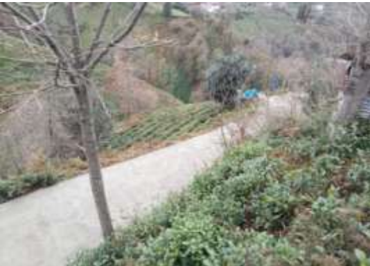
Yol Betonu Çalışması:
