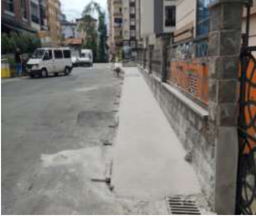
Beton Kaldırım Çalışması:
