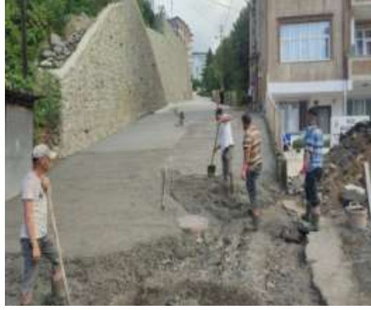
Yol Betonu Çalışması:
