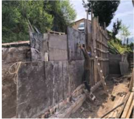
Perde Duvar Çalışması:
