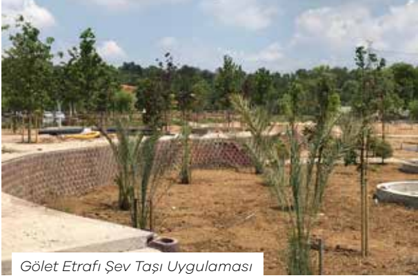
Gölet Etrafı Şev Taşı Uygulaması
